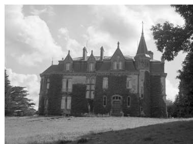
Elévation nord : vue générale Phot. Guy Artur, Phot. Norbert Lambart IVR53_19812900627X
