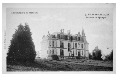
Vue générale Phot. Elise Lauranceau IVR53_20042905621NUCB
