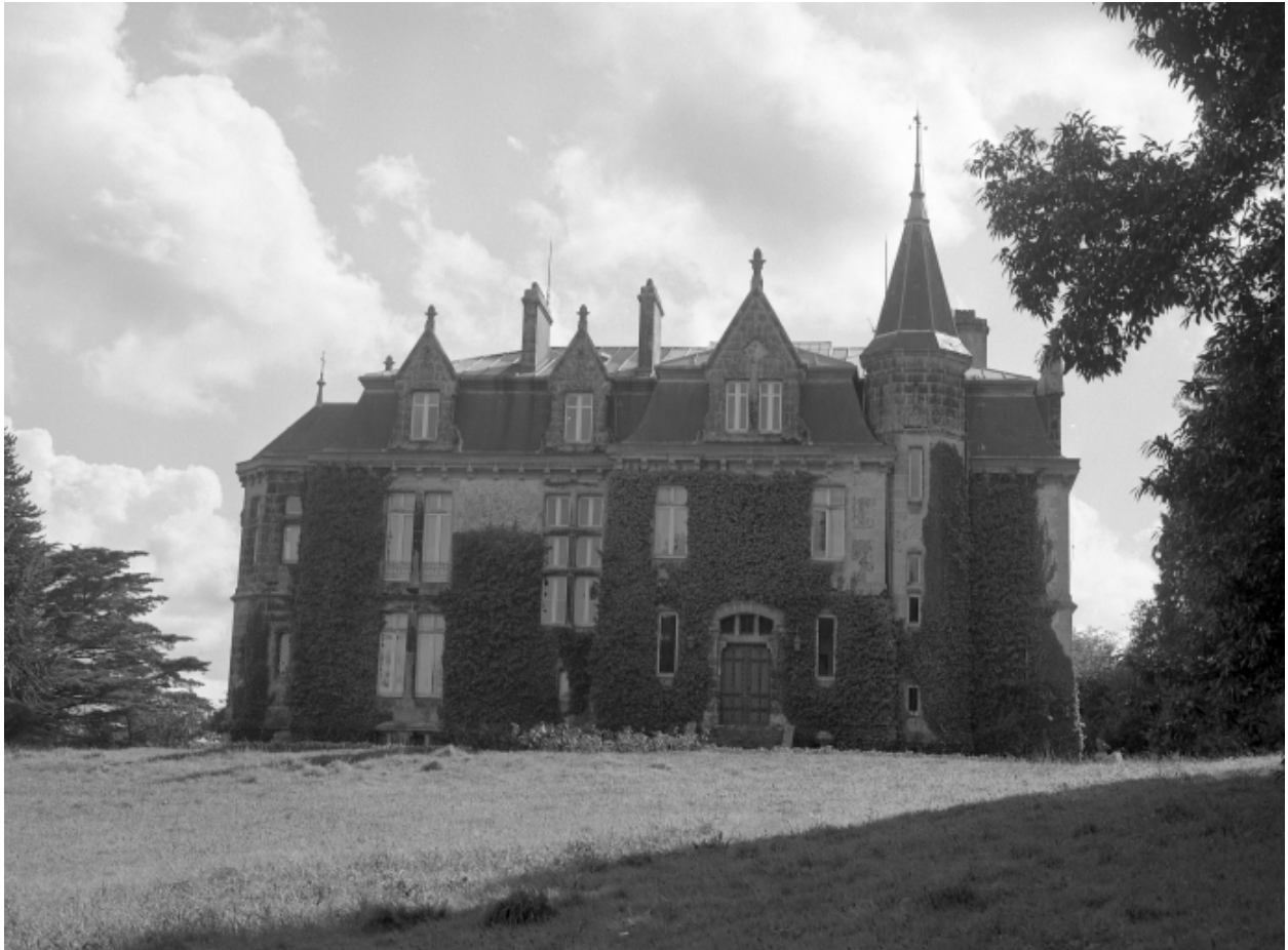
Elévation nord : vue générale
