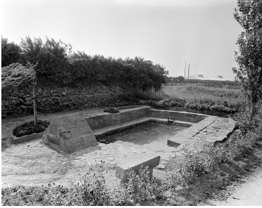
Vue générale prise de l'ouest Phot. Guy Artur, Phot. Norbert Lambart IVR53_19852901105X
