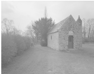
Elévation Ouest : vue générale Phot. Bernard Bègne, Phot. M. Loyon IVR53_19933500264X
