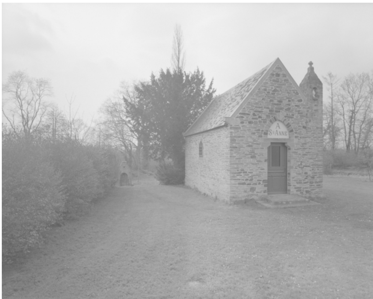
Elévation Ouest : vue générale
