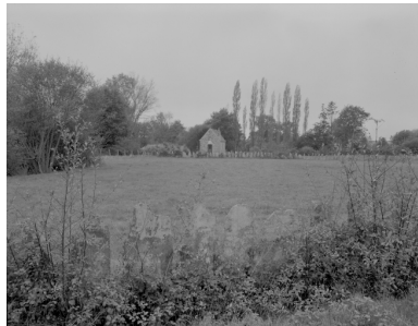
Elévation ouest : vue de situation Phot. Guy Artur IVR53_19793500219X
