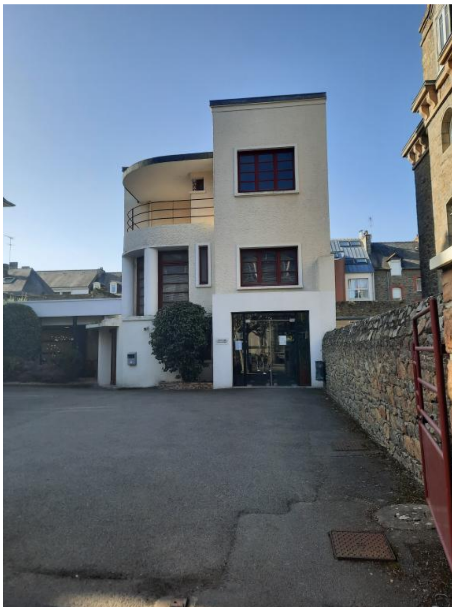
Façade principale sur rue
