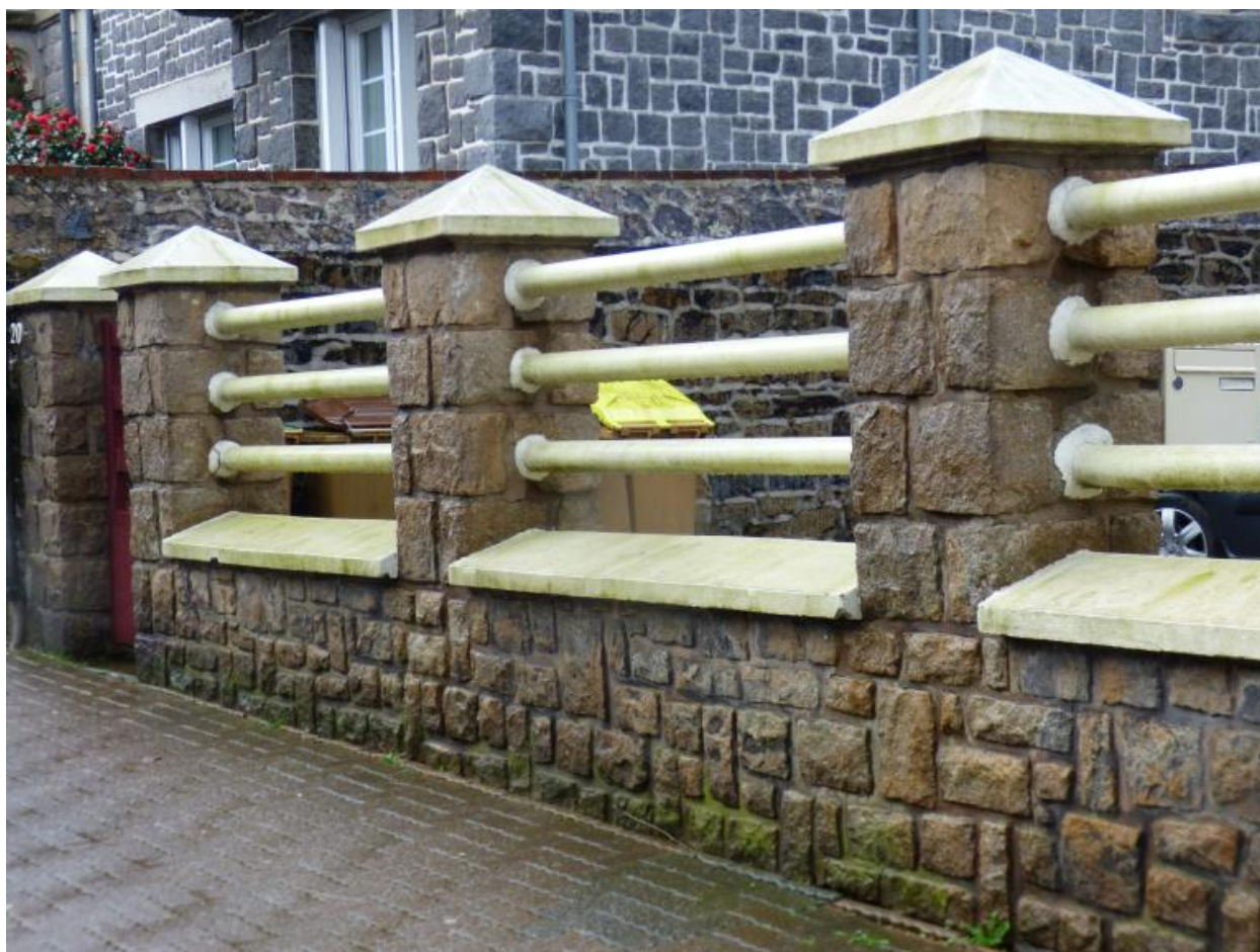
Vue du mur de clôture et de son barreaudage sur le boulevard Clémenceau
