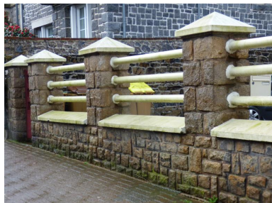
Vue du mur de clôture et de son barreaudage sur le boulevard Clémenceau Phot. Eve Pellat Pagé IVR53_2022206089NUCA
