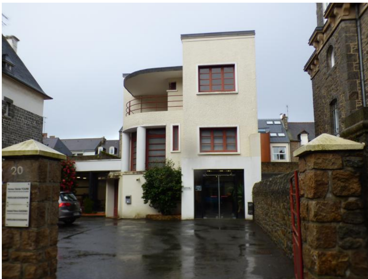
Vue de la façade principale depuis le boulevard Clémenceau
