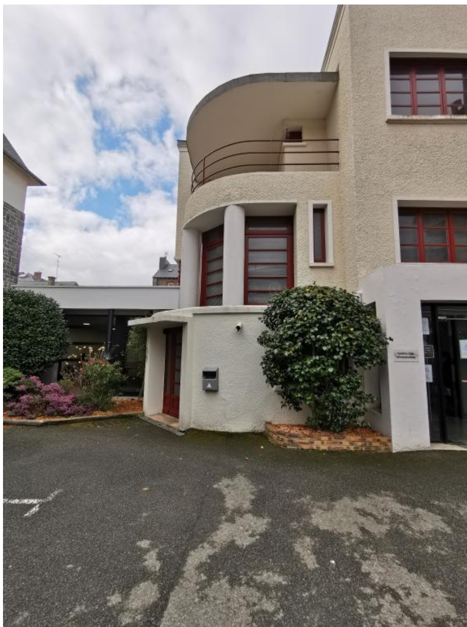
Vue de l'ancienne entrée d'angle transformée
