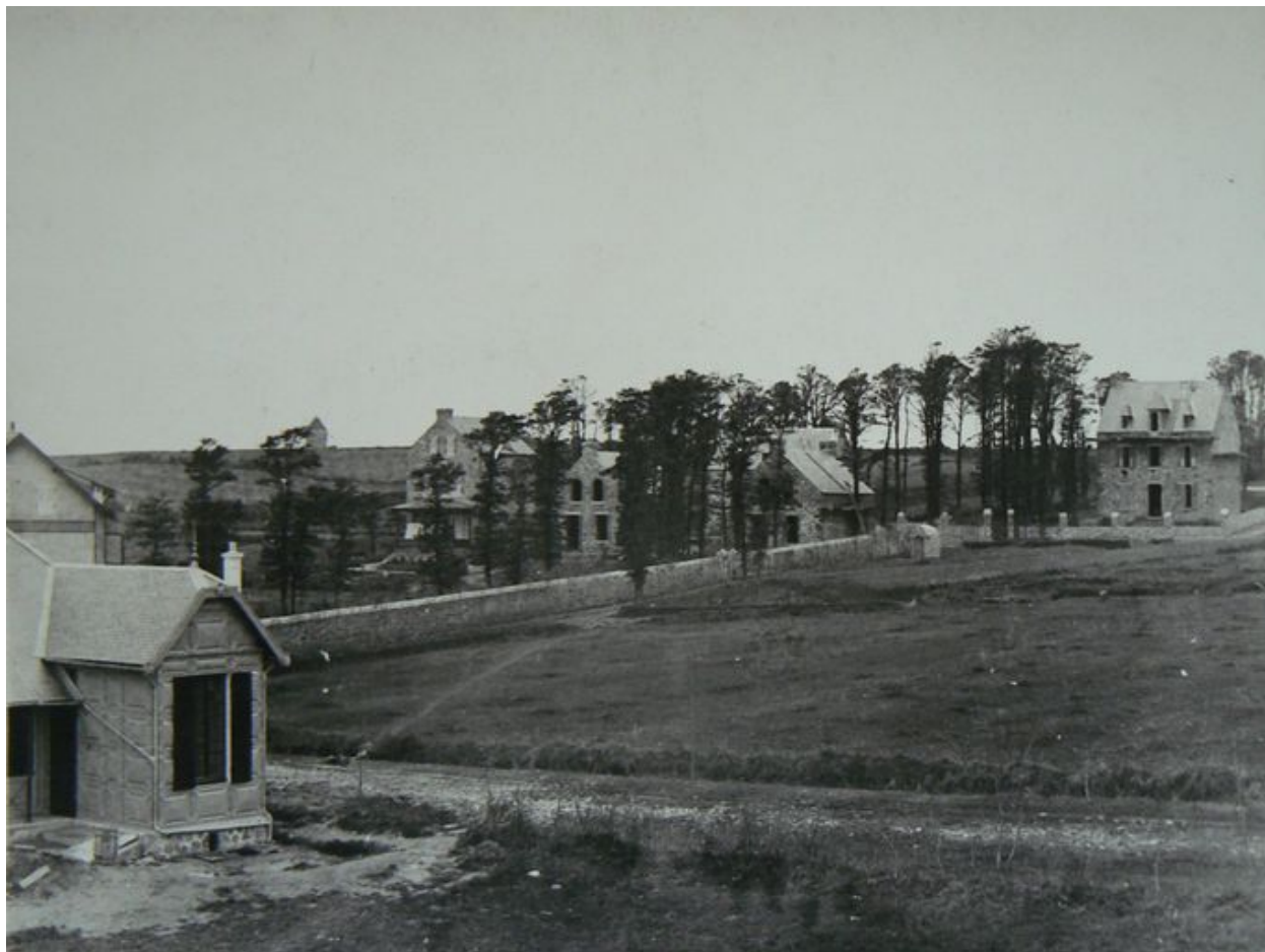
Vue ancienne de la villa Ty Huella
