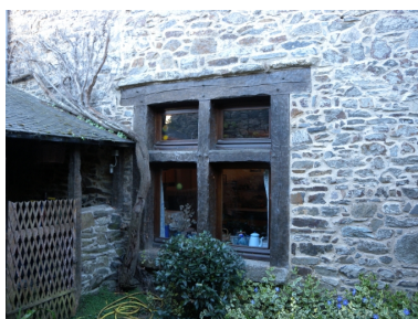
Vue du bâti annexe dans la cour intérieure et des ouvertures de l'habitation principale Phot. Guy Prigent IVR53_20082213446NUCA
