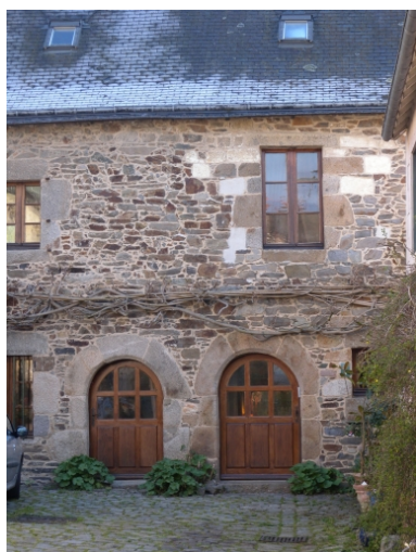
Détail de la façade antérieure Phot. Guy Prigent IVR53_20082213306NUCA
