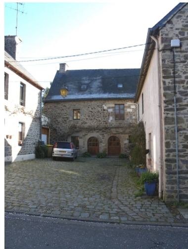
Vue générale Phot. Guy Prigent IVR53_20082213444NUCA
