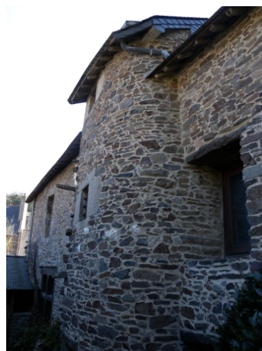
Vue de la tourelle extérieure édifiée en schiste avec les ouvertures en pierre de granite Phot. Guy Prigent IVR53_20082213445NUCA
