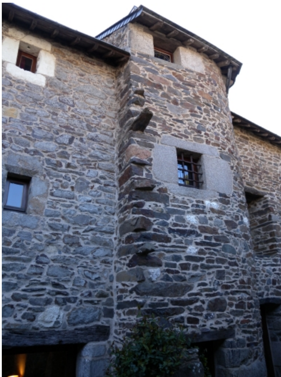
Tour enfermant l'escalier de distribution intérieur
