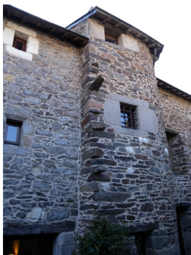
Tour enfermant l'escalier de distribution intérieur Phot. Guy Prigent IVR53_20082213308NUCA
