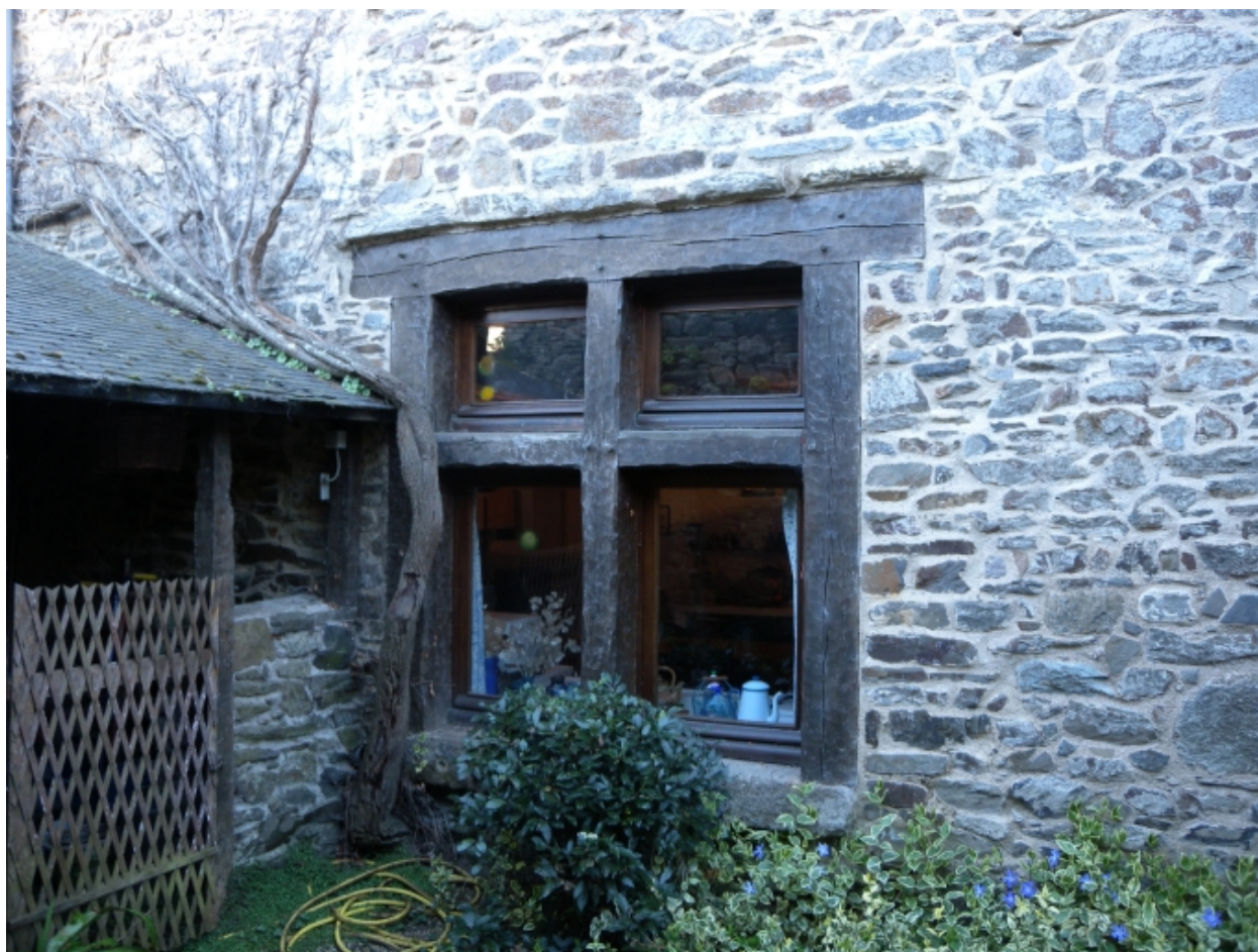
Vue du bâti annexe dans la cour intérieure et des ouvertures de l'habitation principale
