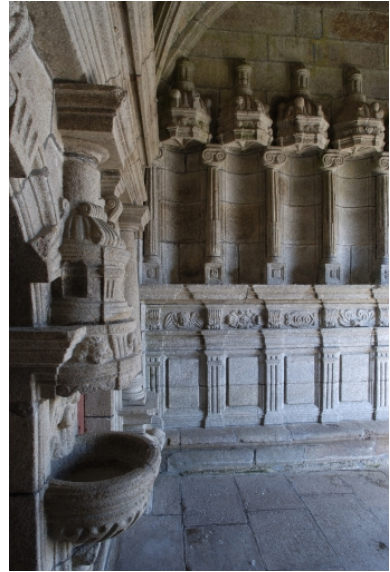
Porche sud, intérieur, mur est Phot. Bernard Bègne IVR53_20062900123NUCA
