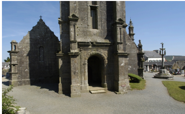
Eglise : partie inférieure de la tour occidentale et élévation ouest du bas-côté nord Phot. Bernard Bègne IVR53_20062900122NUCA
