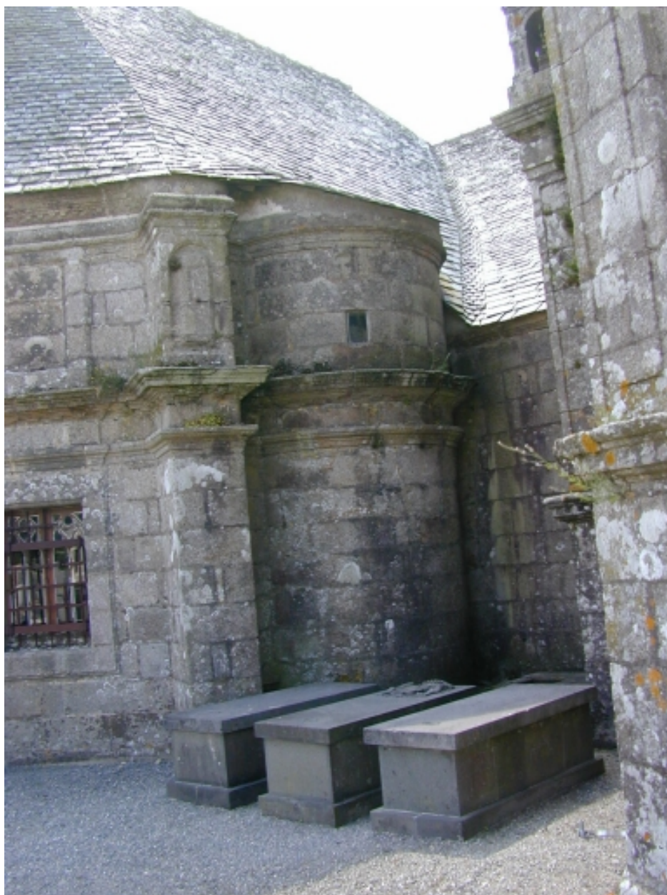
Sacristie : détail de la tourelle d'escalier
