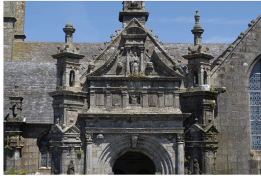
Porche sud, détail de la partie supérieure Phot. Bernard Bègne IVR53_20062900097NUCA
