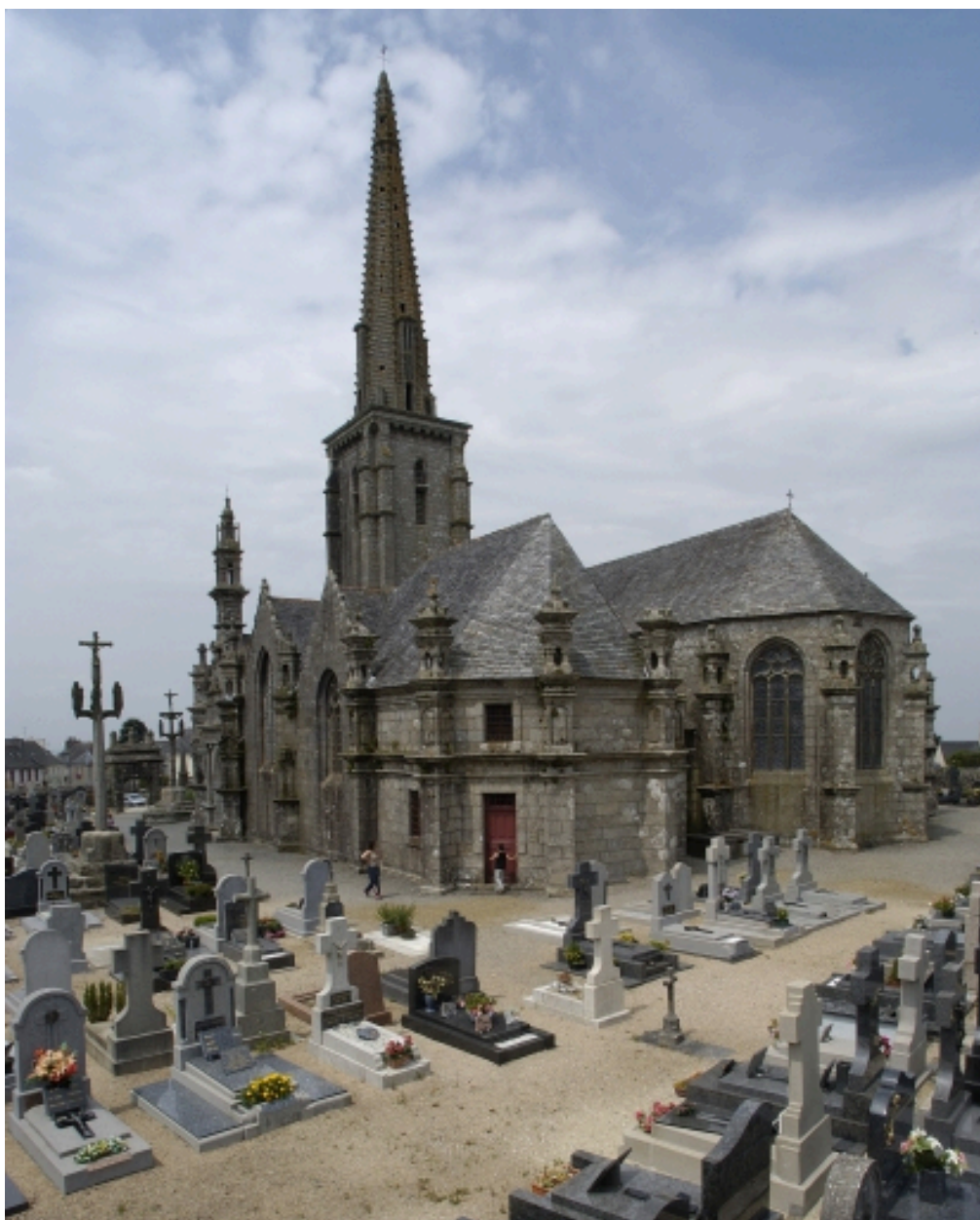
Eglise : vue générale sud-est
