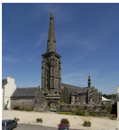
Enclos : vue générale sud-ouest Phot. Bernard Bègne IVR53_20062900115NUCA
