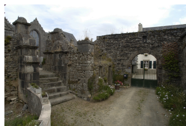
Enclos : portail sud Phot. Bernard Bègne IVR53_20062900199NUCA
