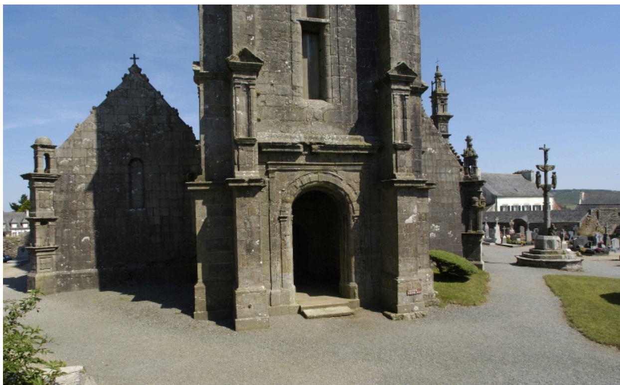
Eglise : partie inférieure de la tour occidentale et élévation ouest du bas-côté nord
