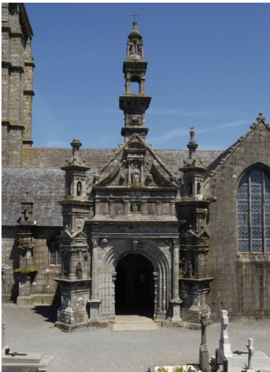
Porche sud, vue générale
