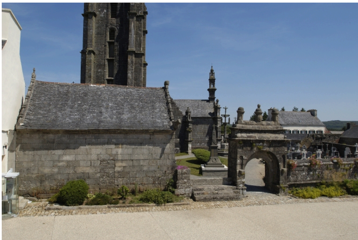
Enclos : ossuaire et arc monumental ouest
