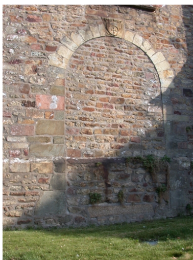
Façade sud, détail portail muré Phot. Véronique Orain IVR53_20043516593NUCA
