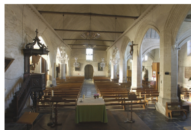
Vue intérieure prise du chœur vers la nef Phot. Alain Dagorn IVR53_20053500188NUCA
