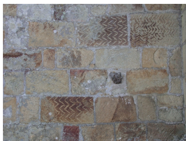
Façade nord, détail de la mise en oeuvre, pierres avec décor taillé en chevrons Phot. Véronique Orain IVR53_20043516598NUCA
