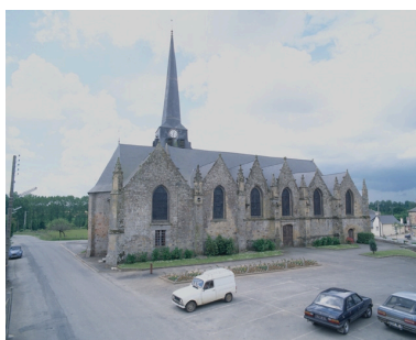
Vue générale de la façade nord Phot. Guy Artur, Phot. Norbert Lambart IVR53_19953500333XA
