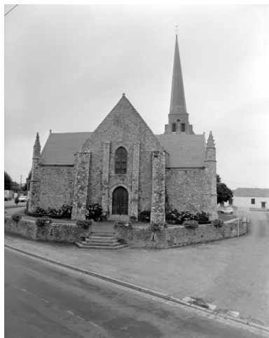
Vue générale de la façade ouest Phot. Guy Artur, Phot. Norbert Lambart IVR53_19943501492X
