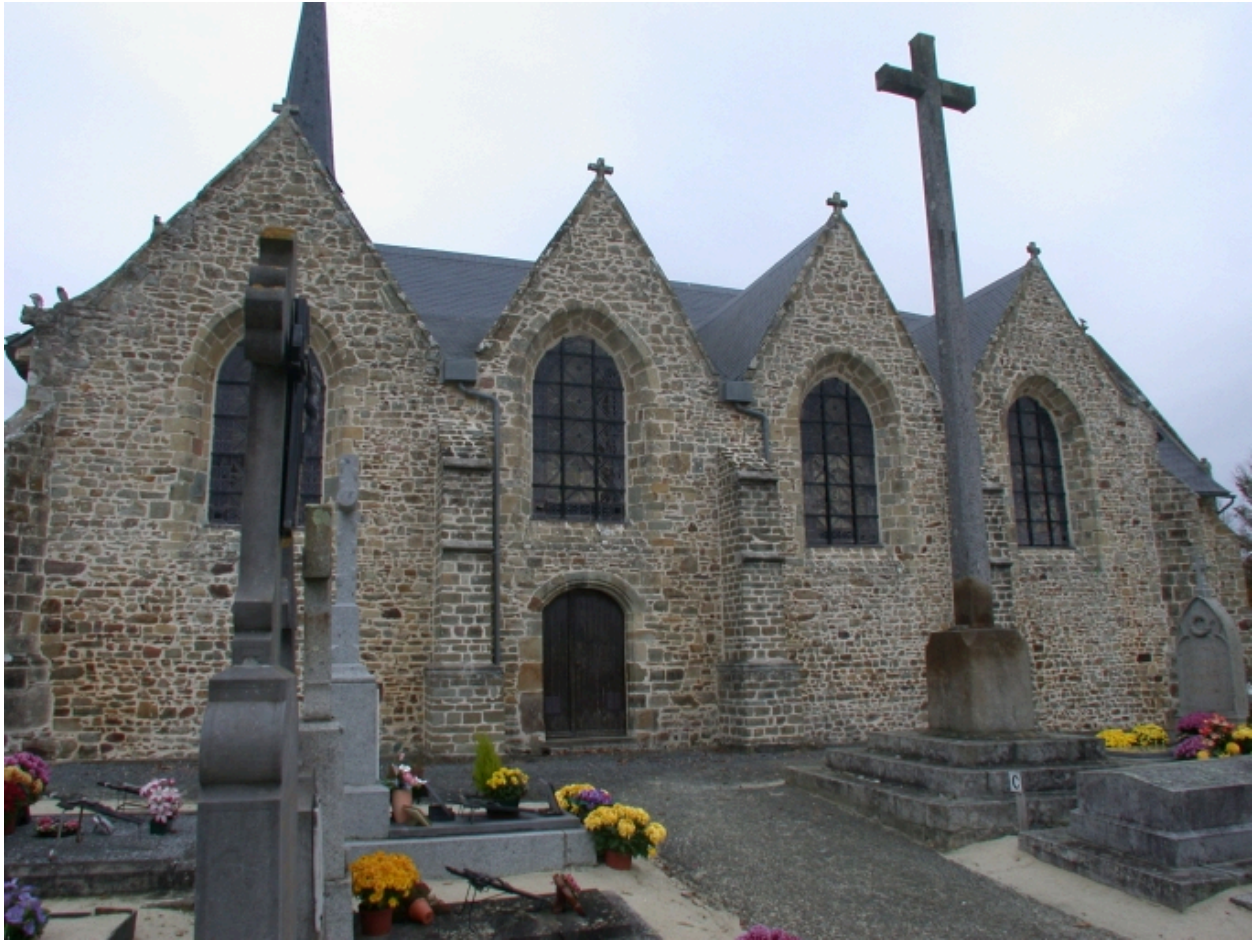
Vu générale sud
