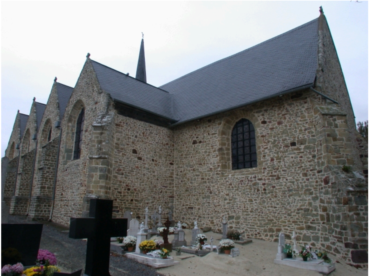
Façade sud et chevet
