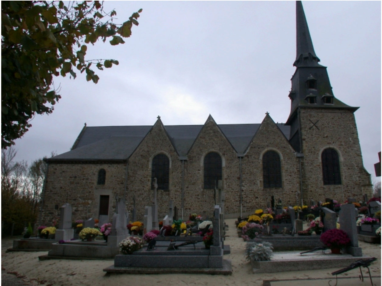
Vue générale nord
