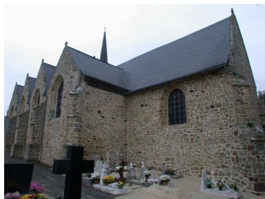
Façade sud et chevet Phot. Véronique Orain IVR53_20043512884NUCA
