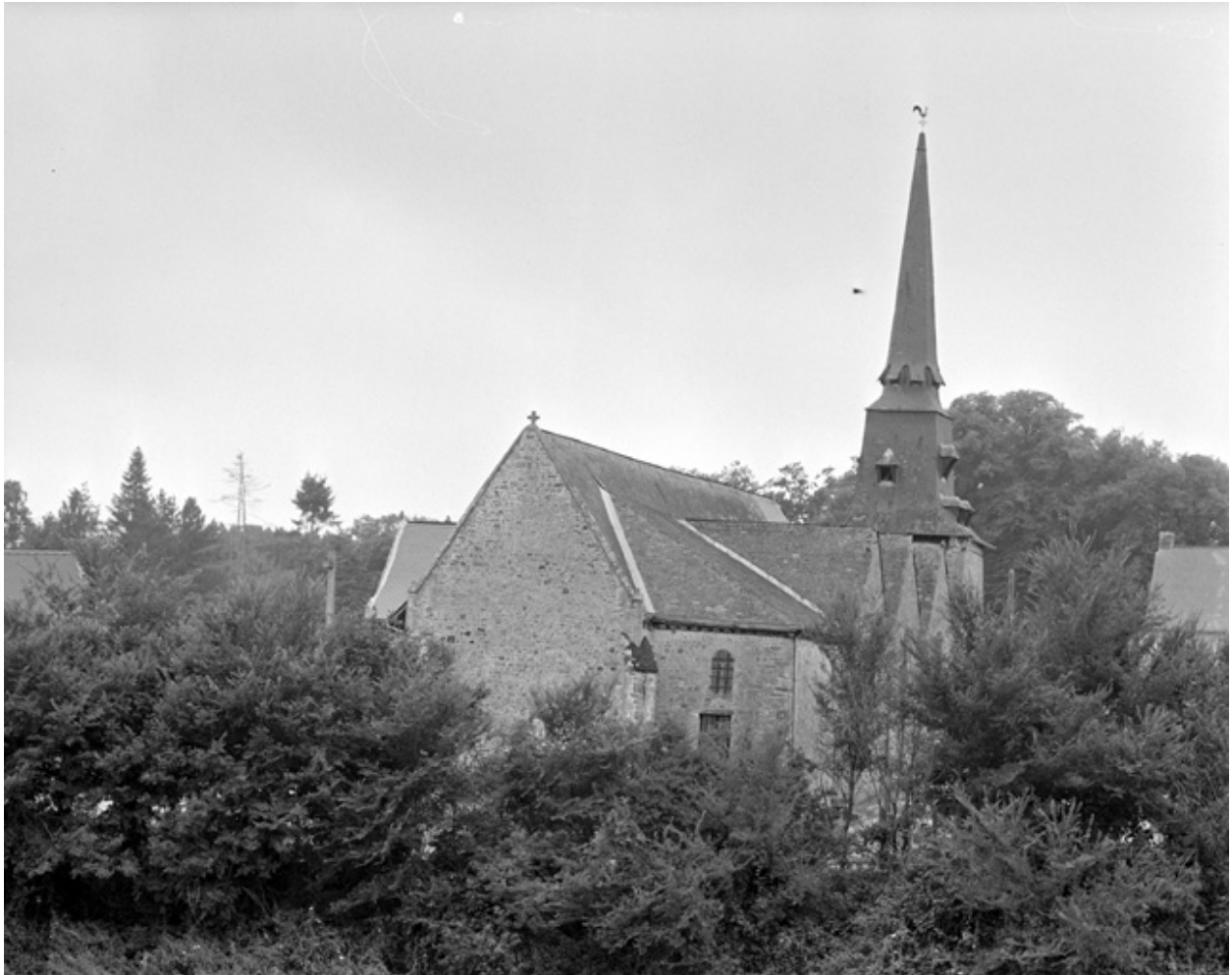
Chevet et façade nord
