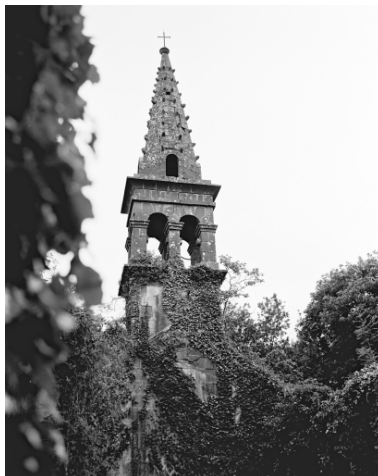
Elévation ouest Phot. Bernard Bègne IVR53_19962900565X
