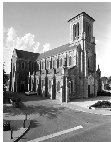
Vue générale nord-est Phot. Guy Artur, Phot. Norbert Lambart IVR53_19943501755X
