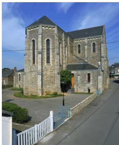
Vue générale sud
