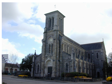
Vue générale nord-ouest Phot. Malo Pichot IVR53_20003511387NUCA
