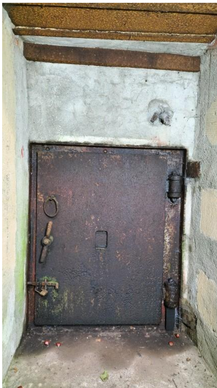
Vue de la porte blindée du bunker-citerne
