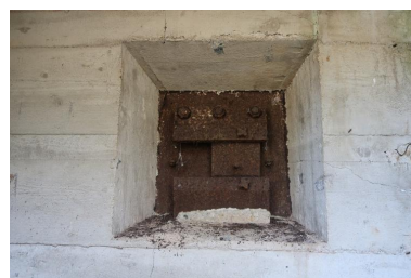
Vue du bunker-cuve de type Fl243a (V) pour canon antiaérien de 10.5 cm : ouverture de tir protégée par un volet blindé depuis l'intérieur. Cette ouverture de tir servait à protéger l'entrée de la cuve qui est orientée vers le sud Phot. Guillaume Lécueillier IVR53_20255632861NUCA
