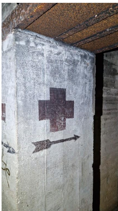
Vue intérieure du bunker-puits de direction de tir de type Fl244 SK pour télémètre : flèche peinte en noir et croix rouge indiquant l'infirmerie Phot. Guillaume Lécueillier IVR53_20255632954NUCA
