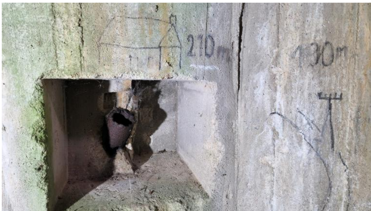
Vue intérieure du bunker-abri de type 621 pour un groupe de combat : poste d'observation. Sur le mur est peint un panorama de tir. Dans la petite niche murale, se trouve un tuyau acoustique relié à la salle de garde
