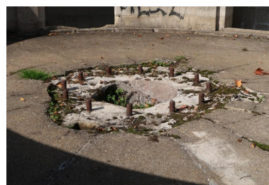
Vue du bunker-cuve de type Fl243a (III) pour canon antiaérien de 10.5 cm : emplacement du canon avec ses douze tiges filetées Phot. Guillaume Lécueillier IVR53_20255632850NUCA
