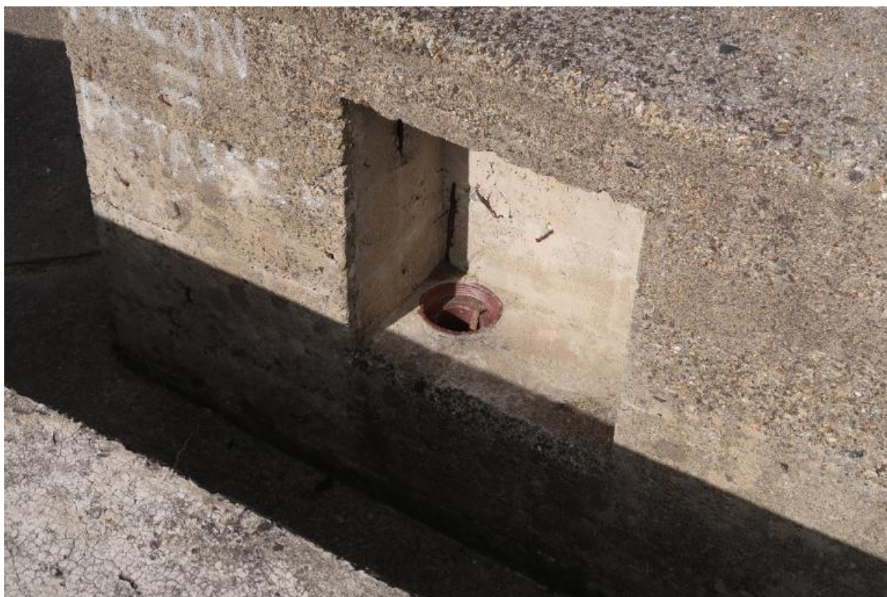
Vue du bunker-cuve de type Fl243a (IV) pour canon antiaérien de 10.5 cm : niche murale de l'entrée
