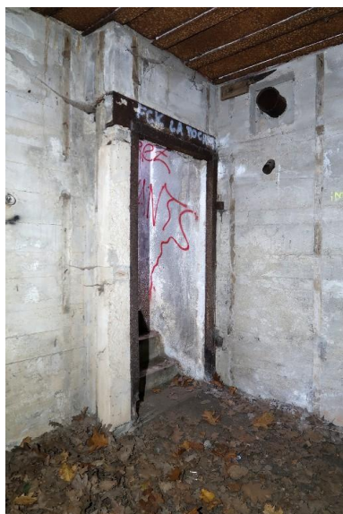
Vue du bunker-poste de direction de tir de type FI229 pour télémètre : débouché de l'escalier desservant les salles de calculs et des opérations. Près du plafond, vestiges des voliges clouées au mur. Les murs sont peints en blanc Phot. Guillaume Lécueillier IVR53_20255632978NUCA
