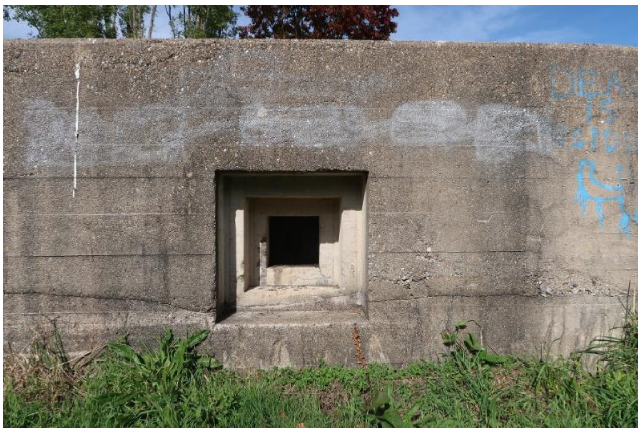
Vue du bunker-cuve de type Fl243a (III) pour canon antiaérien de 10.5 cm : ouverture de tir en gradin depuis l'extérieur. Cette ouverture de tir servait à protéger l'entrée de la cuve qui est orientée vers le sud
