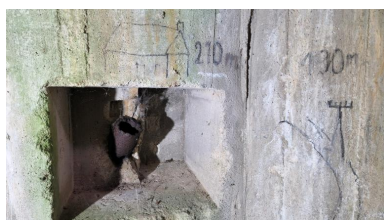
Vue intérieure du bunker-abri de type 621 pour un groupe de combat : poste d'observation. Sur le mur est peint un panorama de tir. Dans la petite niche murale, se trouve un tuyau acoustique relié à la salle de garde Phot. Guillaume Lécueillier IVR53_20255632992NUCA
