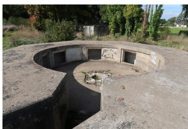
Vue du bunker-cuve de type Fl243a (III) pour canon antiaérien de 10.5 cm depuis le sud-est : au premier plan, l'entrée orientée vers le sud ; autour de la cuve circulaire sont implantées sept niches-abris pour les soldats et les munitions Phot. Guillaume Lécueillier IVR53_20255632847NUCA
