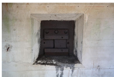
Vue du bunker-cuve de type Fl243a (III) pour canon antiaérien de 10.5 cm : ouverture de tir protégée par un volet blindé depuis l'intérieur. Cette ouverture de tir servait à protéger l'entrée de la cuve qui est orientée vers le sud Phot. Guillaume Lécueillier IVR53_20255632846NUCA
