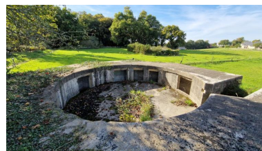
Vue intérieure du bunker-cuve de type Fl243a (II) pour canon antiaérien de 10.5 cm depuis l'est : à droite, l'entrée orientée vers le nord ; autour de la cuve circulaire sont implantées sept niches-abris pour les soldats et les munitions Phot. Guillaume Lécueillier IVR53_20255632836NUCA
