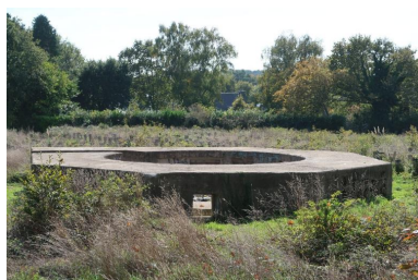
Vue du bunker-cuve de type Fl243a (IV) pour canon antiaérien de 10.5 cm depuis le nord Phot. Guillaume Lécueillier IVR53_20255632863NUCA
