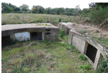
Vue du bunker-cuve de type Fl243a (V) pour canon antiaérien de 10.5 cm : au centre, l'entrée orientée vers le sud ; à gauche de l'entrée, petit espace abritant l'ouverture de tir défendant l'entrée ; autour de la cuve circulaire sont implantées sept niches Phot. Guillaume Lécueillier IVR53_20255632860NUCA
