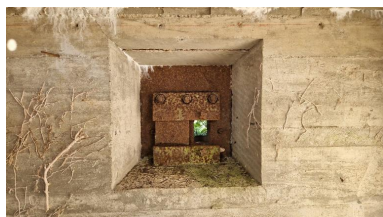
Vue du bunker-cuve de type Fl243a (II) pour canon antiaérien de 10.5 cm : ouverture de tir protégée par un volet blindé depuis l'intérieur. Cette ouverture de tir servait à protéger l'entrée de la cuve qui est orientée vers le nord Phot. Guillaume Lécueillier IVR53_20255632838NUCA
