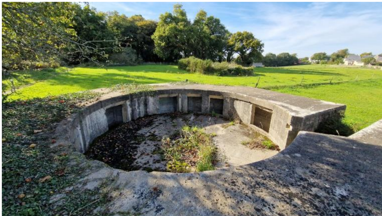
Vue intérieure du bunker-cuve de type Fl243a (II) pour canon antiaérien de 10.5 cm depuis l'est : à droite, l'entrée orientée vers le nord ; autour de la cuve circulaire sont implantées sept niches-abris pour les soldats et les munitions
