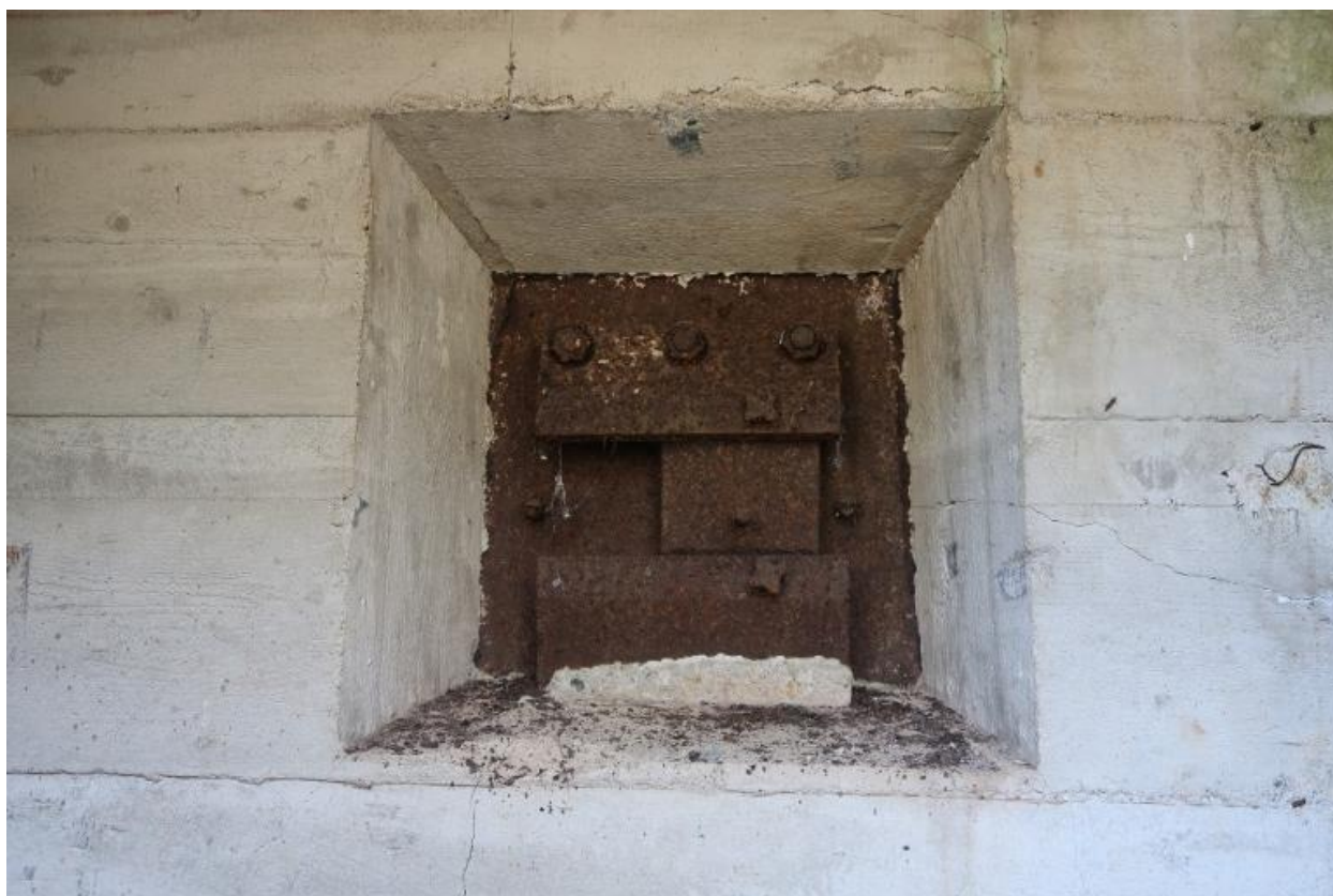
Vue du bunker-cuve de type Fl243a (V) pour canon antiaérien de 10.5 cm : ouverture de tir protégée par un volet blindé depuis l'intérieur. Cette ouverture de tir servait à protéger l'entrée de la cuve qui est orientée vers le sud
