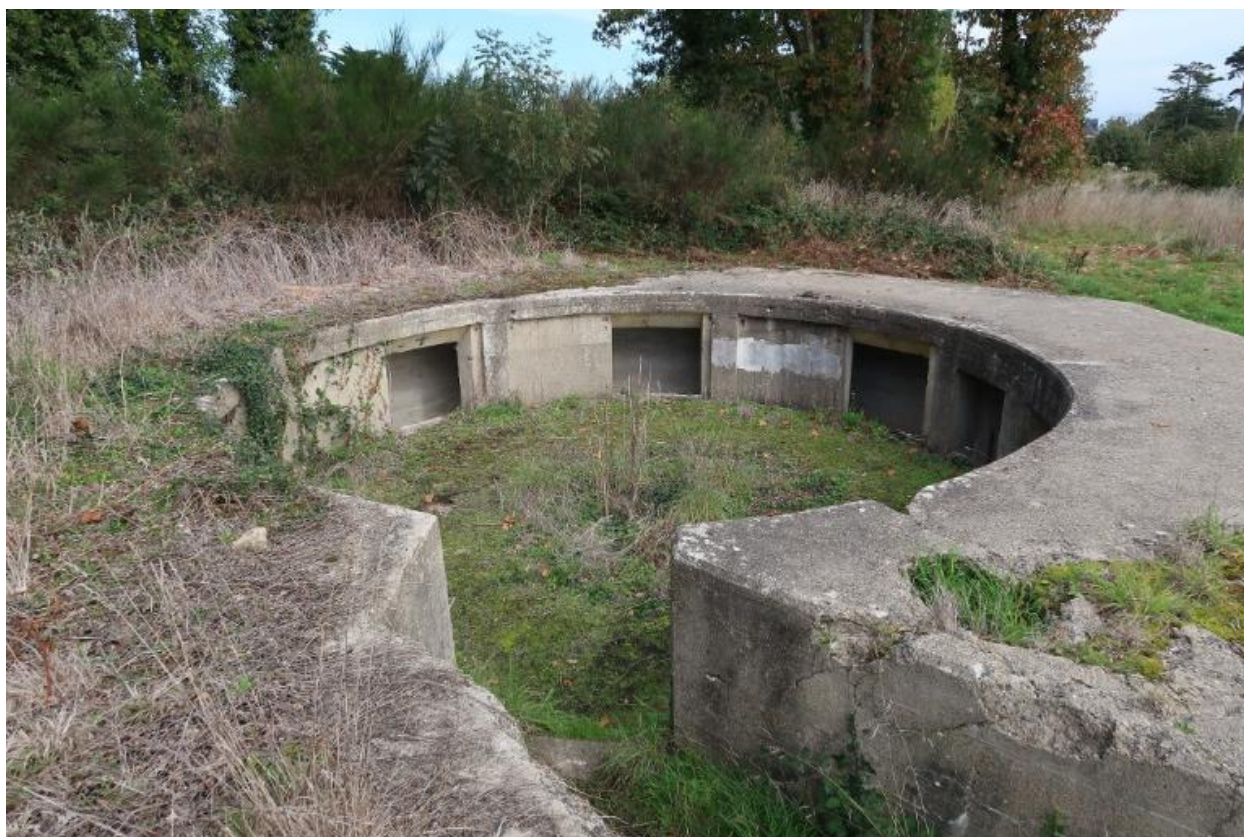
Vue du bunker-cuve de type FI243a (V) pour canon antiaérien de 10.5 cm depuis le sud-ouest : au premier plan, l'entrée orientée vers le sud ; autour de la cuve circulaire sont implantées sept niches-abris pour les soldats et les munitions
