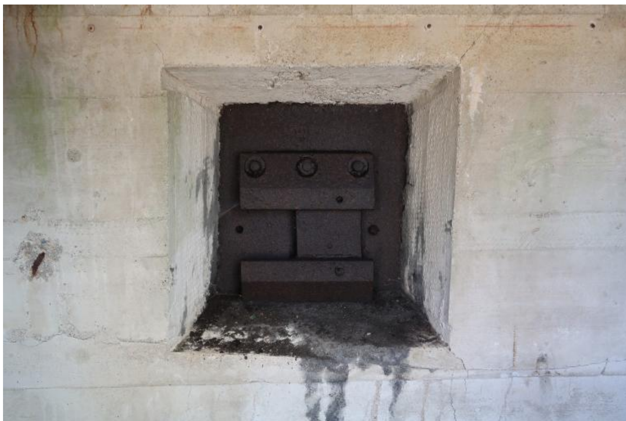
Vue du bunker-cuve de type Fl243a (III) pour canon antiaérien de 10.5 cm : ouverture de tir protégée par un volet blindé depuis l'intérieur. Cette ouverture de tir servait à protéger l'entrée de la cuve qui est orientée vers le sud
