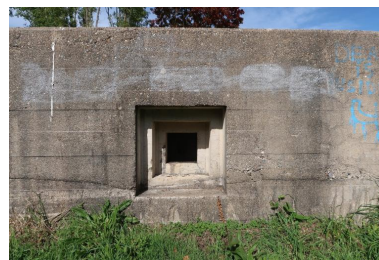
Vue du bunker-cuve de type Fl243a (III) pour canon antiaérien de 10.5 cm : ouverture de tir en gradin depuis l'extérieur. Cette ouverture de tir servait à protéger l'entrée de la cuve qui est orientée vers le sud Phot. Guillaume Lécueillier IVR53_20255632845NUCA
