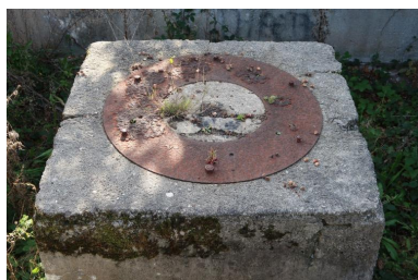
Vue intérieure du bunker-cuve pour canon antiaérien. Au centre, sous-sellette d'affût sur son socle en béton armé
