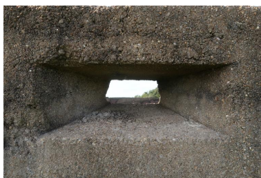
Vue du bunker-cuve sud pour canon antiaérien : ouverture de tir axiale dans l'élévation est. Les élévations est, sud et ouest sont percées d'une
