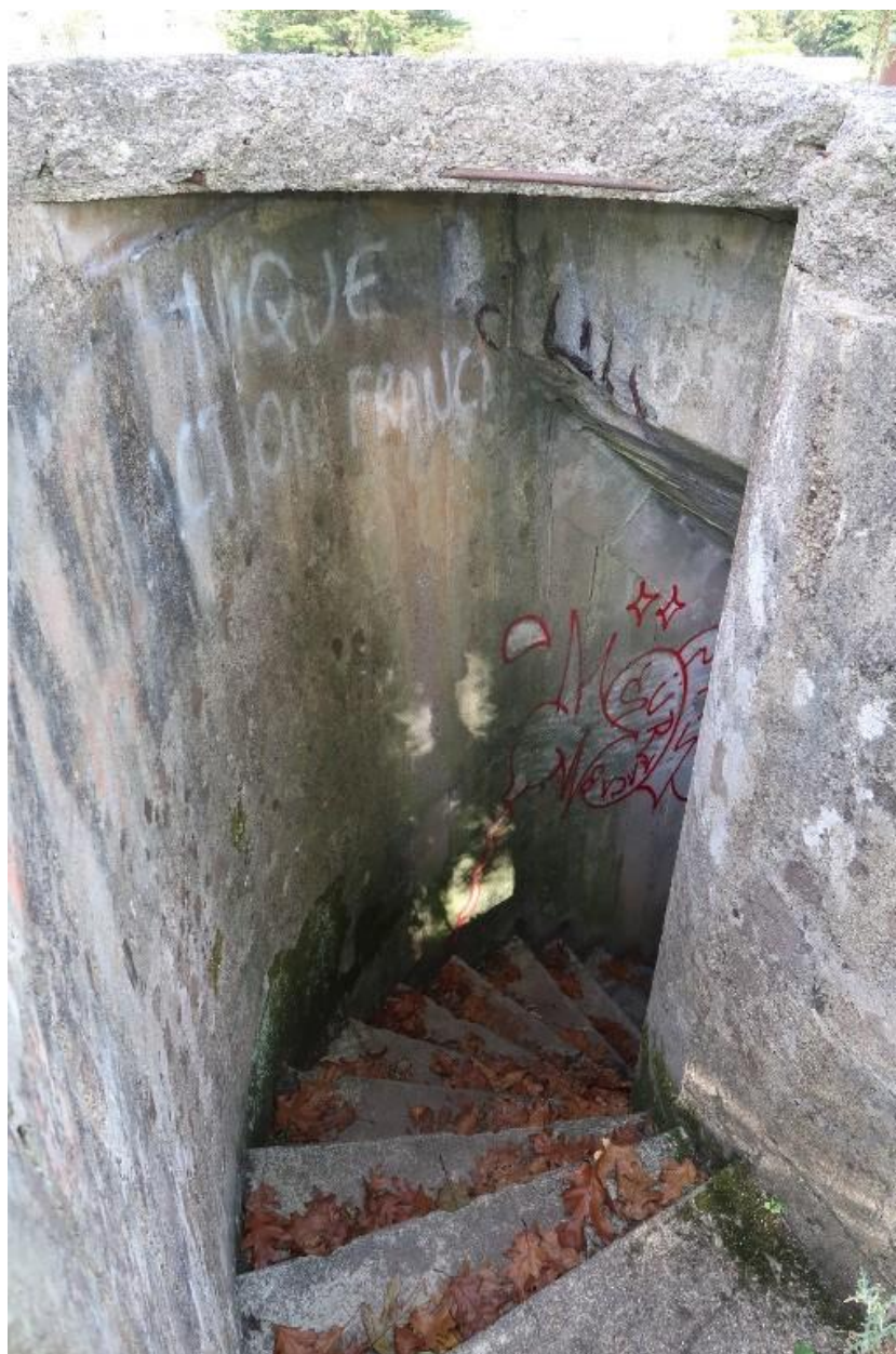
Vue du bunker-poste de direction de tir de type Fl229 pour télémètre : escalier tournant desservant les salles de calculs et des opérations depuis la cuve du télémètre
