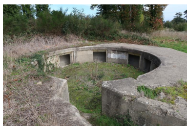
Vue du bunker-cuve de type Fl243a (V) pour canon antiaérien de 10.5 cm depuis le sud-ouest : au premier plan, l'entrée orientée vers le sud ; autour de la cuve circulaire sont implantées sept niches-abris pour les soldats et les munitions Phot. Guillaume Lécueillier IVR53_20255632856NUCA
