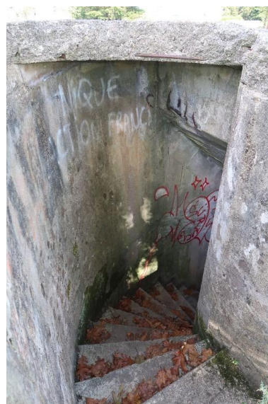
Vue du bunker-poste de direction de tir de type FI229 pour télémètre : escalier tournant desservant les salles de calculs et des opérations depuis la cuve du télémètre Phot. Guillaume Lécueillier IVR53_20255632977NUCA
