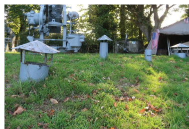
Vue de la dalle de couverture camouflée par de la terre du bunker-abri de type FI245 pour groupe électrogène : ensemble de cheminée et ventilation de bunker Phot. Guillaume Lécueillier IVR53_20255632919NUCA
