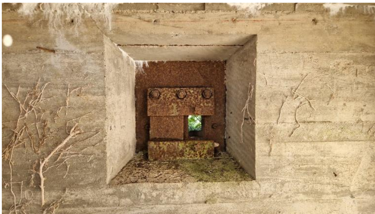
Vue du bunker-cuve de type Fl243a (II) pour canon antiaérien de 10.5 cm : ouverture de tir protégée par un volet blindé depuis l'intérieur. Cette ouverture de tir servait à protéger l'entrée de la cuve qui est orientée vers le nord
