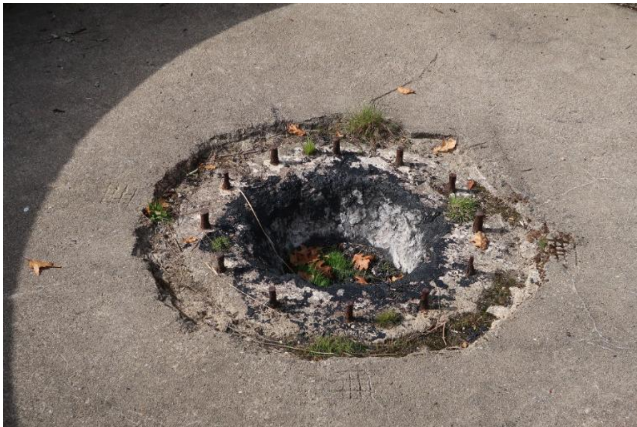
Vue du bunker-cuve de type Fl243a (IV) pour canon antiaérien de 10.5 cm : emplacement du canon avec ses douze tiges filetées. Autour figurent des marquages réalisés dans le béton frais
