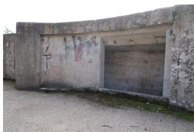
Vue du bunker-cuve de type Fl243a (IV) pour canon antiaérien de 10.5 cm : niche-abri sud destinée aux soldats. Sur le mur de la niche, une peinture murale rouge brun imitation papier peint réalisée au chiffon
