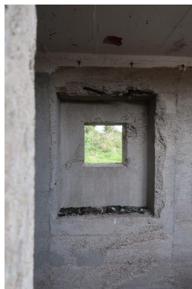
Vue du bunker-cuve de type Fl243a (IV) pour canon antiaérien de 10.5 cm : ouverture de tir depuis l'intérieur. Son volet blindé ne semble pas avoir été installé Phot. Guillaume Lécueillier IVR53_20255632871NUCA
