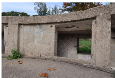
Vue du bunker-cuve de type Fl243a (IV) pour canon antiaérien de 10.5 cm : niche-abri nord destinée aux soldats. Cette niche est dotée d'une sortie de secours. Sur le mur de la niche, une peinture murale rouge brun imitation papier peint Phot. Guillaume Lécueillier IVR53_20255632875NUCA
