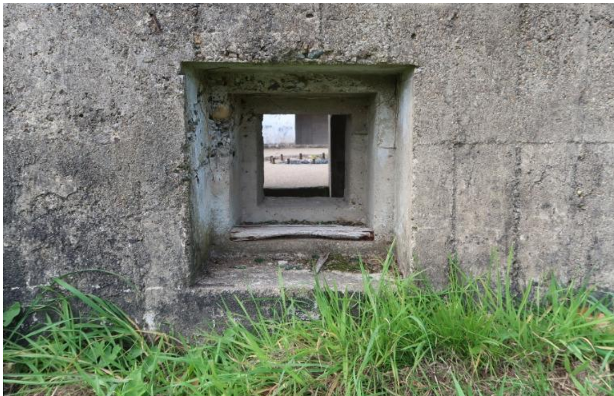
Vue du bunker-cuve de type Fl243a (IV) pour canon antiaérien de 10.5 cm : ouverture de tir protégeant l'entrée de la cuve qui est orientée vers l'est
