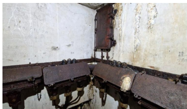
Vue intérieure du bunker-puits à câbles pour relais téléphonique : ensemble de plusieurs boîtiers de connexion. Sur le mur peint en blanc : des instructions tracées au crayon gris pour connecter les câbles et un nom (Hans Fechow) Phot. Guillaume Lécueillier IVR53_20255632932NUCA
