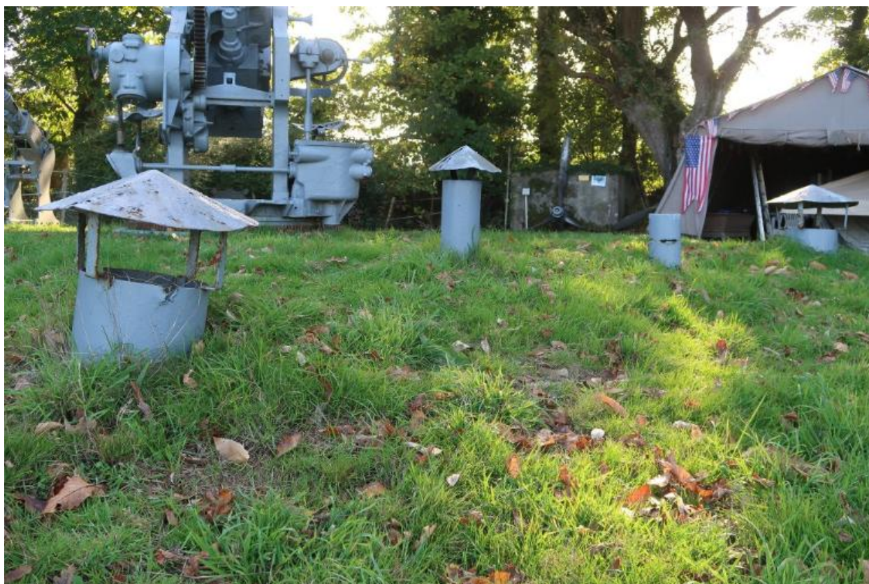
Vue de la dalle de couverture camouflée par de la terre du bunker-abri de type Fl245 pour groupe électrogène : ensemble de cheminée et ventilation de bunker
