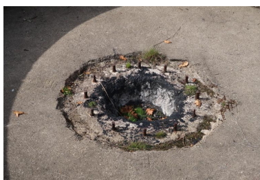
Vue du bunker-cuve de type Fl243a (IV) pour canon antiaérien de 10.5 cm : emplacement du canon avec ses douze tiges filetées.
