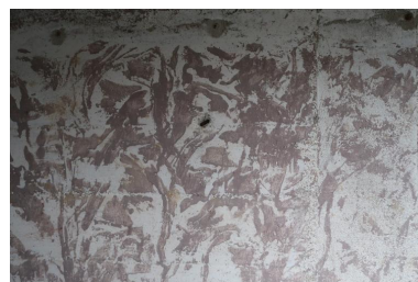
Vue du bunker-cuve de type Fl243a (IV) pour canon antiaérien de 10.5 cm : niche-abri nord destinée aux soldats. Sur le mur, une peinture murale rouge brun imitation papier peint réalisée au chiffon Phot. Guillaume Lécueillier IVR53_20255632877NUCA
