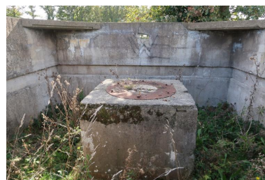
Vue intérieure du bunker-cuve sud pour canon antiaérien. Au centre, sous-sellette d'affût sur son socle en béton armé. La rainure périphérique de la cuve semble indiquer la présence de poutres supportant un plancher
