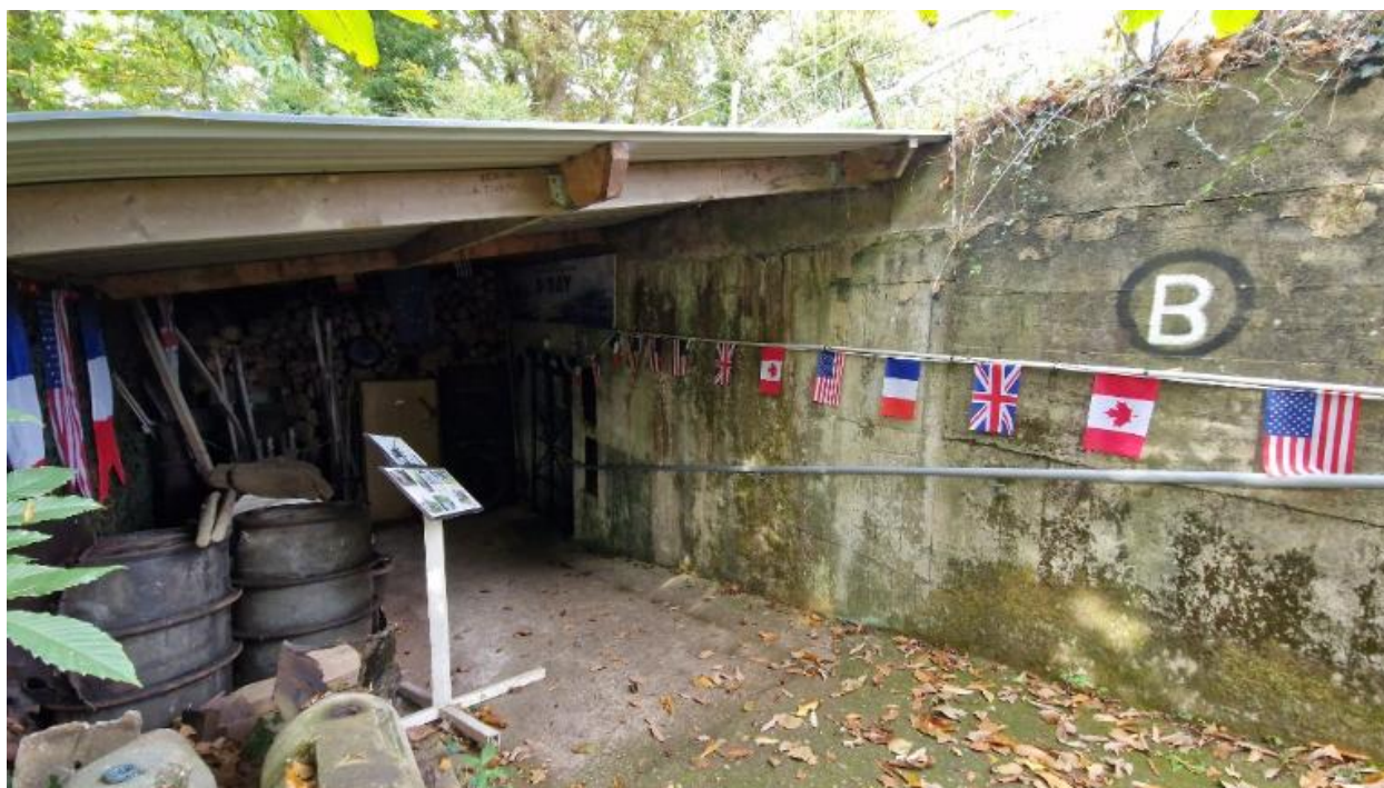
Vue de l'entrée du bunker-abri de type F1245 pour groupe électrogène. Elle est protégée par un appentis
