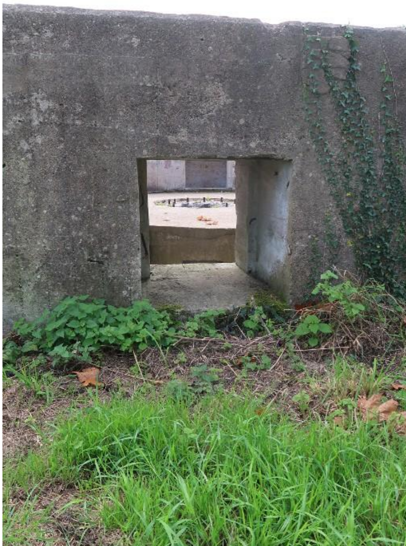
Vue du bunker-cuve de type Fl243a (IV) pour canon antiaérien de 10.5 cm : sortie de secours aménagée dans l'élévation nord
