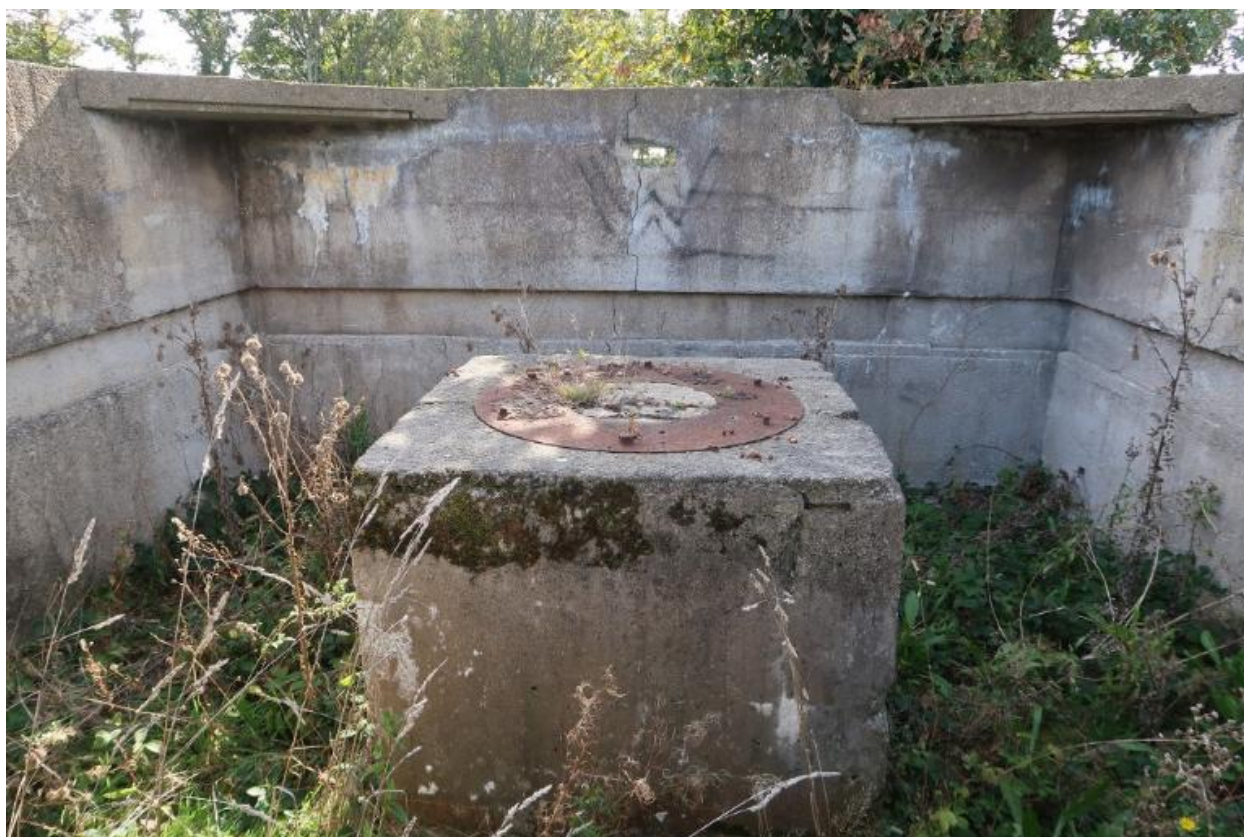
Vue intérieure du bunker-cuve sud pour canon antiaérien. Au centre, sous-selle d'affût sur son socle en béton armé. La rainure périphérique de la cuve semble indiquer la présence de poutres supportant un plancher
