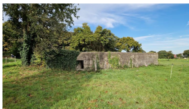
Vue générale depuis le sud-est. De ce côté se trouve la sortie de secours Phot. Guillaume Lécueillier IVR53_20255632835NUCA
