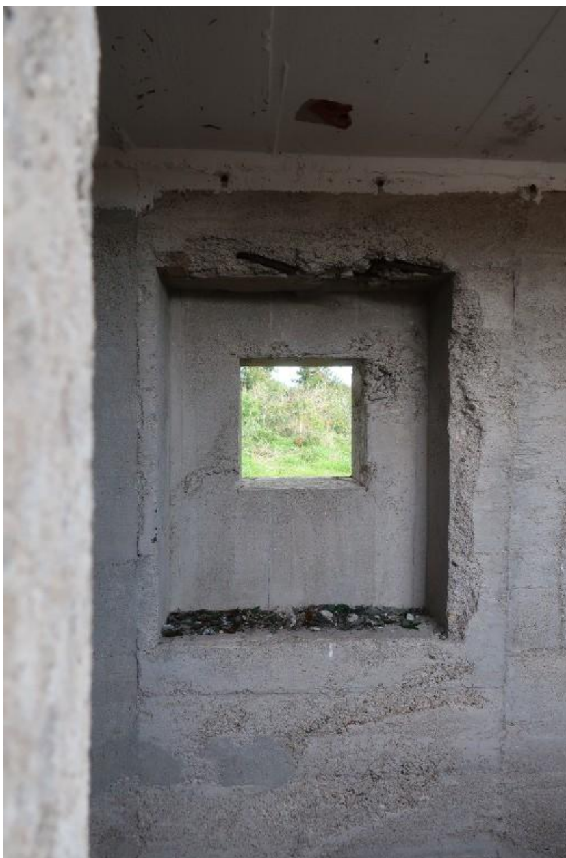
Vue du bunker-cuve de type Fl243a (IV) pour canon antiaérien de 10.5 cm : ouverture de tir depuis l'intérieur. Son volet blindé ne semble pas avoir été installé
