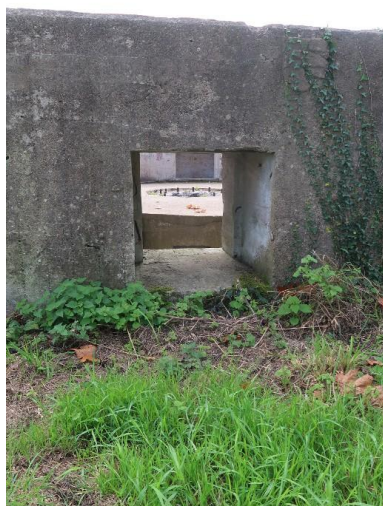
Vue du bunker-cuve de type Fl243a (IV) pour canon antiaérien de 10.5 cm : sortie de secours aménagée dans l'élévation nord Phot. Guillaume Lécueillier IVR53_20255632869NUCA
