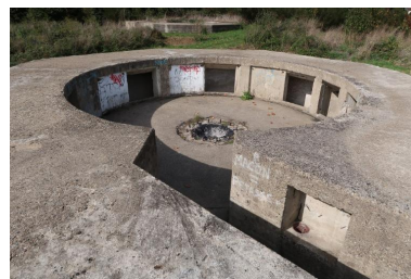
Vue du bunker-cuve de type Fl243a (IV) pour canon antiaérien de 10.5 cm depuis l'est : au premier plan, l'entrée orientée vers l'est ; autour de la cuve circulaire sont implantées sept niches-abris pour les soldats et les munitions ; au centre de la cuve, Phot. Guillaume Lécueillier IVR53_20255632866NUCA
