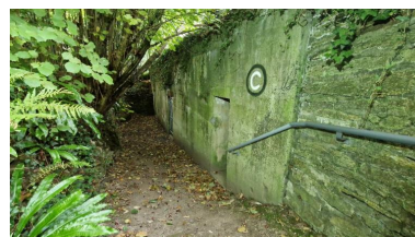
Vue du bunker-abri de type 621 pour un groupe de combat : élévation sud. La première porte dessert le poste d'observation dit Tobruk Phot. Guillaume Lécueillier IVR53_20255632984NUCA
