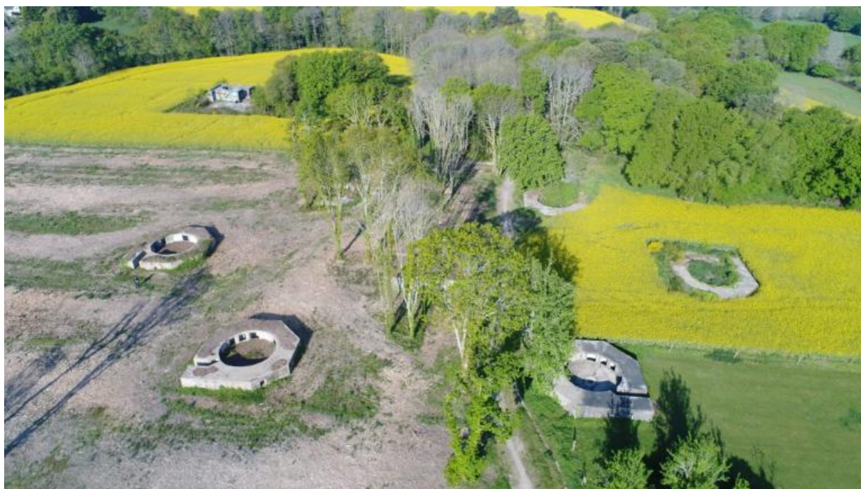
Vue générale oblique depuis l'est des six bunkers-cuves de type Fl243a pour canon antiaérien de 10.5 cm et des deux bunkers-postes de direction de tir pour télémètre
