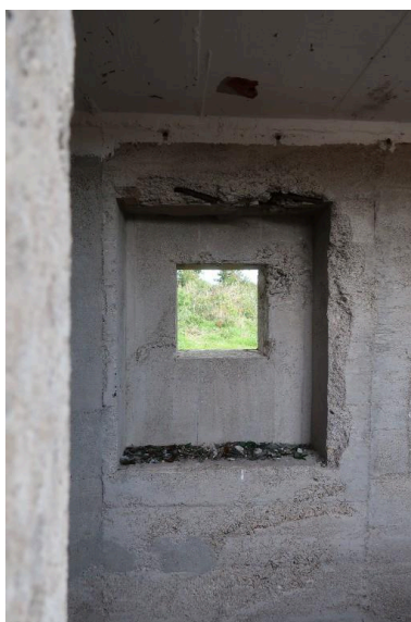
Vue du bunker-cuve de type FI243a (IV) pour canon antiaérien de 10.5 cm : ouverture de tir depuis l'intérieur. Son volet blindé ne semble pas avoir été installé
