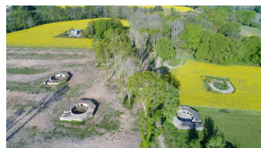
Vue générale oblique depuis l'est des six bunkers-caves de type FI243a pour canon antiaérien de 10.5 cm et des deux bunkers-postes de direction de tir pour télémètre Phot. Philippe Troussard IVR53_20255610848NUCA
