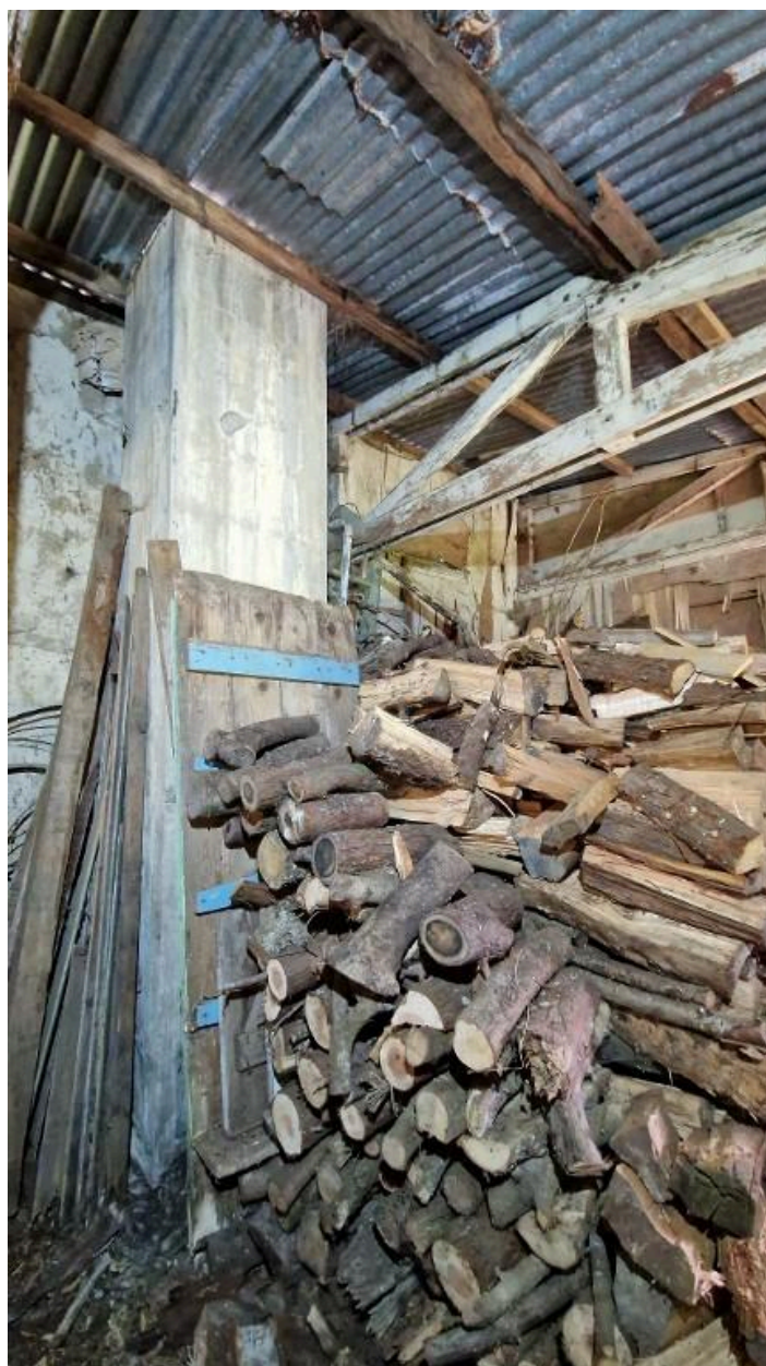
Vue intérieure du baraquement-cuisine-logement du cuisinier : souche de cheminée en maçonnerie enduite et charpente en bois (numérotation B2). L'édifice sert de remise à bois en 2025
