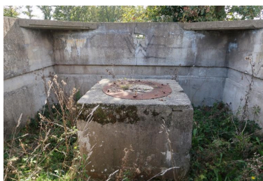
Vue intérieure du bunker-cuve sud pour canon antiaérien. Au centre, sous-selle d'affût sur son socle en béton armé. La rainure périphérique de la cuve
