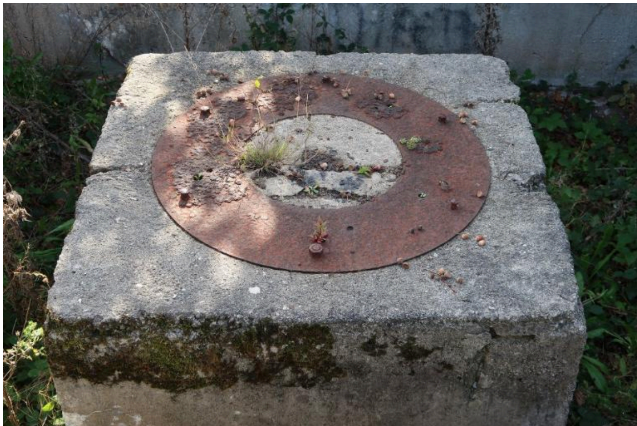
Vue intérieure du bunker-cuve pour canon antiaérien. Au centre, sous-selle d'affût sur son socle en béton armé
