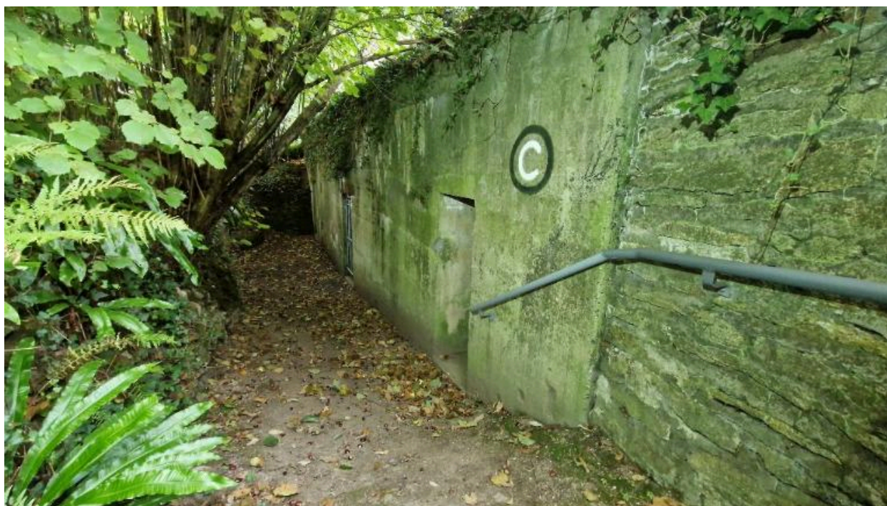
Vue du bunker-abri de type 621 pour un groupe de combat : élévation sud. La première porte dessert le poste d'observation dit Tobruk
