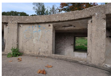
Vue du bunker-cuve de type FI243a (IV) pour canon antiaérien de 10.5 cm : niche-abri nord destinée aux soldats. Cette niche est dotée d'une sortie de secours. Sur le mur de la niche, une peinture murale rouge brun imitation papier peint Phot. Guillaume Lécueillier IVR53_20255632875NUCA
