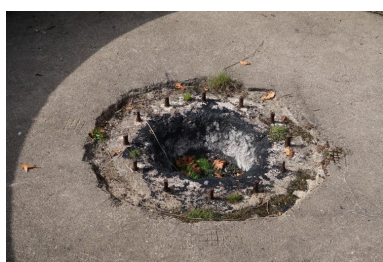
Vue du bunker-cuve de type FI243a (IV) pour canon antiaérien de 10.5 cm : emplacement du canon avec ses douze tiges filetées. Autour figurent des marquages réalisés dans le béton frais Phot. Guillaume Lécueillier IVR53_20255632881NUCA
