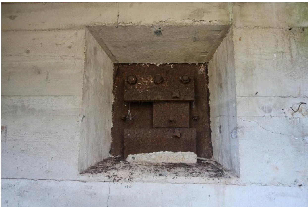
Vue du bunker-cuve de type FI243a (V) pour canon antiaérien de 10.5 cm : ouverture de tir protégée par un volet blindé depuis l'intérieur. Cette ouverture de tir servait à protéger l'entrée de la cuve qui est orientée vers le sud
