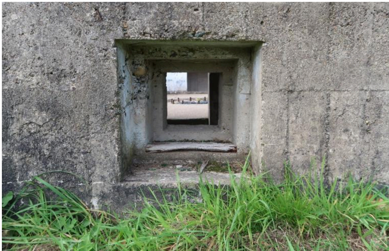
Vue du bunker-cuve de type FI243a (IV) pour canon antiaérien de 10.5 cm : ouverture de tir protégeant l'entrée de la cuve qui est orientée vers l'est
