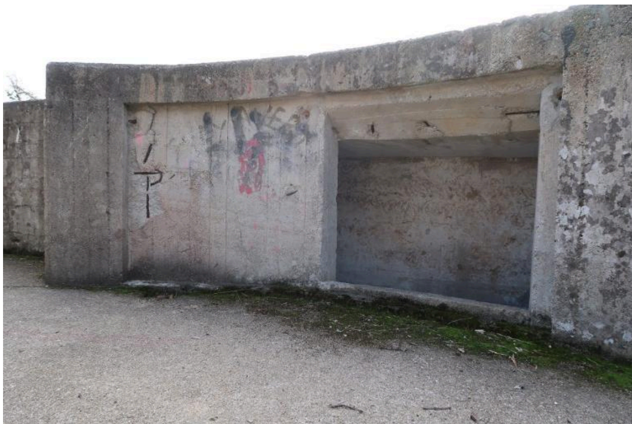
Vue du bunker-cuve de type FI243a (IV) pour canon antiaérien de 10.5 cm : niche-abri sud destinée aux soldats. Sur le mur de la niche, une peinture murale rouge brun imitation papier peint réalisée au chiffon
