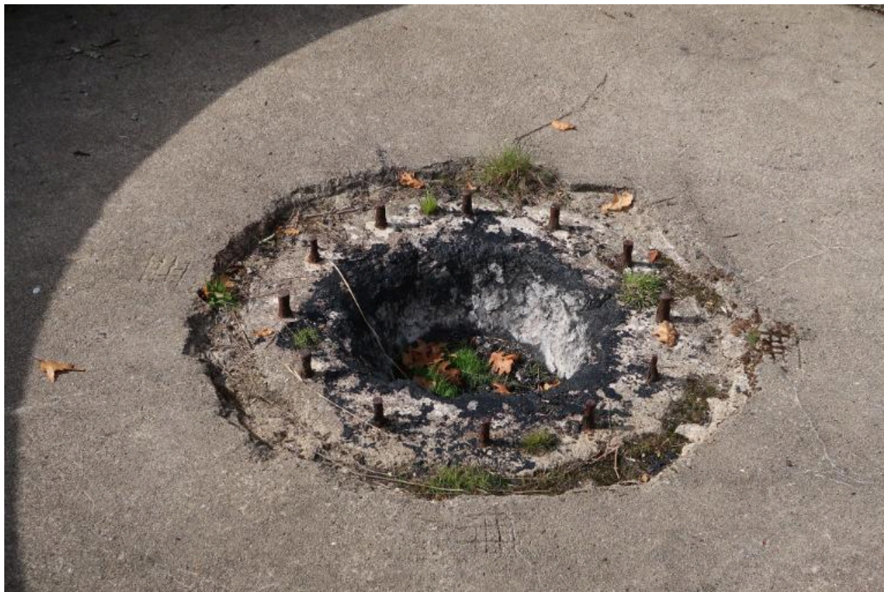
Vue du bunker-cuve de type FI243a (IV) pour canon antiaérien de 10.5 cm : emplacement du canon avec ses douze tiges filetées. Autour figurent des marquages réalisés dans le béton frais
