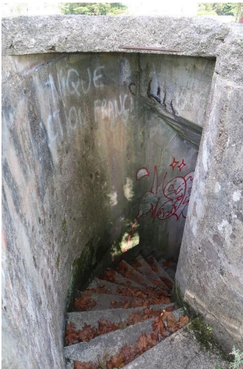
Vue du bunker-poste de direction de tir de type FI229 pour télémètre : escalier tournant desservant les salles de calculs et des opérations depuis la cuve du télémètre
