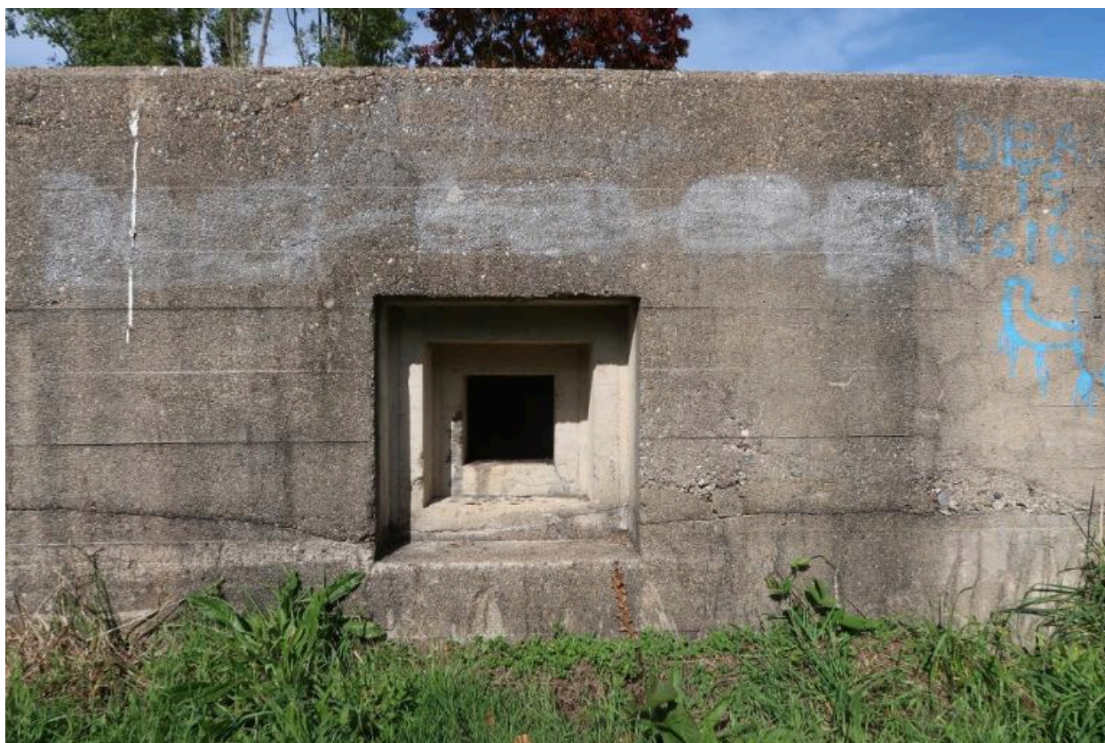
Vue du bunker-cuve de type FI243a (III) pour canon antiaérien de 10.5 cm : ouverture de tir en gradin depuis l'extérieur. Cette ouverture de tir servait à protéger l'entrée de la cuve qui est orientée vers le sud
