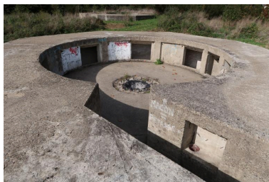
Vue du bunker-cuve de type FI243a (IV) pour canon antiaérien de 10.5 cm depuis l'est : au premier plan, l'entrée orientée vers l'est ; autour de la cuve circulaire sont implantées sept niches-abris pour les soldats et les munitions ; au centre de la cuve,
