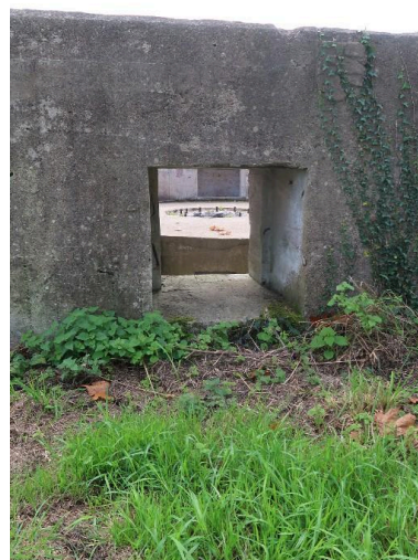
Vue du bunker-cuve de type FI243a (IV) pour canon antiaérien de 10.5 cm : sortie de secours aménagée dans l'élévation nord
