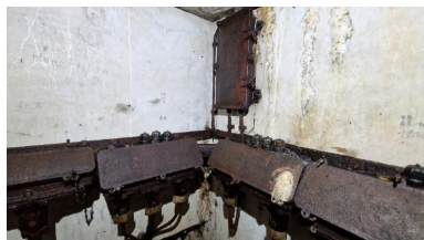
Vue intérieure du bunker-puits à câbles pour relais téléphonique : ensemble de plusieurs boîtiers de connexion. Sur le mur peint en blanc : des instructions tracées au crayon gris pour connecter les câbles et un nom (Hans Fechow)
