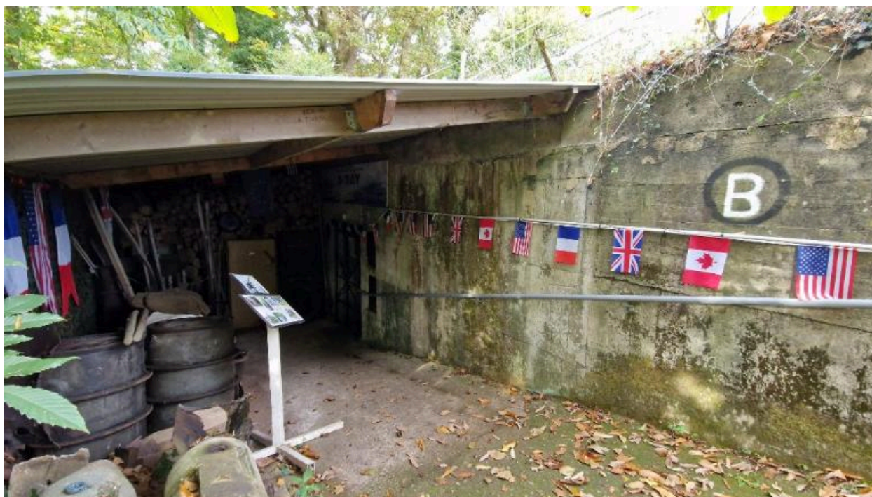
Vue de l'entrée du bunker-abri de type FI245 pour groupe électrogène. Elle est protégée par un appentis
