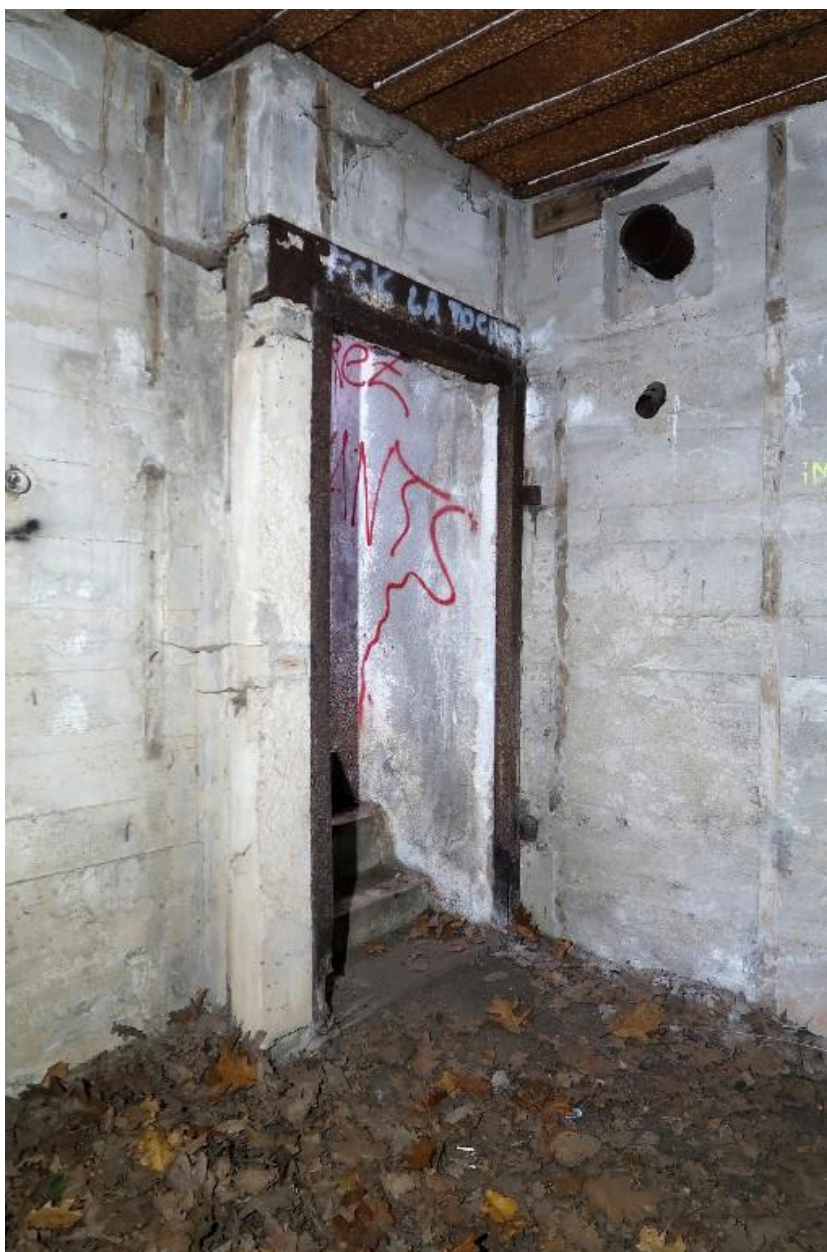
Vue du bunker-poste de direction de tir de type FI229 pour télémètre : débouché de l'escalier desservant les salles de calculs et des opérations. Près du plafond, vestiges des voliges clouées au mur. Les murs sont peints en blanc
