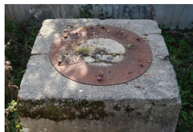
Vue intérieure du bunker-cuve pour canon antiaérien. Au centre, sous-selle d'affût sur son socle en béton armé Phot. Guillaume Lécueillier
