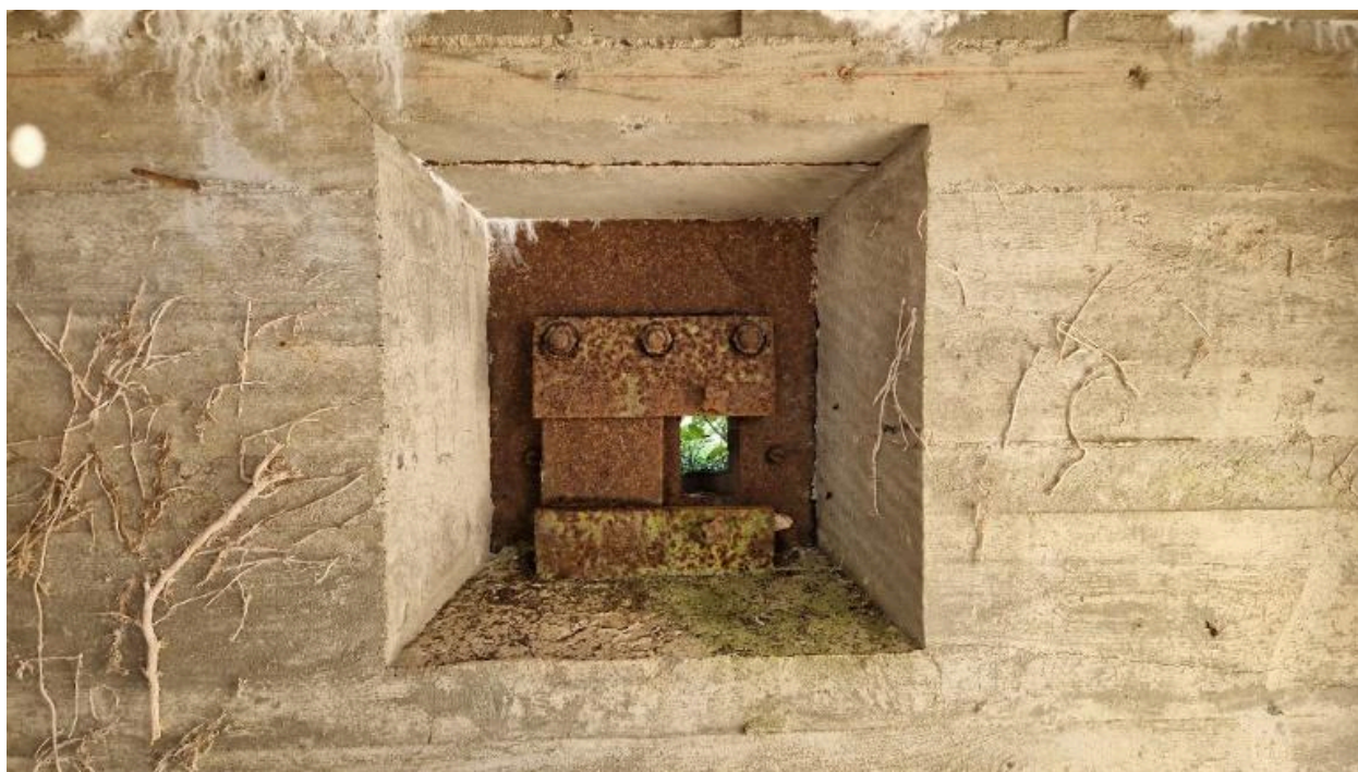
Vue du bunker-cuve de type FI243a (II) pour canon antiaérien de 10.5 cm : ouverture de tir protégée par un volet blindé depuis l'intérieur. Cette ouverture de tir servait à protéger l'entrée de la cuve qui est orientée vers le nord
