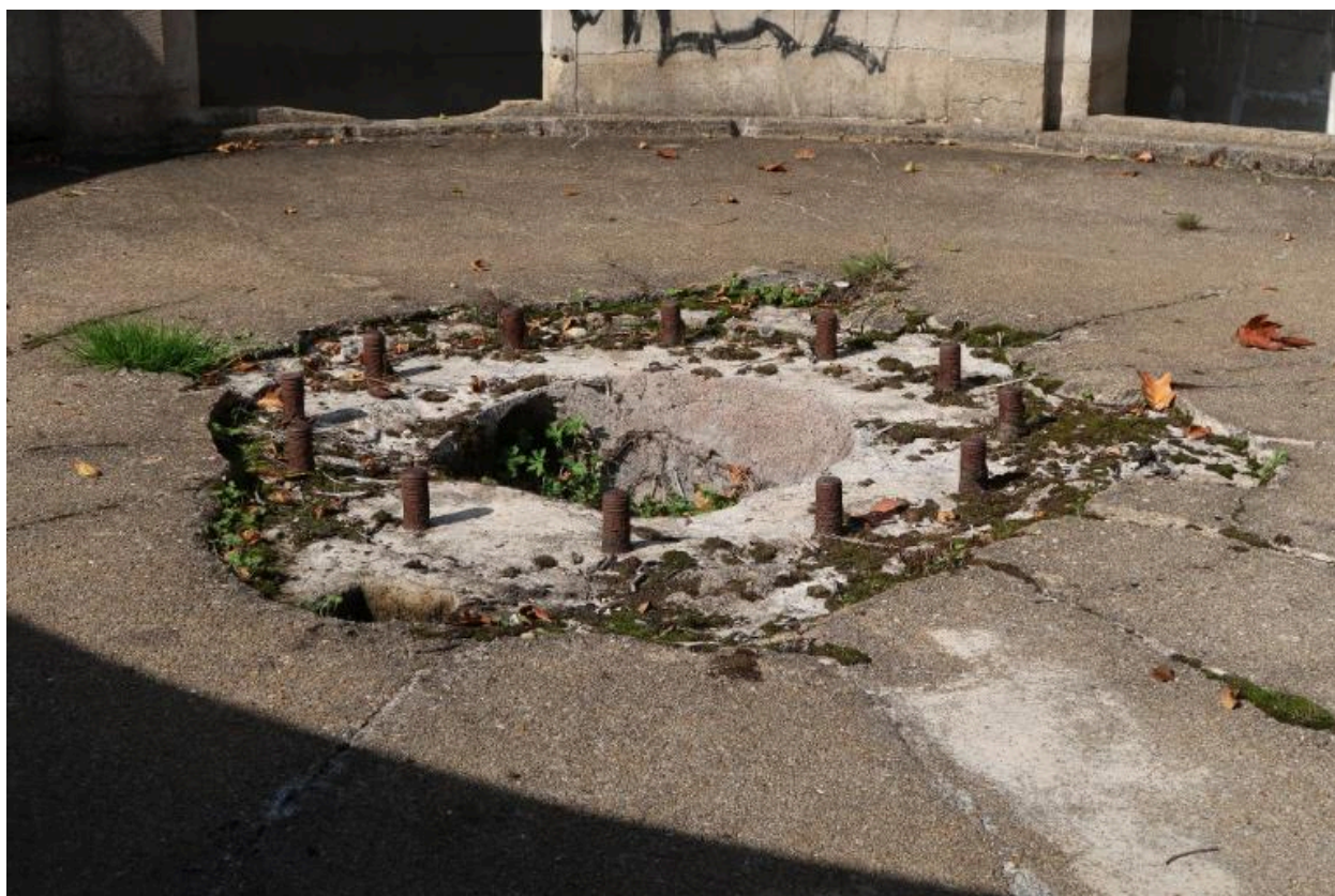
Vue du bunker-cuve de type FI243a (III) pour canon antiaérien de 10.5 cm : emplacement du canon avec ses douze tiges filetées
