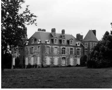
Vue sud-ouest Phot. Guy Artur, Phot. Norbert Lambart IVR53_19915600724X
