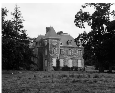
Elévation ouest : vue générale prise du nord-ouest Phot. Guy Artur, Phot. Norbert Lambart IVR53_19915600725X
