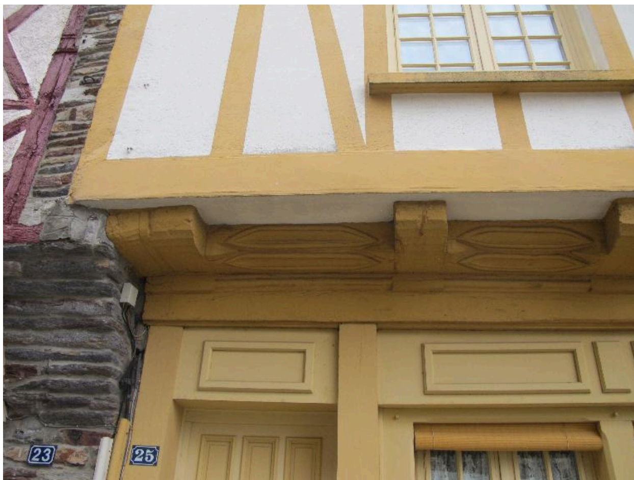
Maison, élévation nord-ouest : les solives et les entretoises moulurées (état en 2012)
