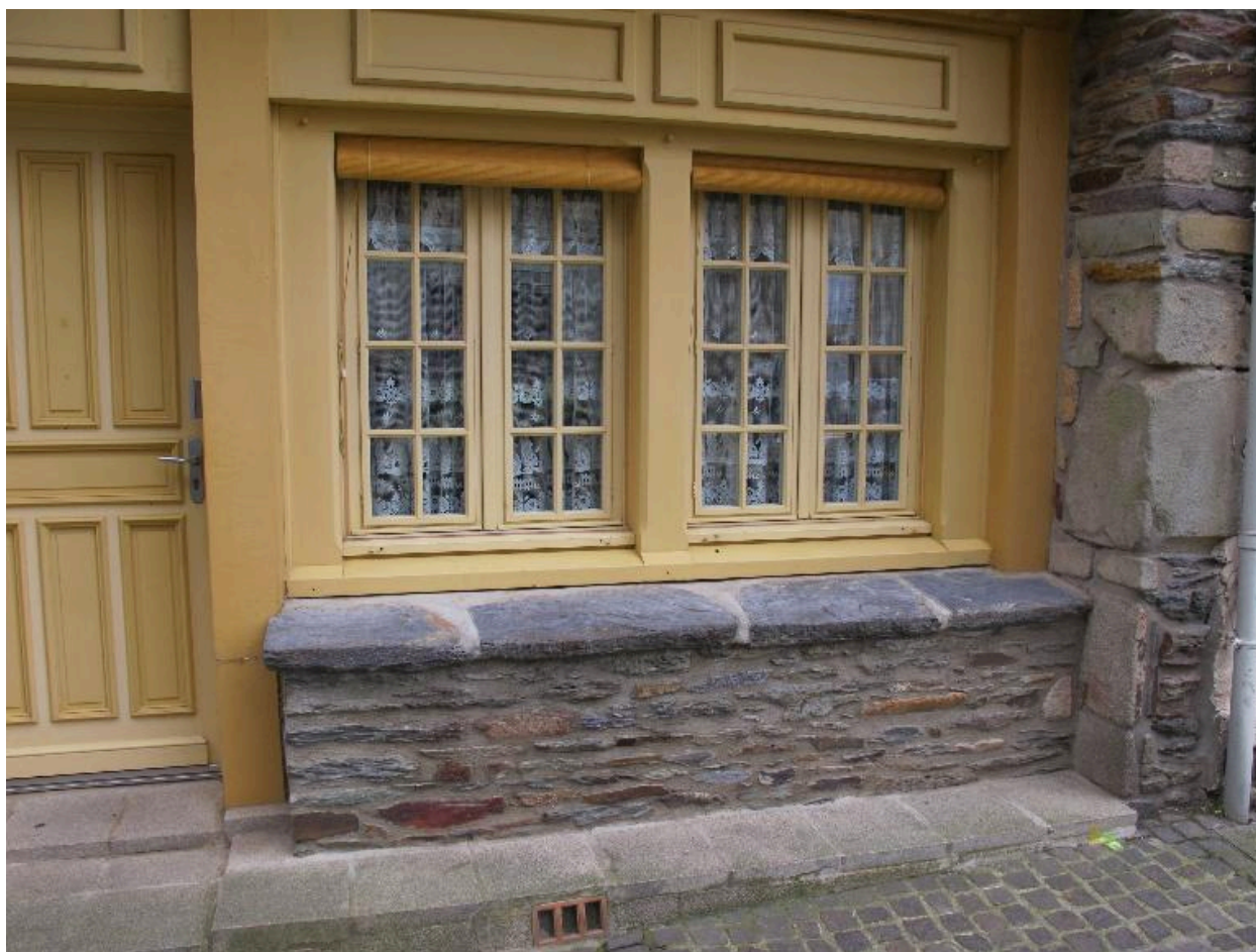
Maison, élévation nord-ouest : le rez-de-chaussée (état en 2012)
