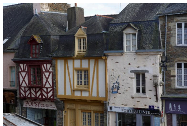
Maison, élévation nord-ouest : le premier étage (état en 2012) Phot. Bernard Bègne IVR53_20125601407NUCA
