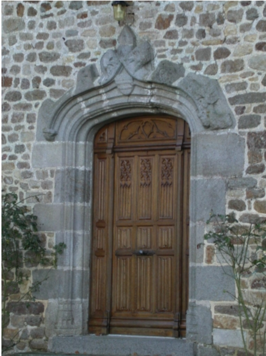
Détail de la porte d'entrée
