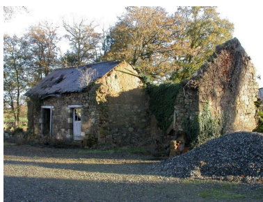
Les dépendances Phot. Sabrina Dalibard IVR53_20053520621NUCA
