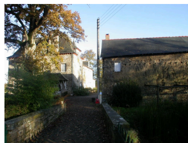
Pont enjambant les douves au sud Phot. Sabrina Dalibard IVR53_20053520623NUCA
