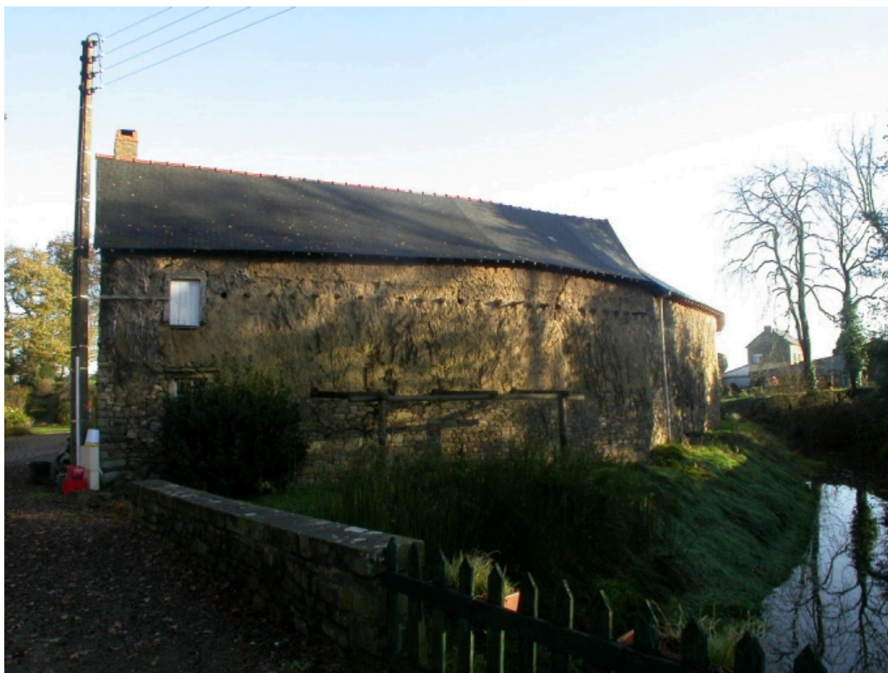
Façade postérieure des dépendances
