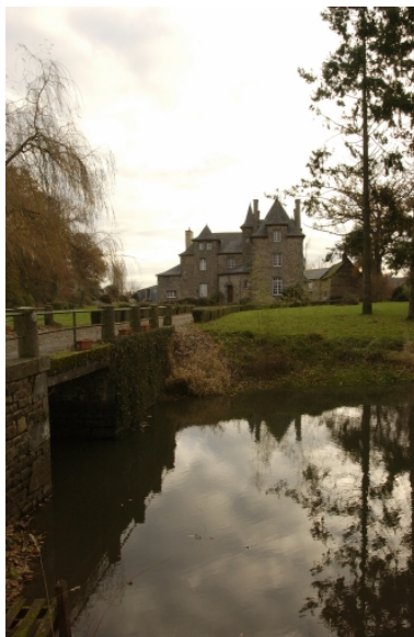
Vue générale ouest Phot. Norbert Lambart IVR53_20053503485NUCA
