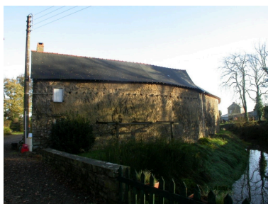
Façade postérieure des dépendances Phot. Sabrina Dalibard IVR53_20053520622NUCA
