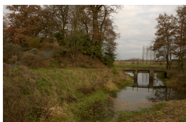
Pont entre la motte et l'île Phot. Norbert Lambart IVR53_20053503481NUCA
