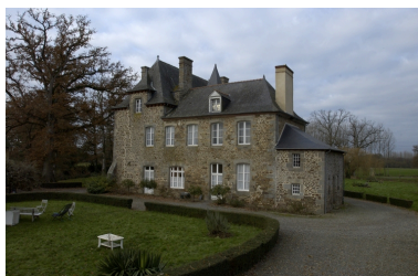
Vue nord-est Phot. Norbert Lambart IVR53_20053503477NUCA
