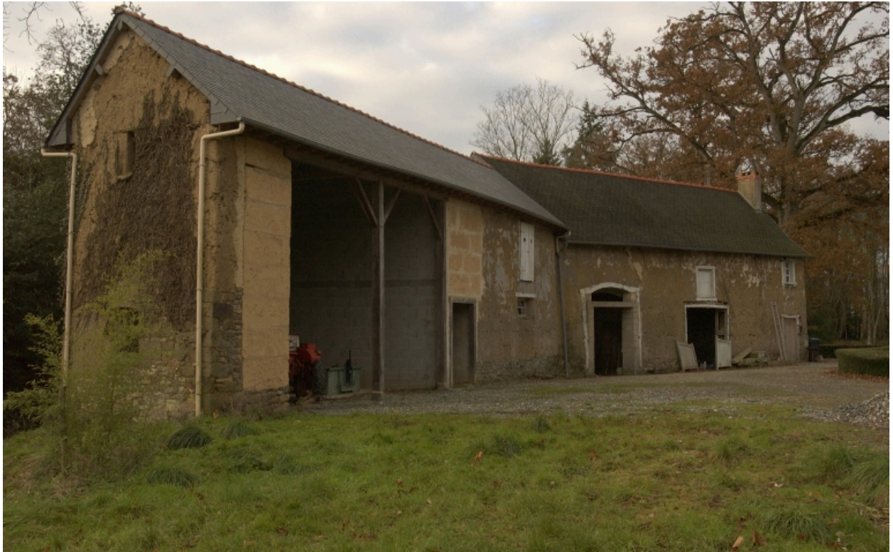
Vue nord-est des dépendances
