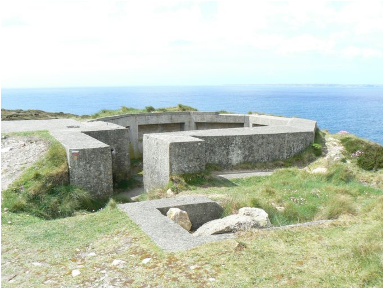
Encuvement de la batterie antiaérienne à la Pointe du Grand Gouin
