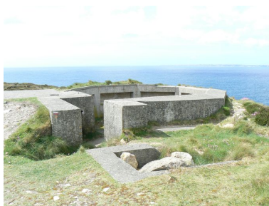
Encuvement de la batterie antiaérienne à la Pointe du Grand Gouin
