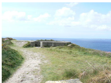
Vue générale de l'encuvement de la batterie antiaérienne du Grand Gouin Phot. Lénaïg L'Aot
