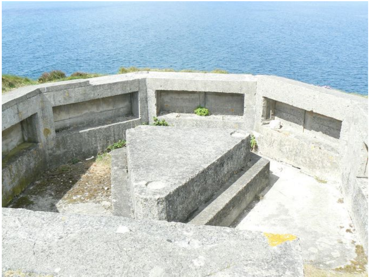
Socle bétonné de l'encuvement de la batterie antiaérienne du Grand Gouin
