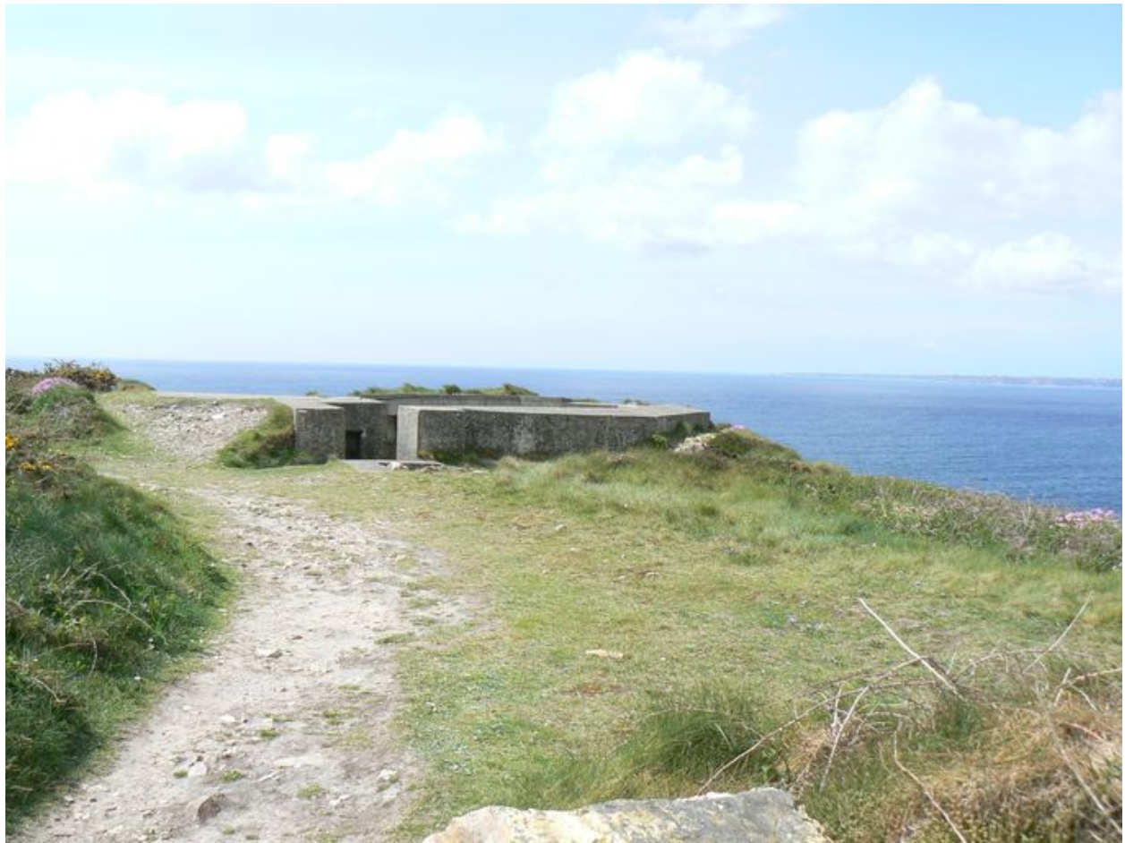
Vue générale de l'encuvement de la batterie antiaérienne du Grand Gouin
