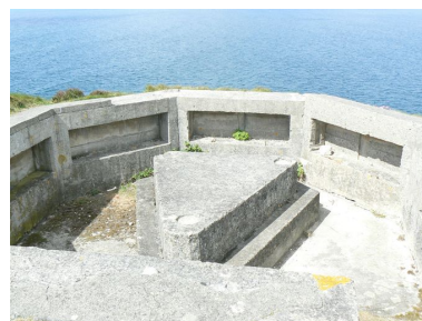
Socle bétonné de l'encuvement de la batterie antiaérienne du Grand Gouin Phot. Lénaïg L'Aot
