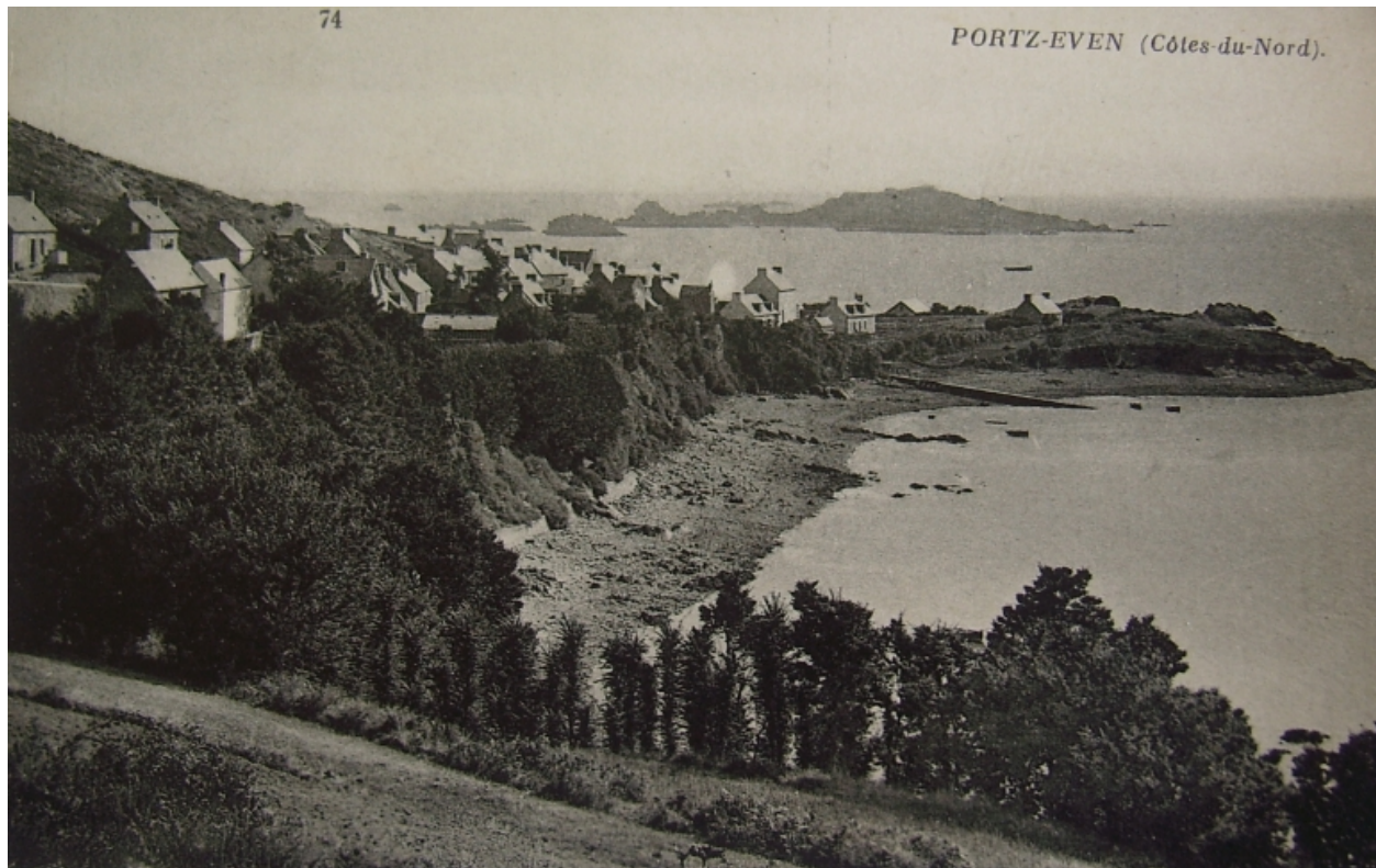
Vue générale, 1ère moitié du 20ème siècle (AD 22)
