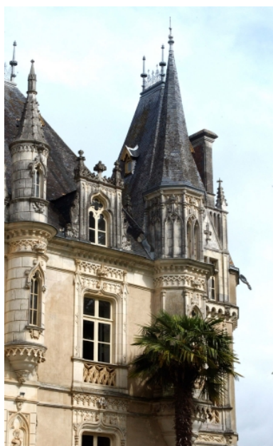
Château, détail des parties hautes Phot. Norbert Lambart IVR53_20023503106NUCA
