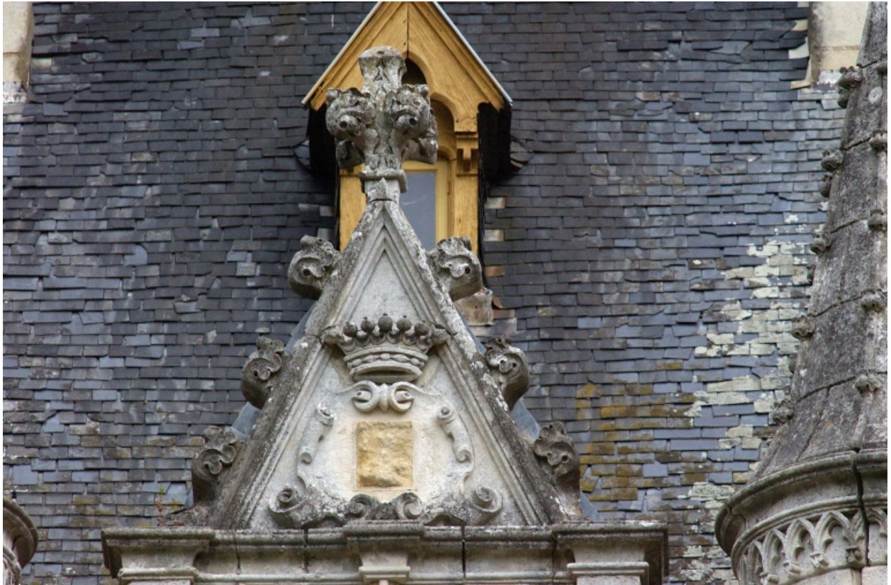
Détail d'une lucarne
