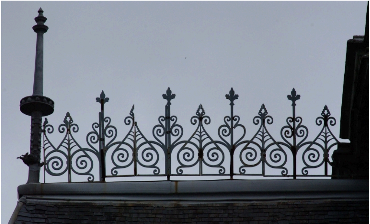
Faîtage de toiture
