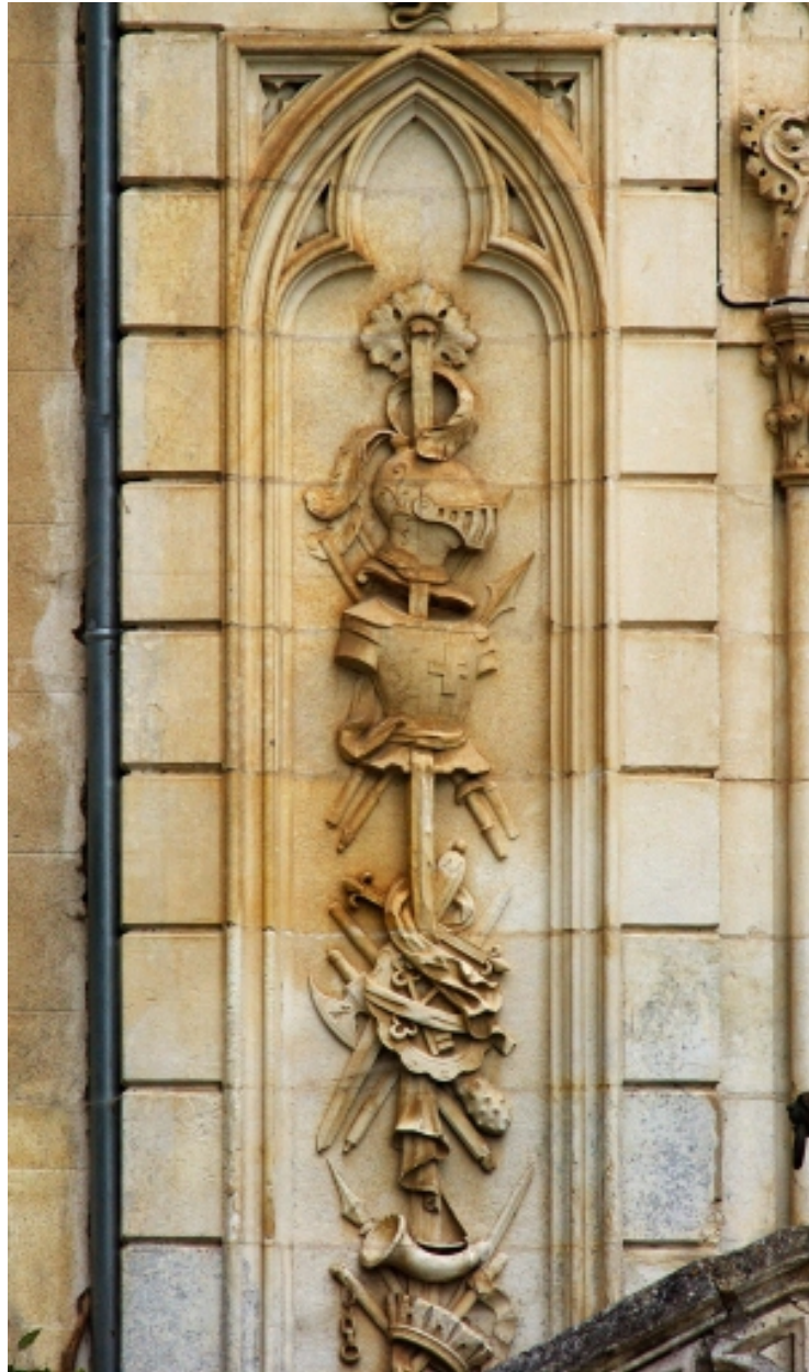
Façade antérieure, détail des armoiries sculptées
