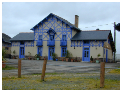
Communs Phot. Véronique Orain IVR53_20023512488NUCA
