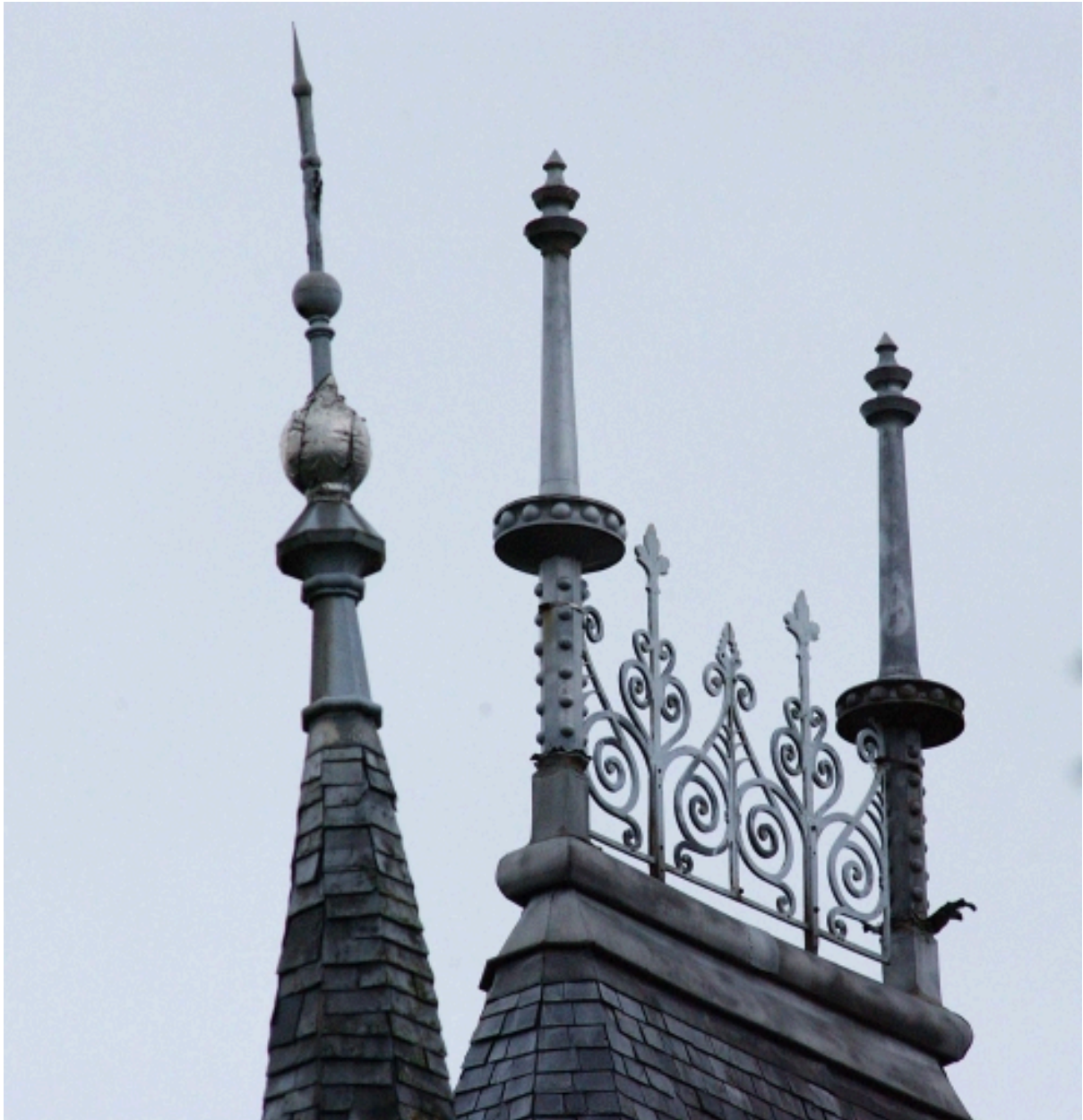
Faîtage de toiture
