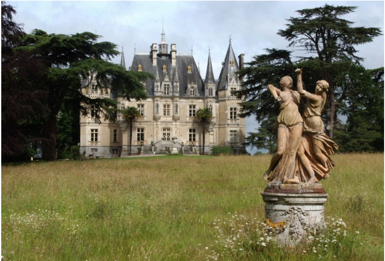
Château, vue rapprochée, façade antérieure
