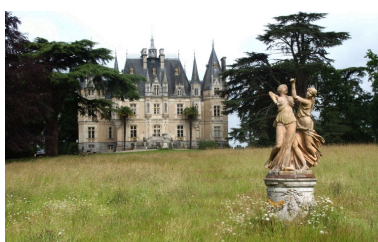
Château, vue rapprochée, façade antérieure Phot. Norbert Lambart IVR53_20023503103NUCA
