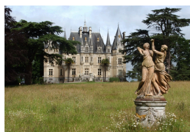
Château, vue rapprochée, façade antérieure Phot. Norbert Lambart IVR53_20023503104NUCA
