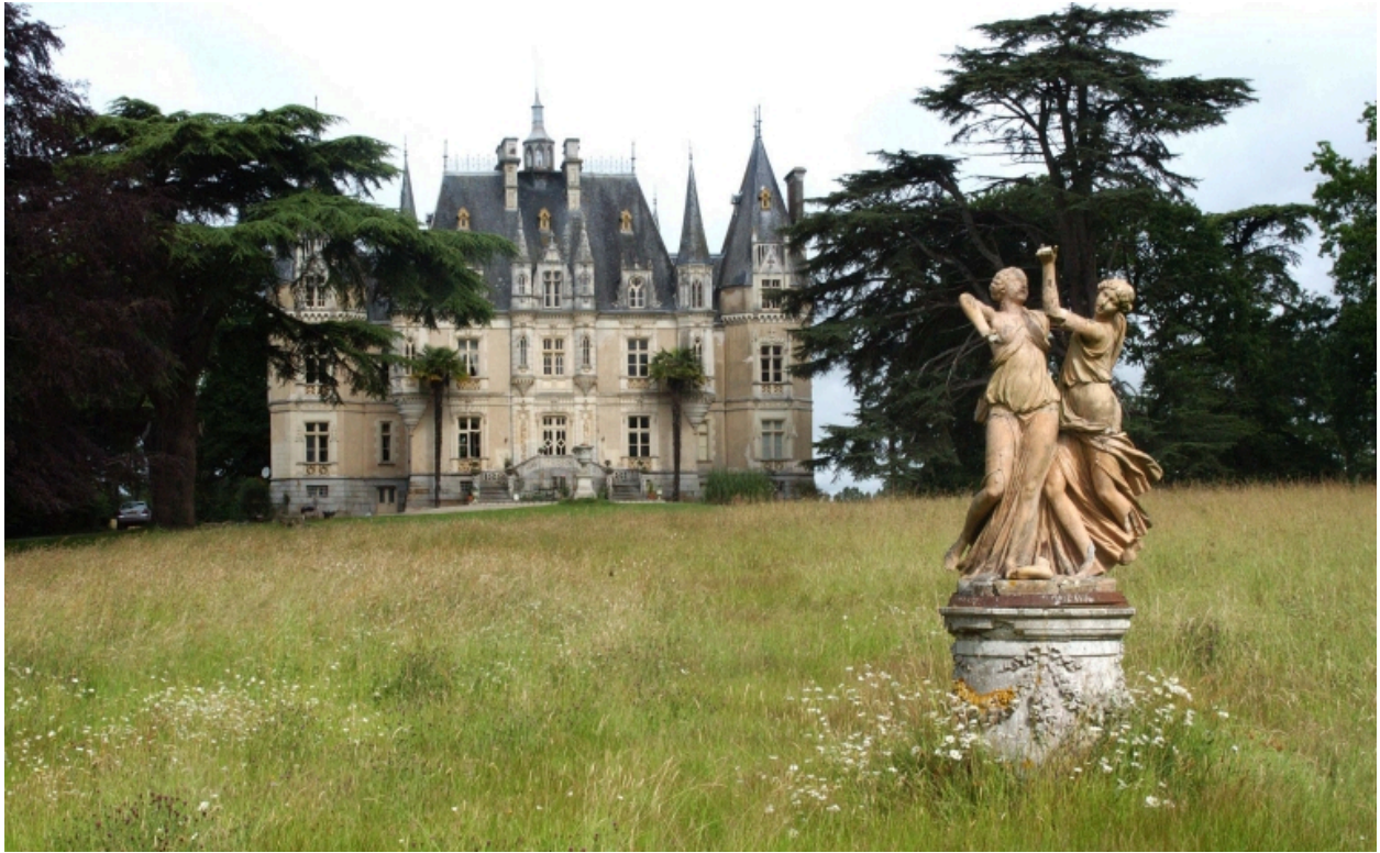
Château, vue rapprochée, façade antérieure
