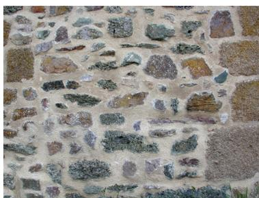
Vue de la maçonnerie des murs extérieurs : remarquer les joints entre les moellons de pierres
