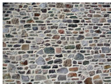
Vue de la maçonnerie des murs extérieurs : remarquer les moellons de pierres d'origine différente (schiste, granite, grès, pierre volcanique)
