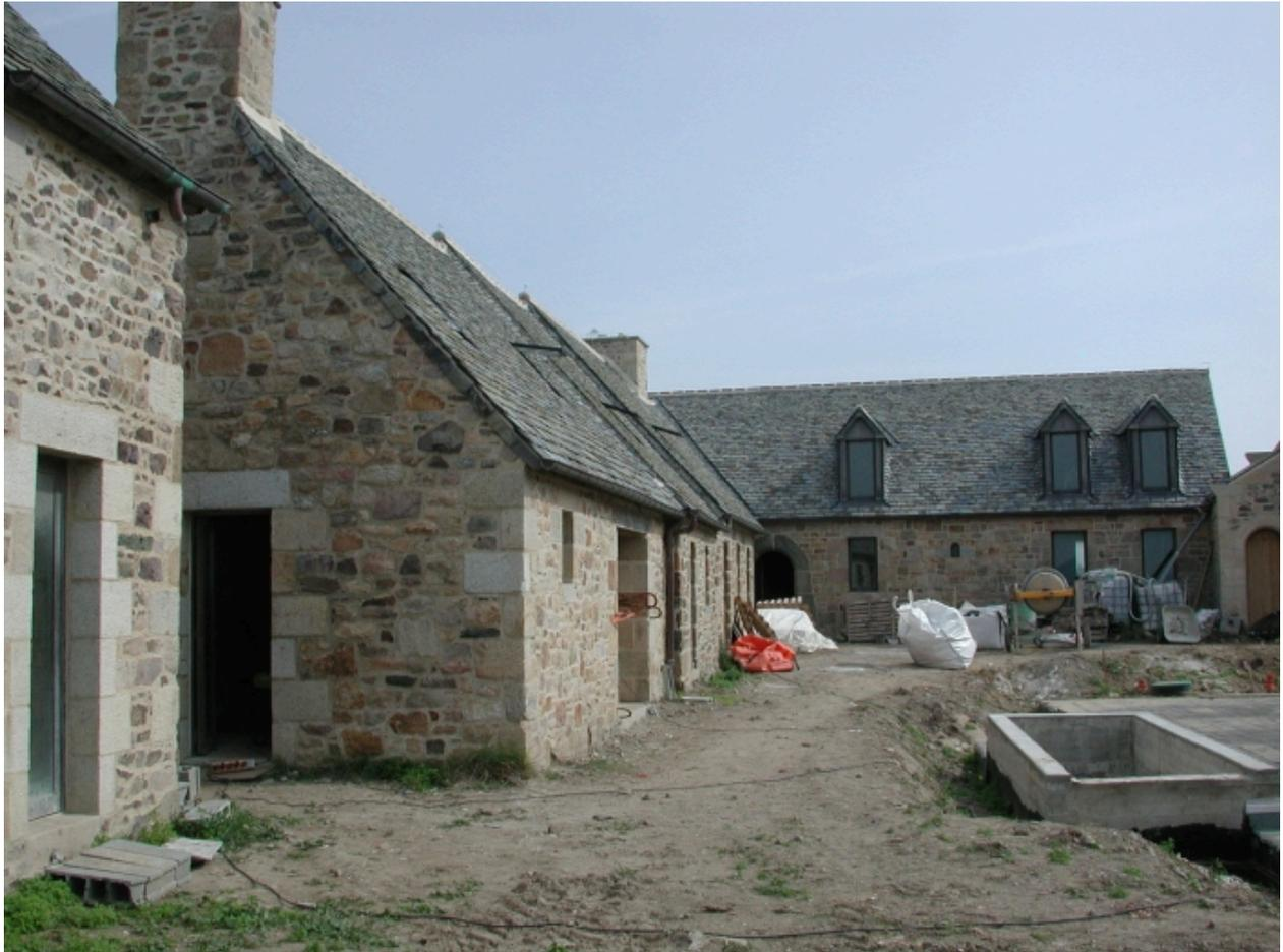
Vue des bâtiments Ouest et Nord en travaux : remarquer la couverture en ardoises de schiste de Sizun et les toits à longs pans
