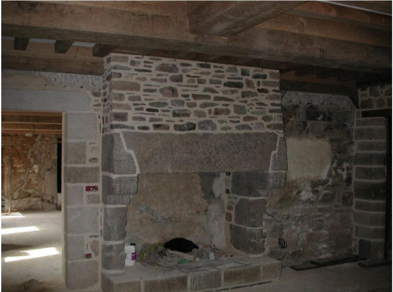
Vue de la cheminée et du mur de refend avec une ouverture de communication entre les bâtiments de l'aile Ouest
