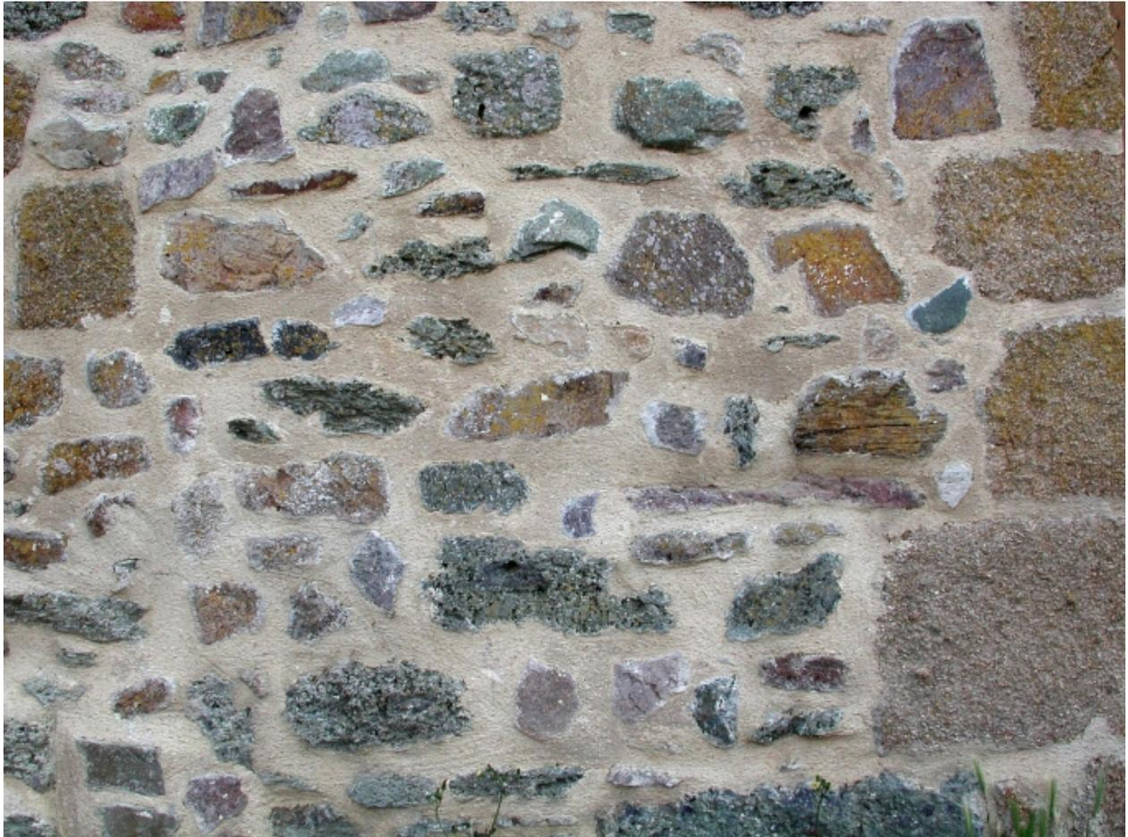
Vue de la maçonnerie des murs extérieurs : remarquer les joints entre les moellons de pierres
