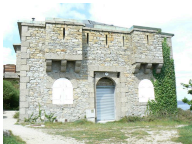
Vue générale du réduit de batterie de côte du Petit Gouin Phot. Lénaïg L'Aot IVR53_20072908571NUCA
