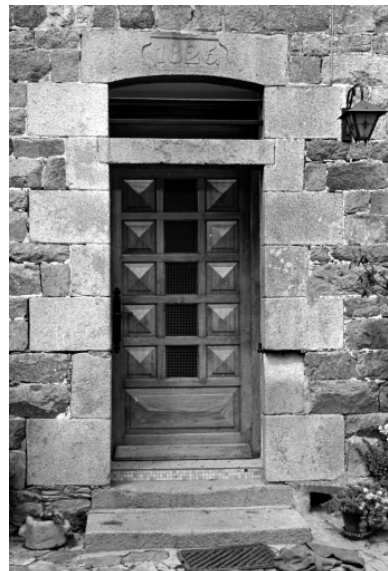
Porte d'entrée (cliché S. Laffiché, pré-inventaire, 1973) Phot. Sylvie Laffiché, Phot. Norbert Lambart, Phot. Auteur inconnu IVR53_19732205005ZB
