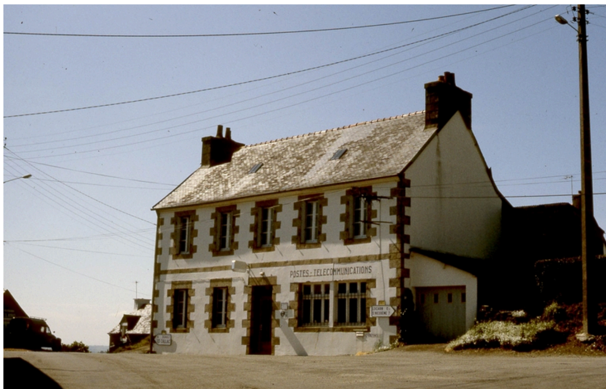
Maison, actuellement bureau de poste, vue générale.
