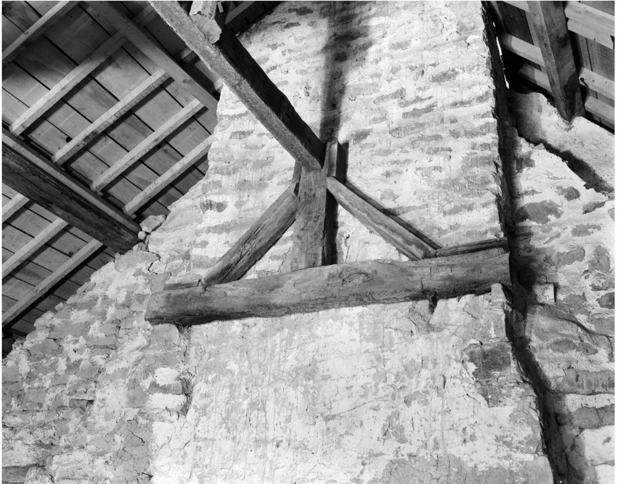
Charpente, détail du système de soutènement.
