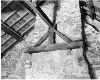
Charpente, détail du système de soutènement.
