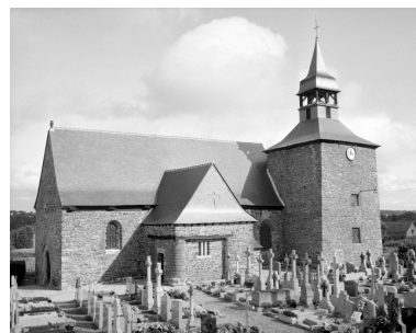
Elevation sud : vue générale Phot. Guy Artur, Phot. Norbert Lambart IVR53_19923500747X
