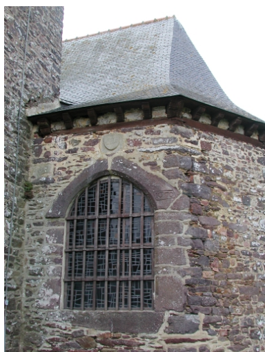
Chevet, vue extérieure Phot. Philippe Bardel IVR53_20033514189NUCA
