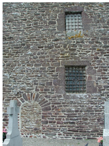
Tour-clocher, détail des baies Phot. Philippe Bardel IVR53_20033514186NUCA
