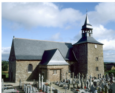
Elevation sud : vue générale Phot. Guy Artur, Phot. Norbert Lambart IVR53_19923500749XA
