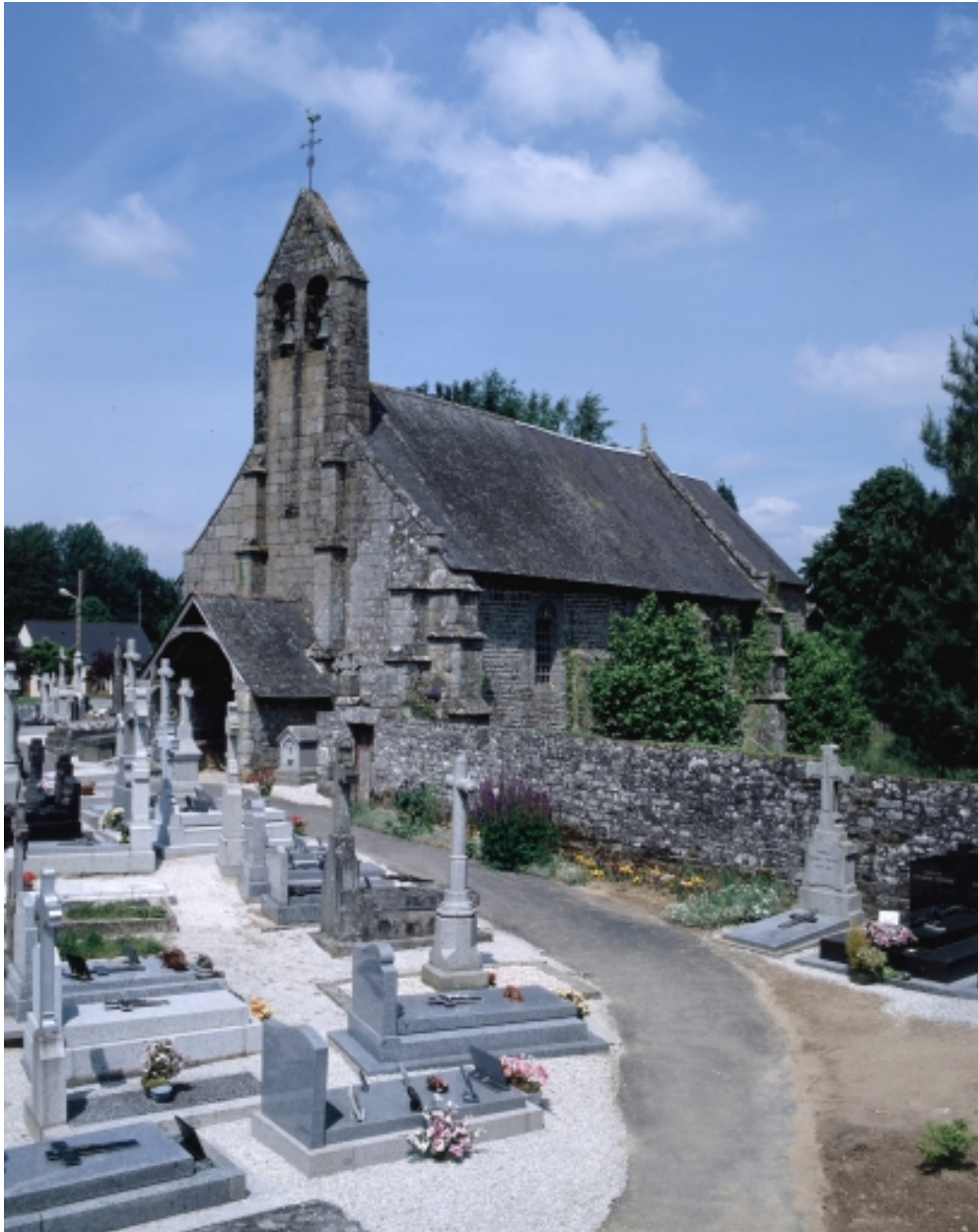
Elévation Sud-Ouest : vue générale
