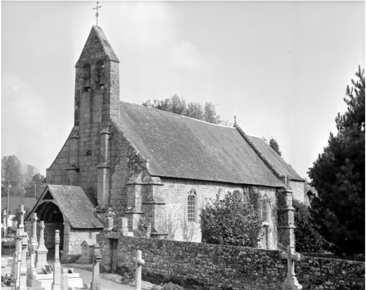
Elévation Sud-Ouest : vue générale
