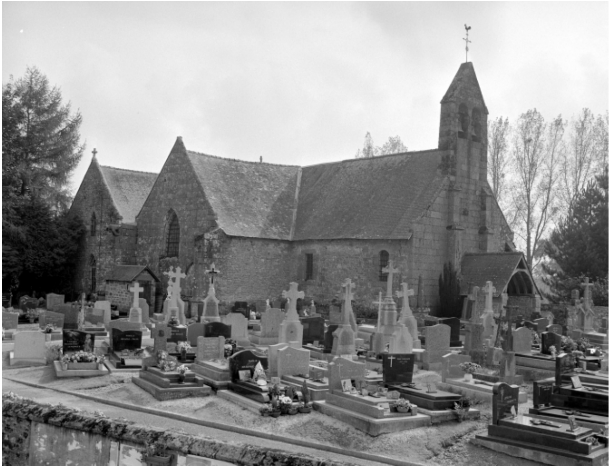
Elévation Nord-Ouest : vue générale
