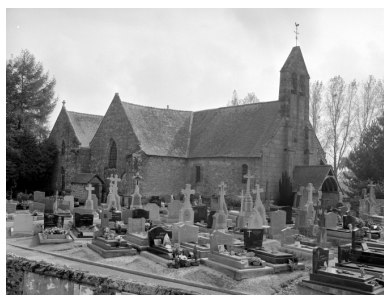
Elévation Nord-Ouest : vue générale
