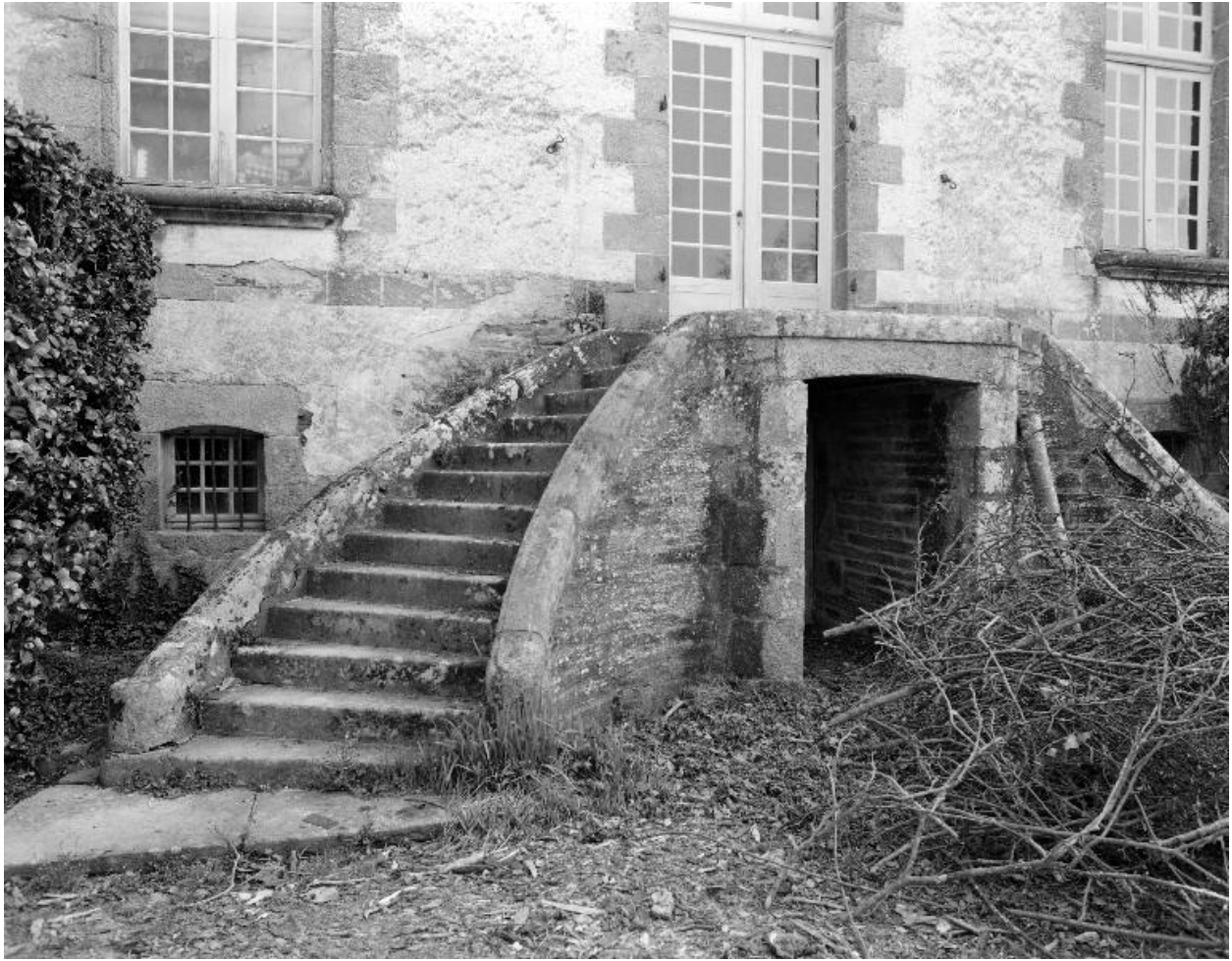
Château, logis : escalier extérieur ouest (état en 1984)
