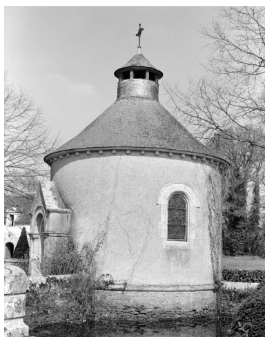
Château : la chapelle vue du sud-est (état en 1984) Phot. Guy Artur, Phot. Norbert Lambart IVR53_19845600574V
