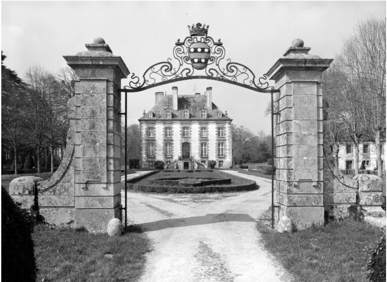
Château : le portail (état en 1984)
