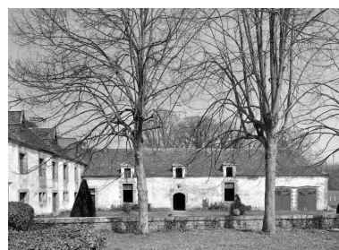
Château, commons : élévation sud (état en 1984) Phot. Guy Artur, Phot. Norbert Lambart IVR53_19845600580V
