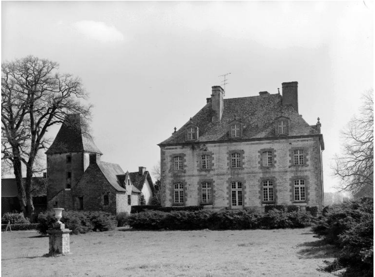
Château, logis : élévation ouest (état en 1984)
