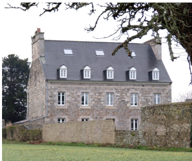
Vue générale, façade postérieure Phot. Patrick Pichouron IVR53_20102209832NUCA
