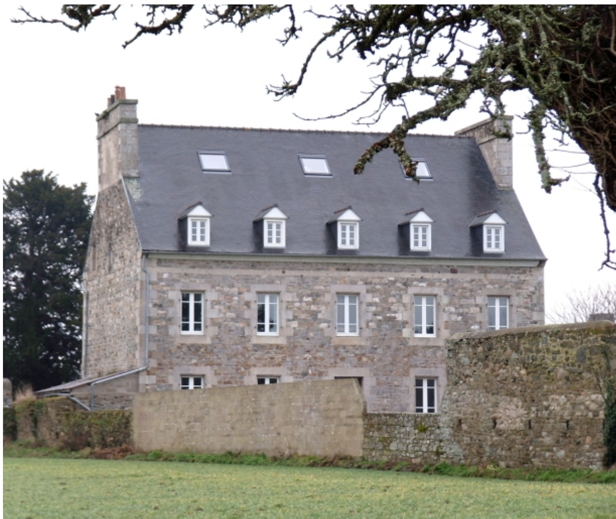
Vue générale, façade postérieure
