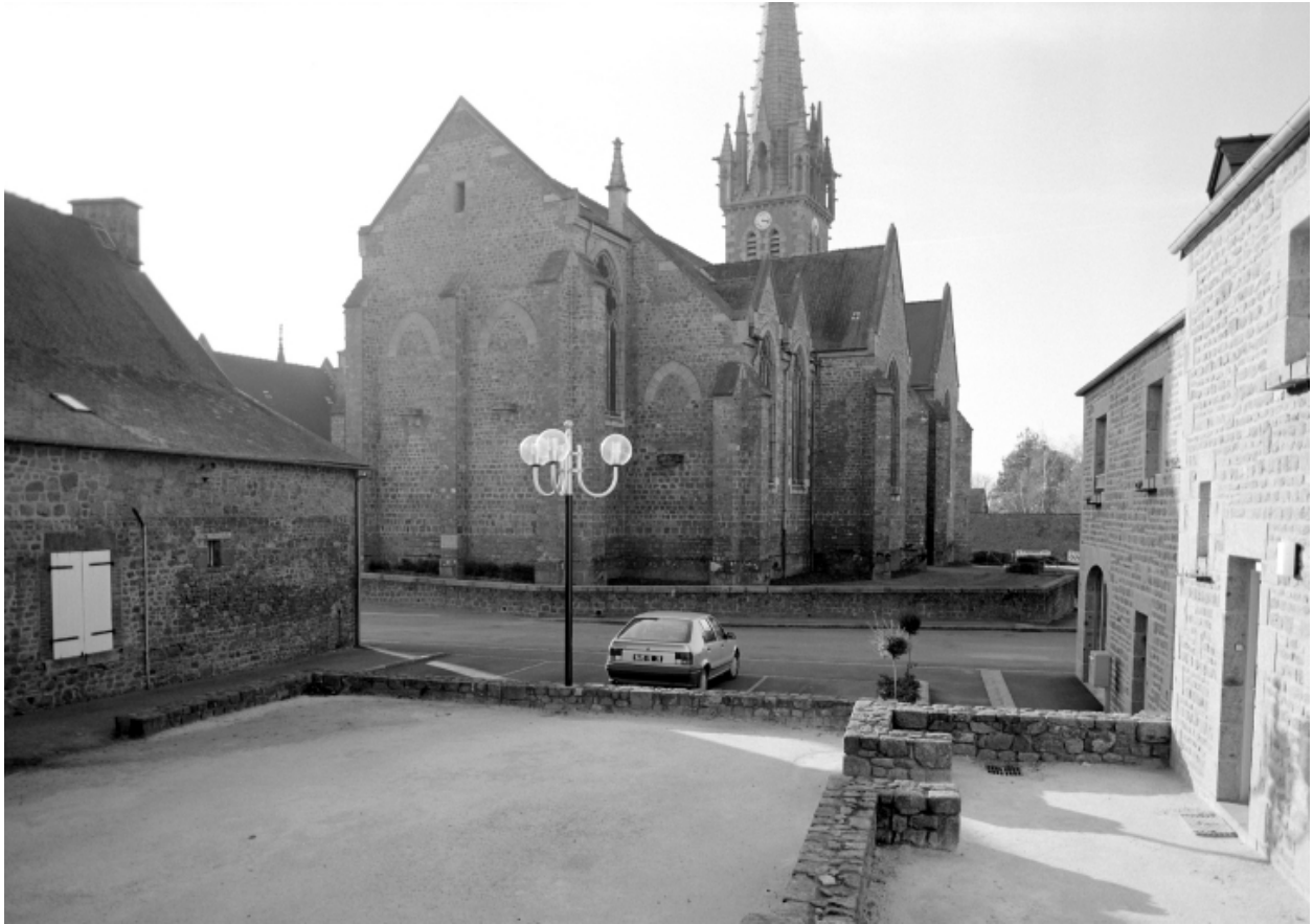
Elévation Est : vue générale
