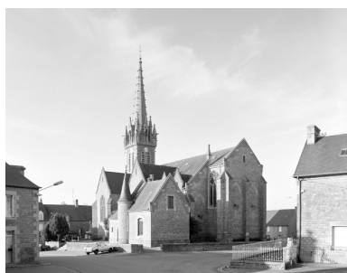
Elévation Sud-Est : vue générale Phot. Guy Artur, Phot. Norbert Lambart IVR53_19933500622X
