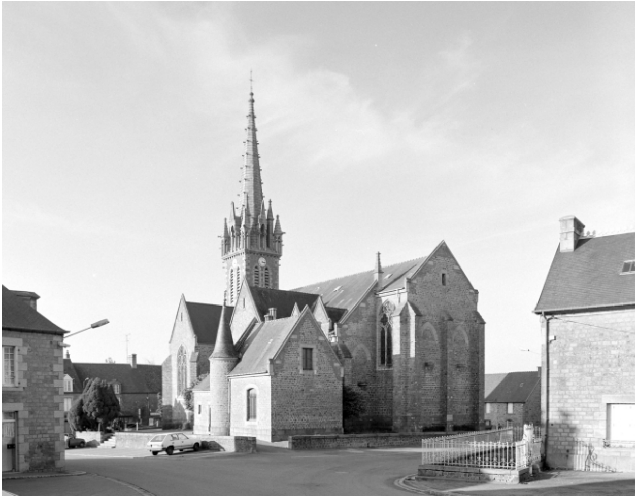
Elévation Sud-Est : vue générale
