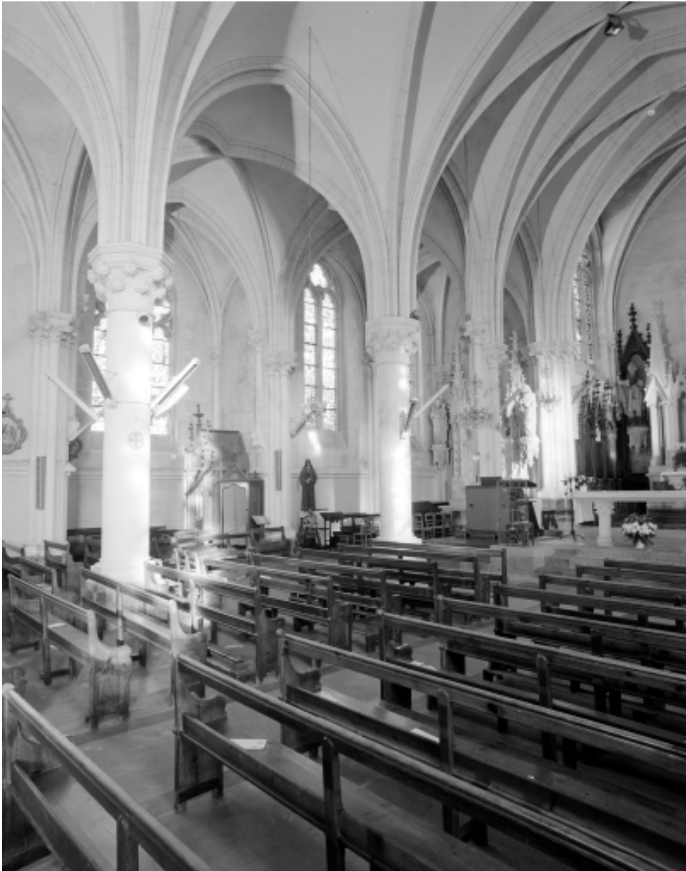
Intérieur, bas-côté Nord : vue générale.
