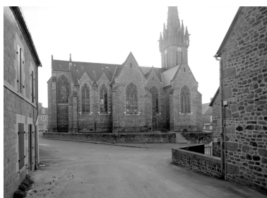
Elévation Nord : vue générale Phot. Guy Artur, Phot. Norbert Lambart IVR53_19933500624X
