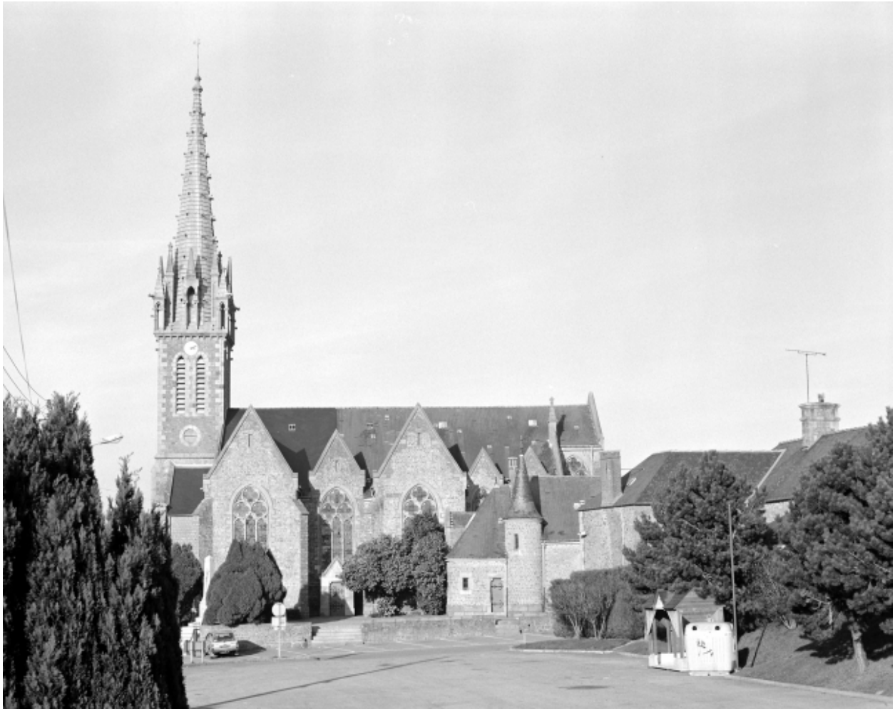
Elévation Sud : vue générale
