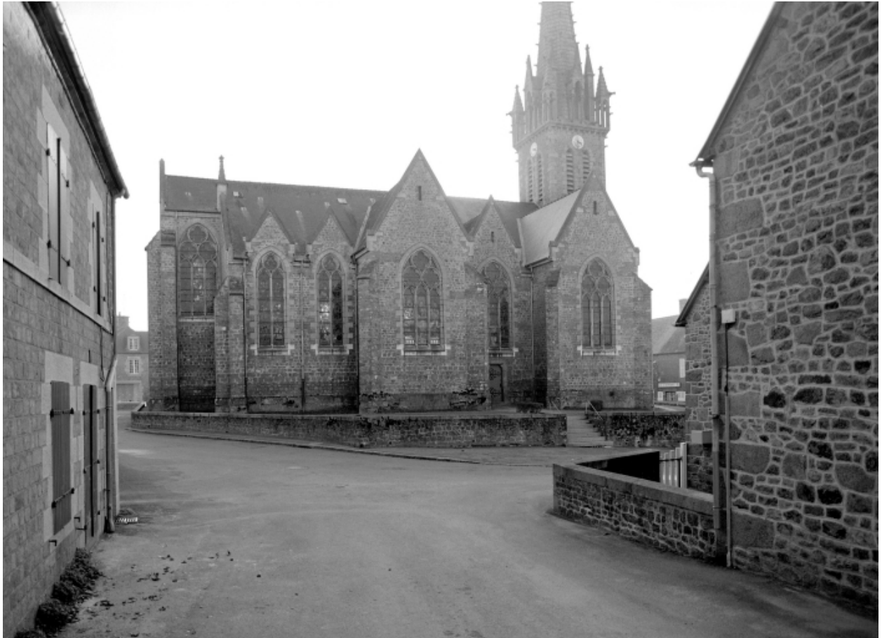
Elévation Nord : vue générale
