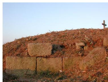
Vue du flanc du parapet en pierre de taille de granite (septembre 2002, après le débroussaillage de la batterie)
