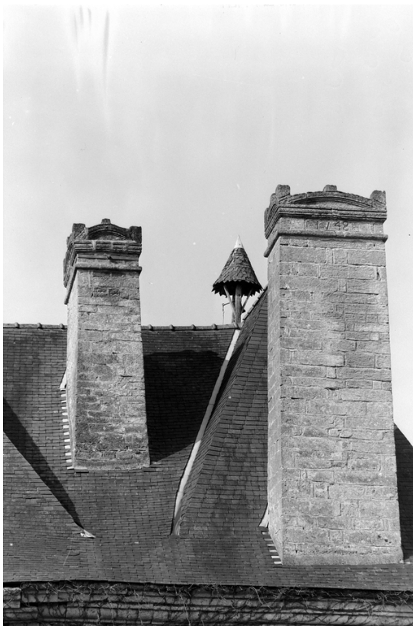
Pavillon d'angle : détail souches de cheminée
