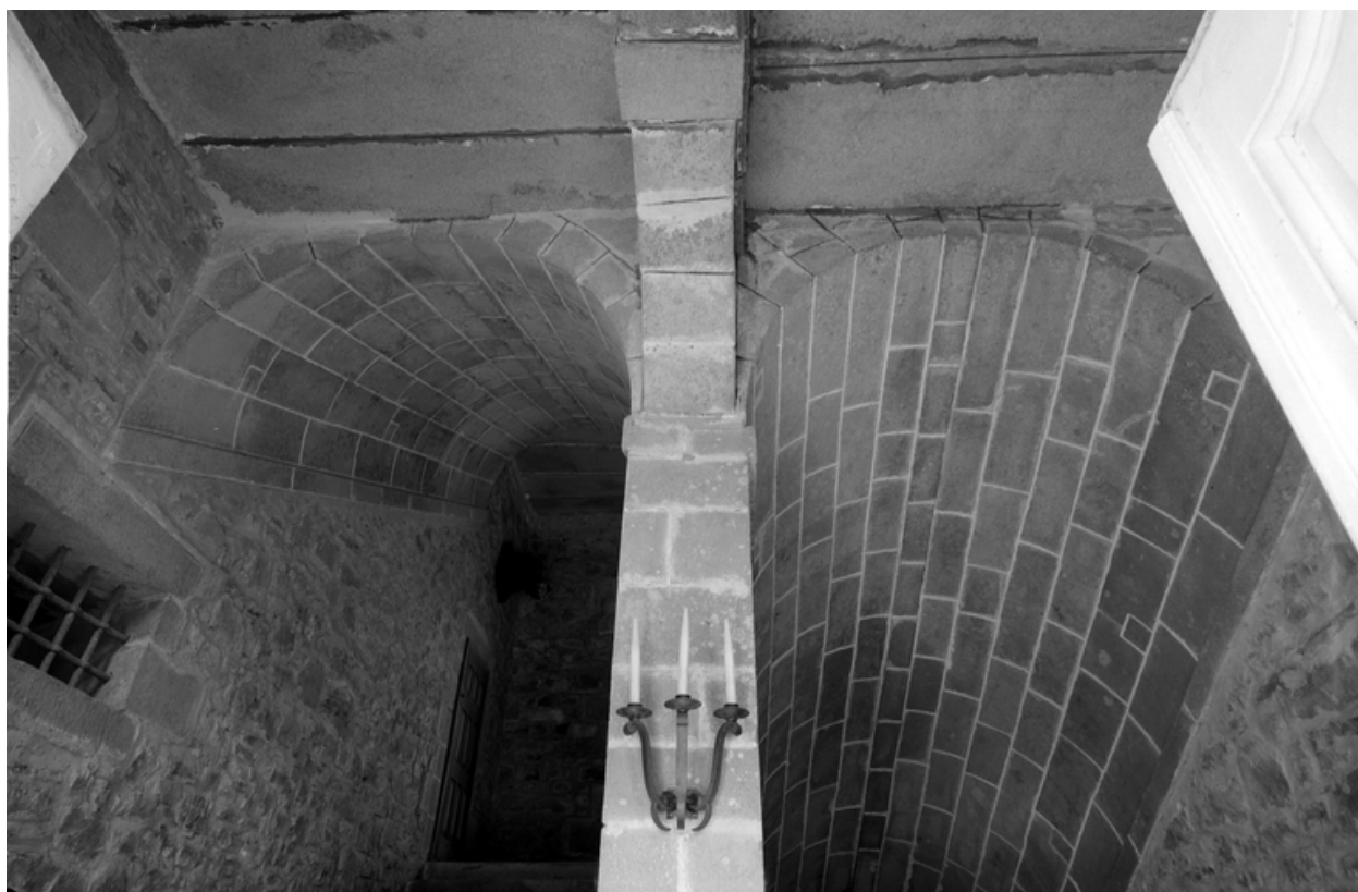
Voûtes de l'escalier et du couloir
