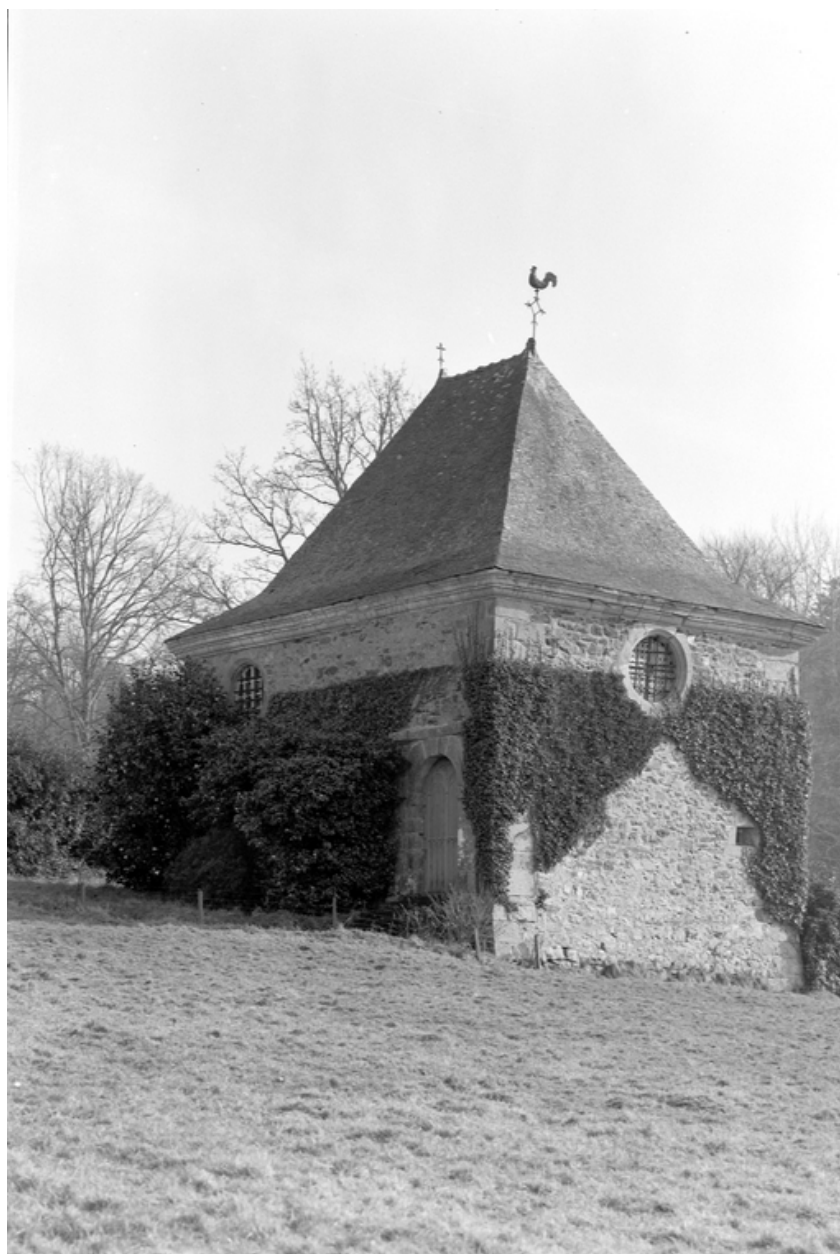
Chapelle : vue générale nord-ouest
