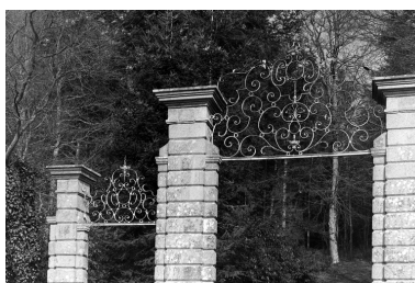
Portail du parc (nord est) : détail des grilles Phot. Guy Artur IVR53_19692200008V
