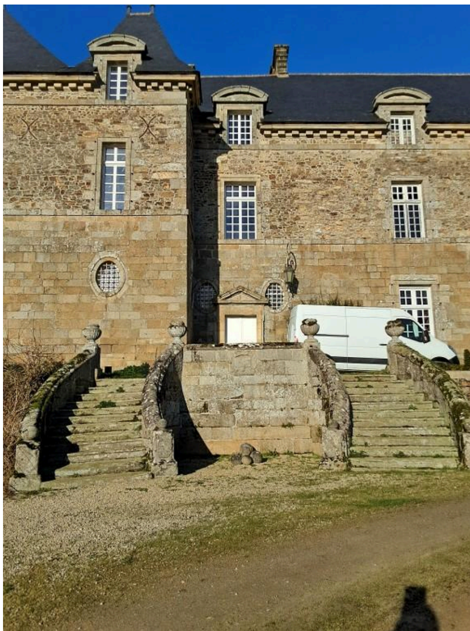
Façade sud, perron : escalier en fer à cheval
