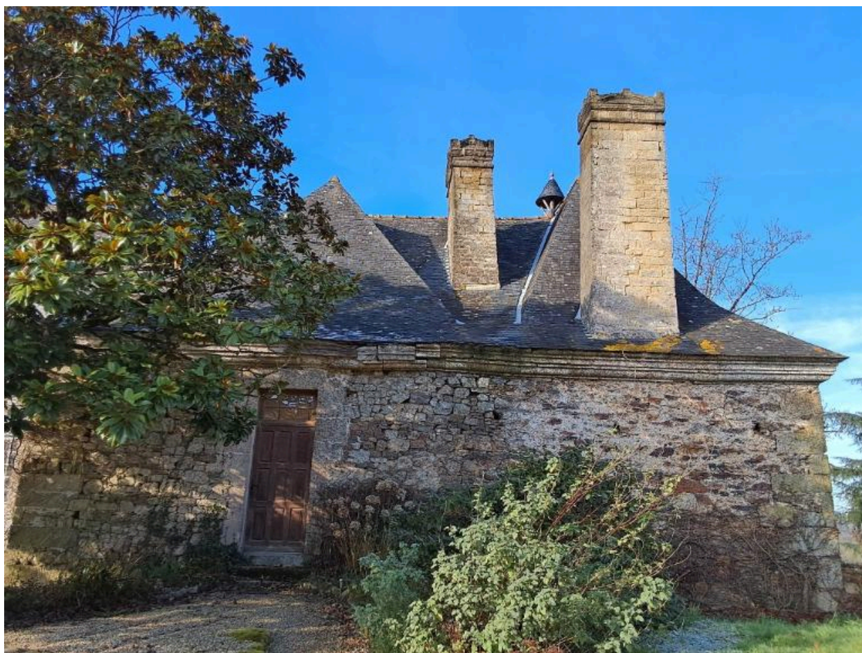
Pavillon en moellon mixte avec chaîne d'angle en granite, souche de cheminée en pierre de falun : détail date portée 1748
