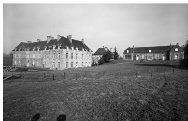
Vue générale sud est : château et orangerie Phot. Guy Artur IVR53_19692200014V
