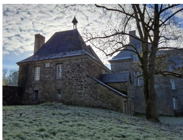
Pavillon, façade nord : toit pavillon avec campanile Phot. Flavie Dupont IVR53_20252210102NUCA
