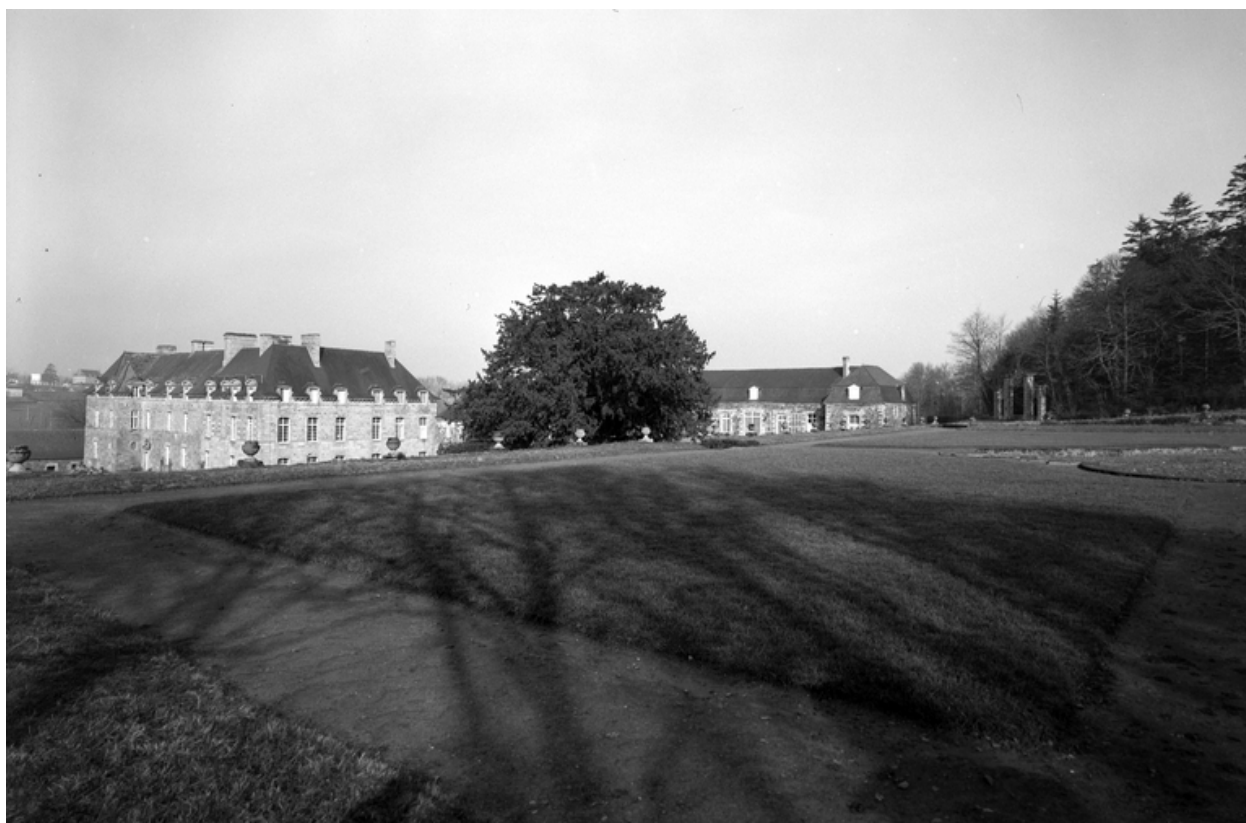
Vue de situation sud sud-est
