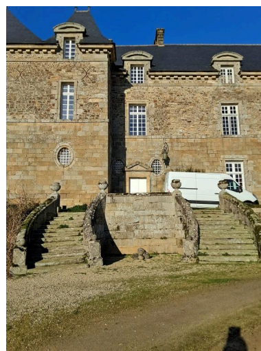
Façade sud, perron : escalier en fer à cheval Phot. Flavie Dupont IVR53_20252210094NUCA
