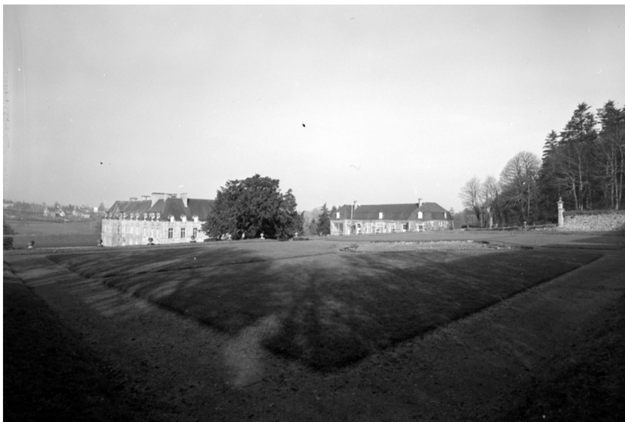
Vue de situation sud est
