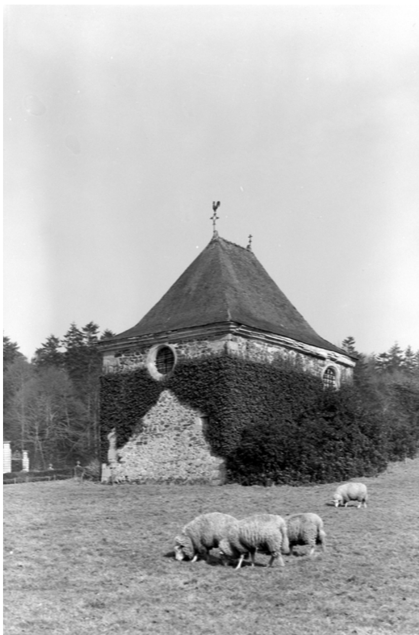
Chapelle : vue générale sud ouest
