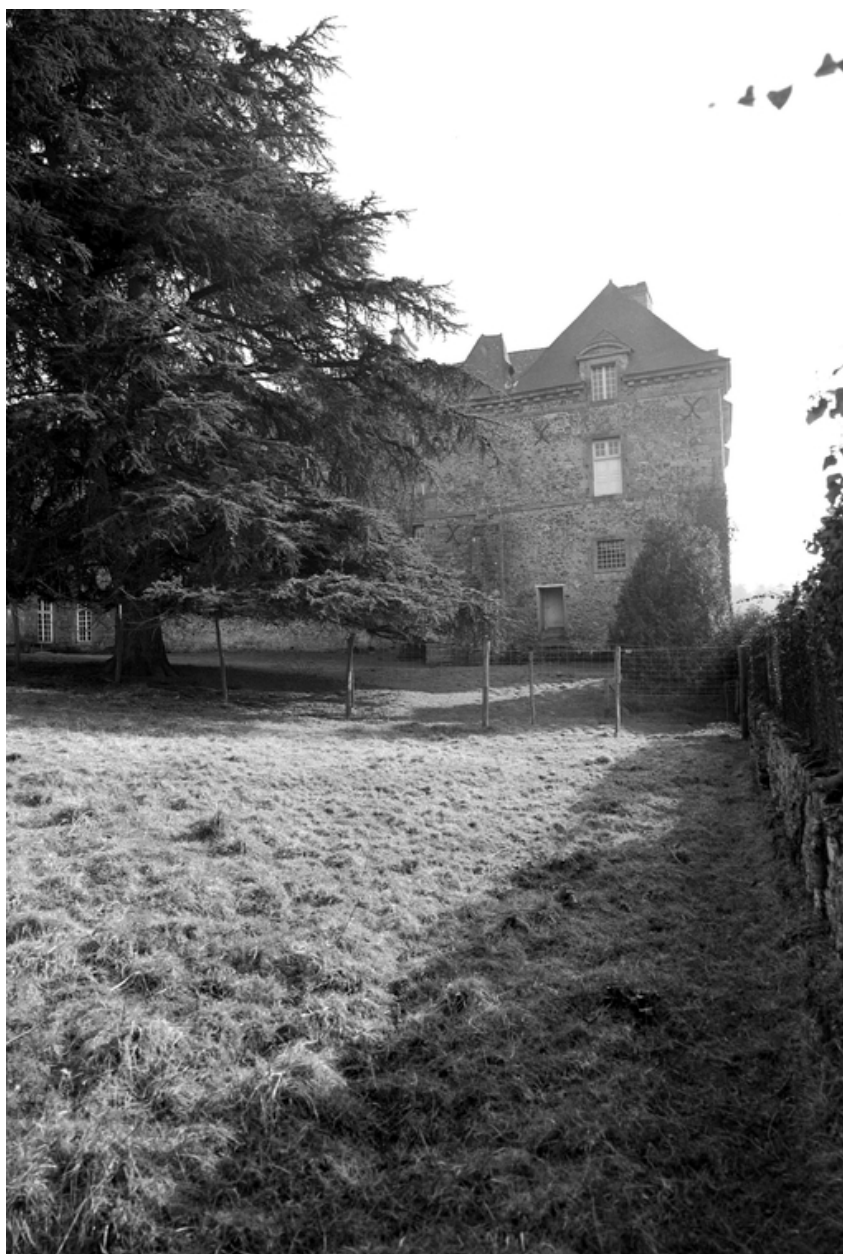
Château : façade nord, partie ouest
