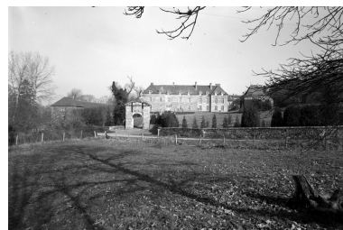
Vue de situation sud Phot. Guy Artur IVR53_19692200016V
