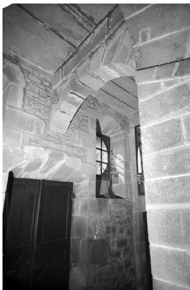
Escalier : détail de l'axe soutenant le palier du premier étage Phot. Guy Artur IVR53_19692200042V
