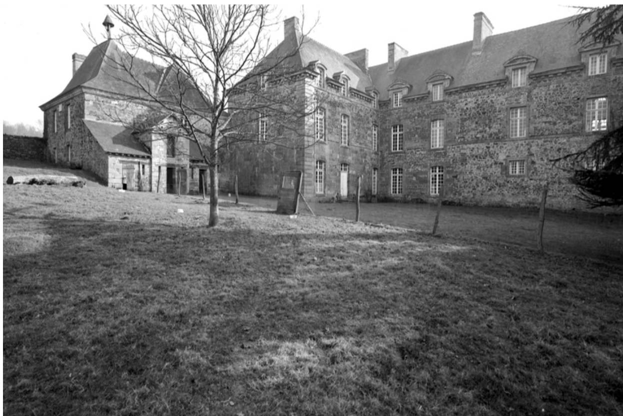
Château : façade nord, partie est
