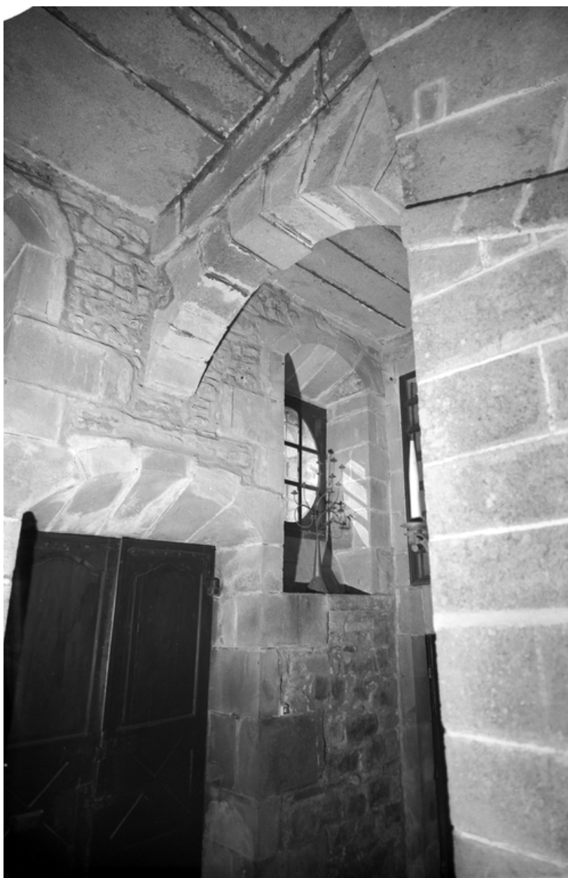
Escalier : détail de l'axe soutenant le palier du premier étage
