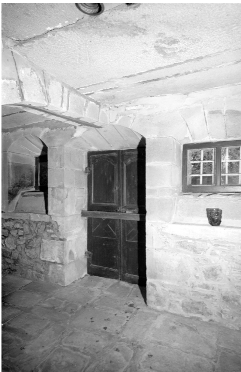
Ouvertures de la façade nord : vue intérieure
