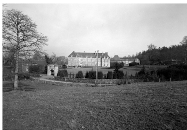
Vue de situation sud Phot. Guy Artur IVR53_19692200020V
