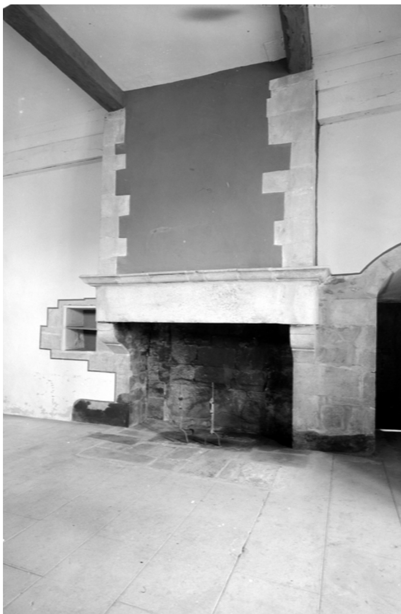
Cheminée (pièce III) : vue générale
