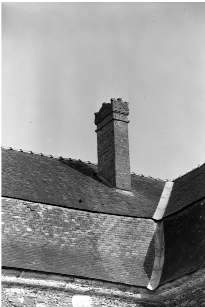
Orangerie : détail souche de cheminée est
