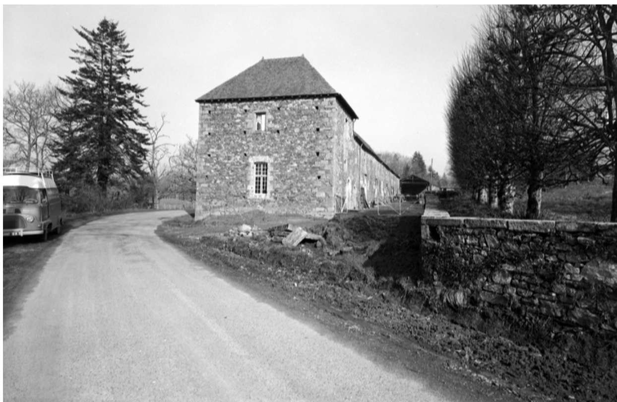
Dépendances : vue générale sud
