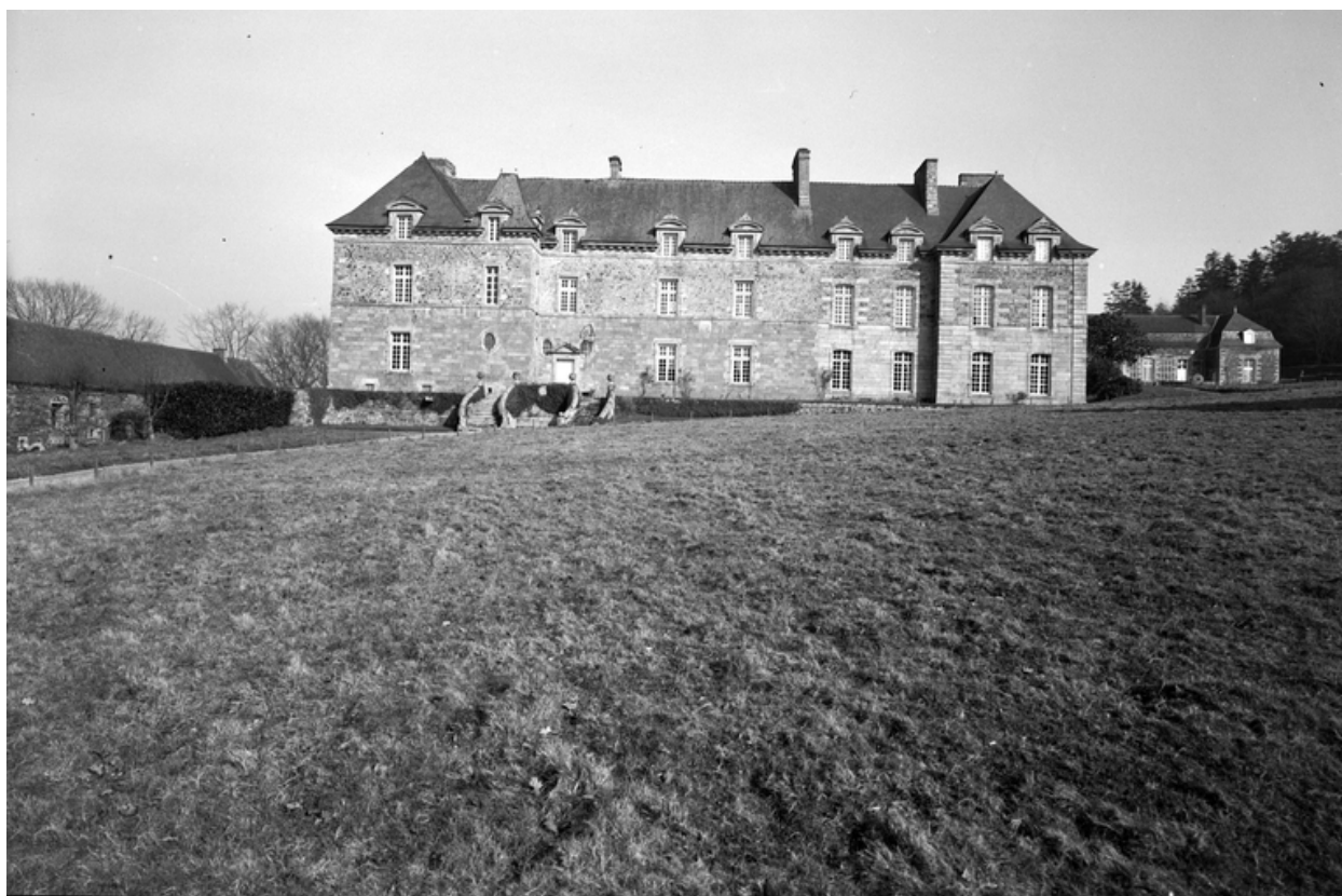
Façade sud : vue générale
