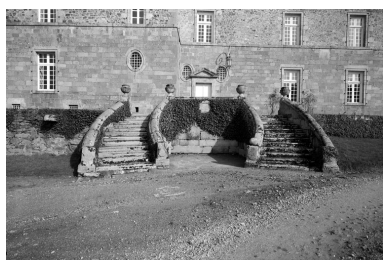
Château : façade sud, détail de l'escalier Phot. Guy Artur IVR53_19692200018V
