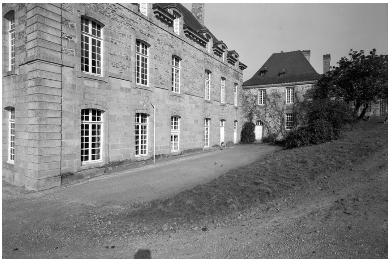
Château et pavillon d'angle : vue sud ouest
