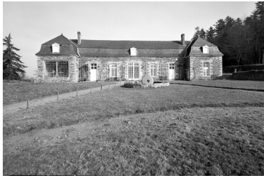
Orangerie : façade sud, vue générale Phot. Guy Artur IVR53_19692200026V
