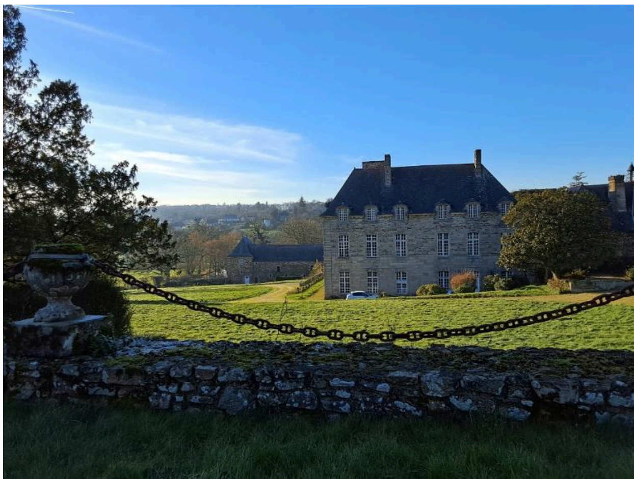
Terrasses médiévales, château : façade est
