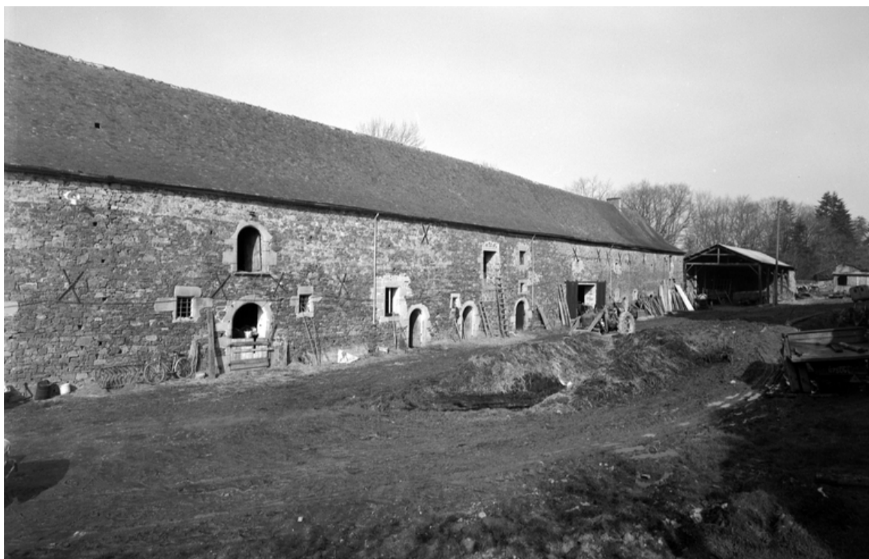
Dépendances : façade est, vue générale
