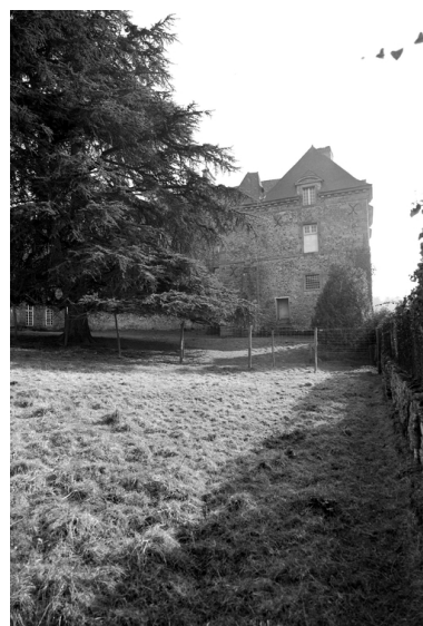
Château : façade nord, partie ouest Phot. Guy Artur IVR53_19692200032V
