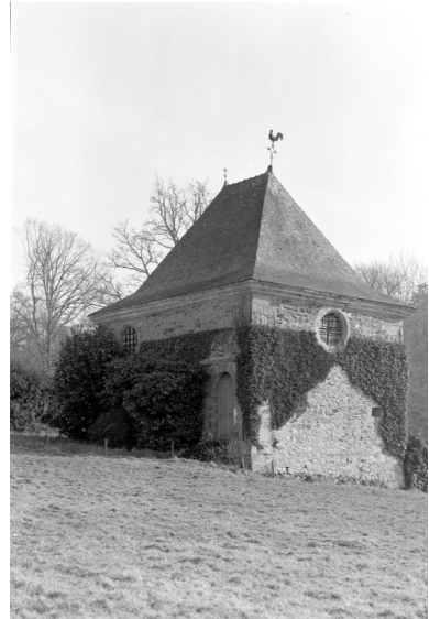
Chapelle : vue générale nord-ouest Phot. Guy Artur IVR53_19692200010V
