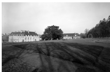
Vue de situation sud sud-est Phot. Guy Artur IVR53_19692200019V
