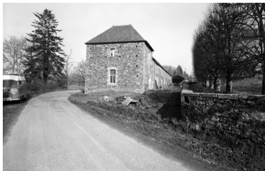
Dépendances : vue générale sud Phot. Guy Artur IVR53_19692200017V
