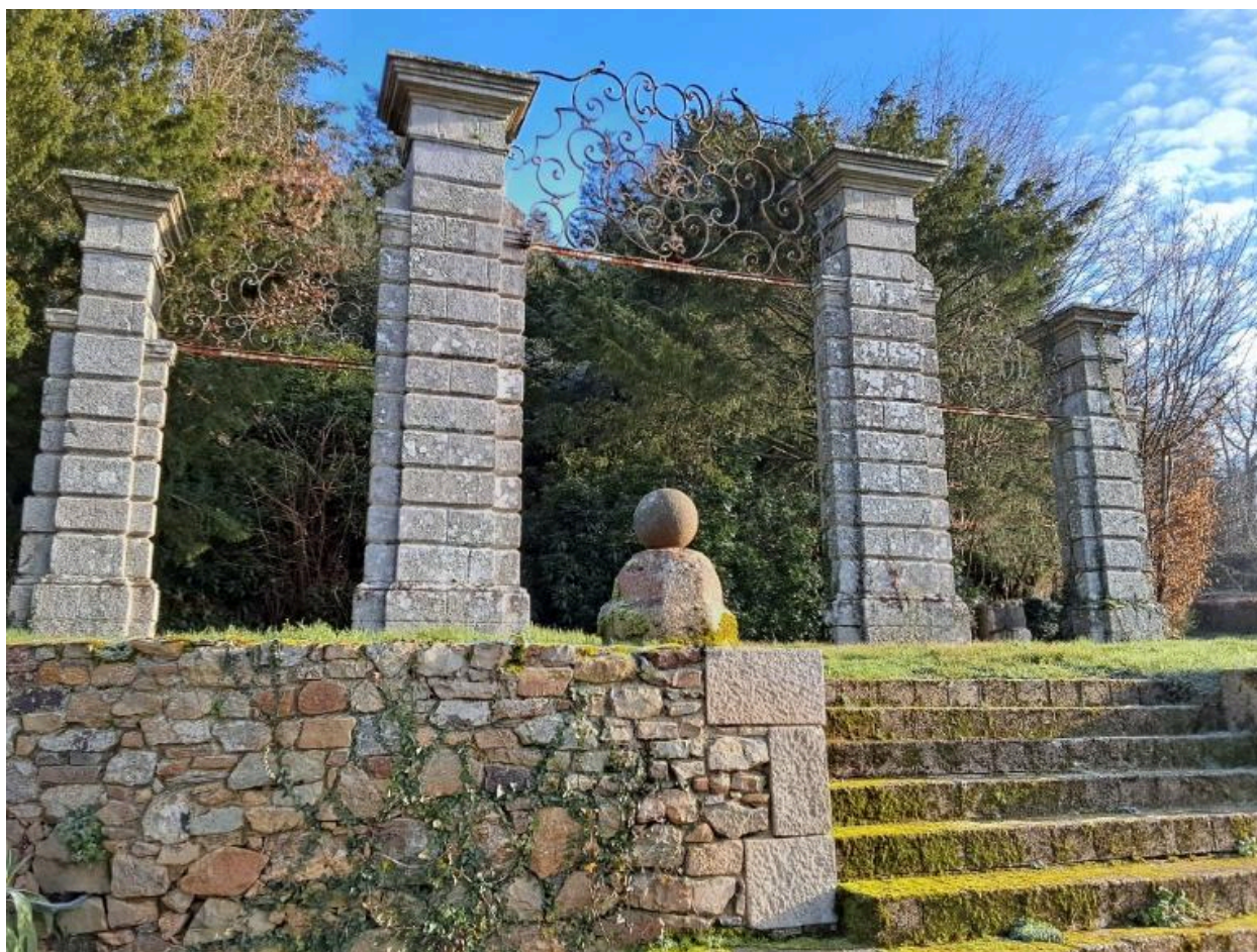
Portail en granite issu du château du Lattay (Guenroc)
