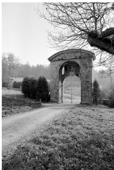
Portail sud : face nord, vue générale Phot. Guy Artur IVR53_19692200033V
