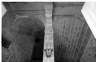
Voûtes de l'escalier et du couloir Phot. Guy Artur IVR53_19692200040V
