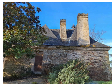
Pavillon en moellon mixte avec chaîne d'angle en granite, souche de cheminée en pierre de falun : détail date portée 1748 Phot. Flavie Dupont IVR53_20252210103NUCA
