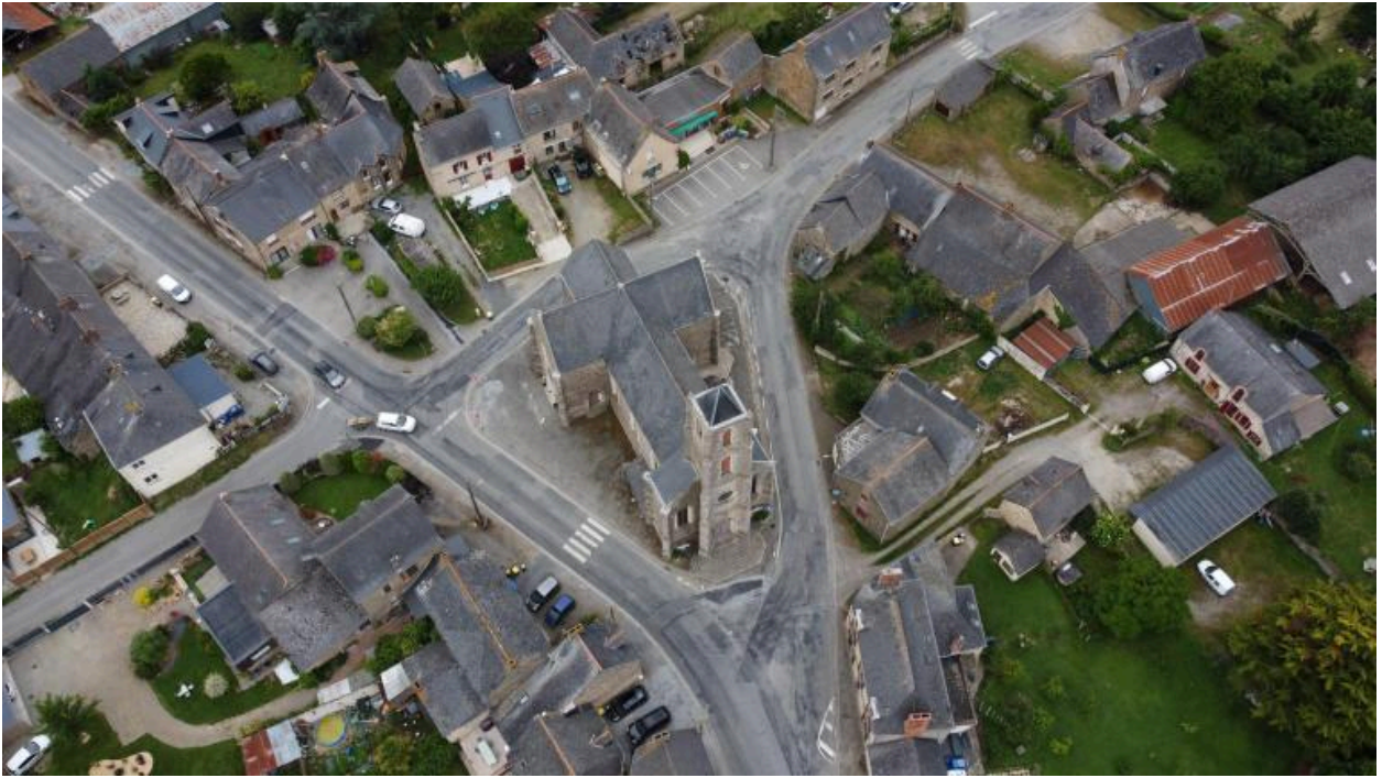
Vue aérienne du centre bourg
