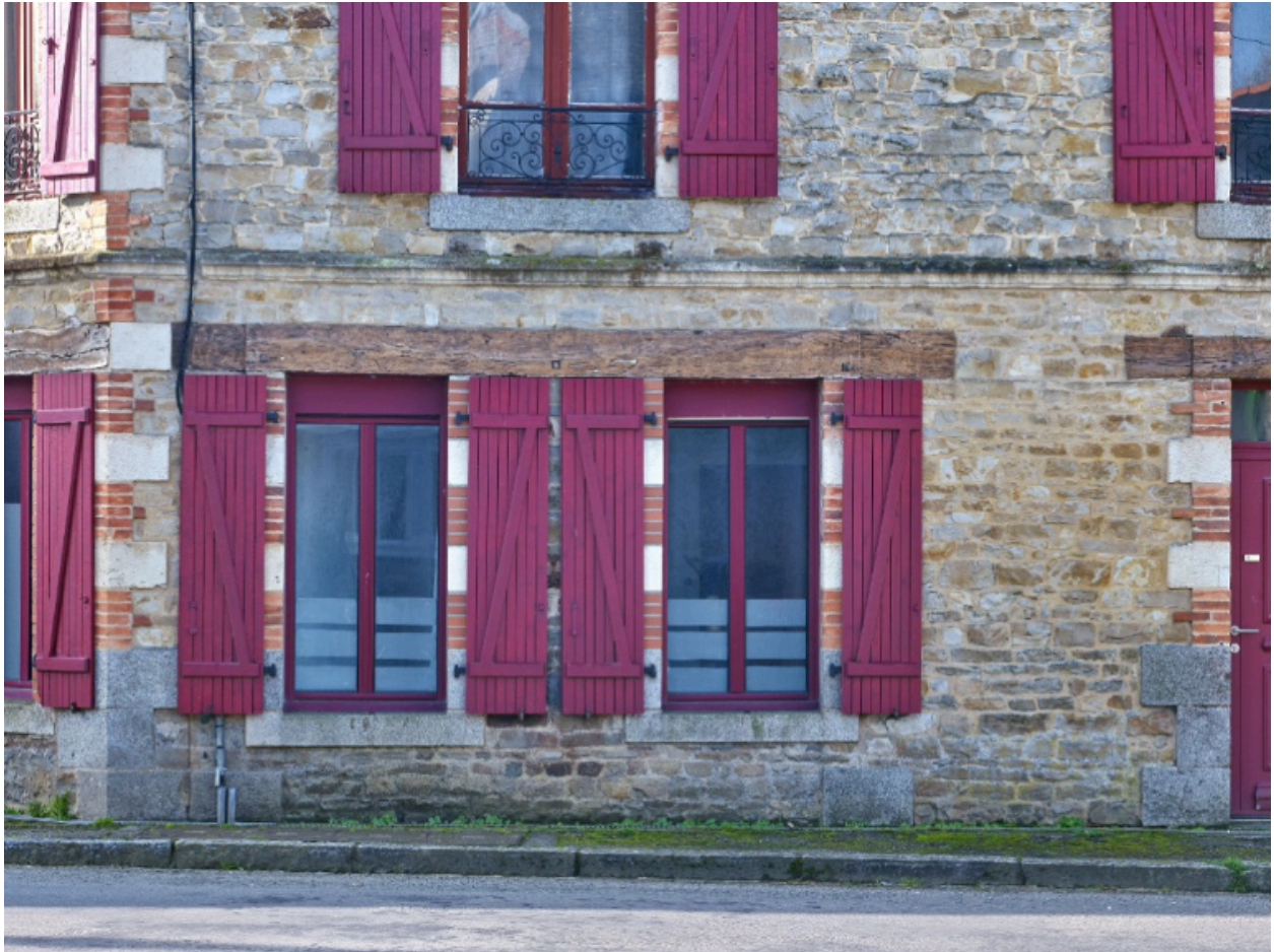
Détail de la façade de l'ancienne épicerie Robert avec linteau bois de grande longueur (ancienne vitrine)
