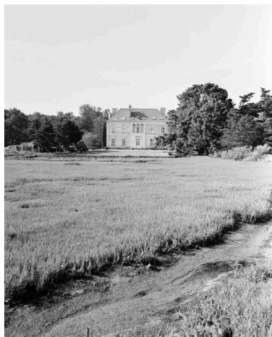
Vue générale nord. Phot. Guy Artur, Phot. Norbert Lambart IVR53_19935601914X
