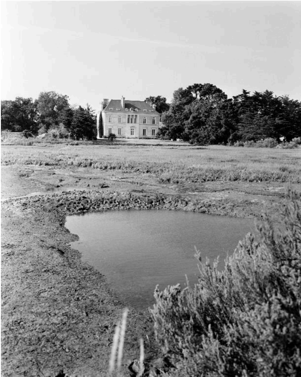
Vue générale nord.
