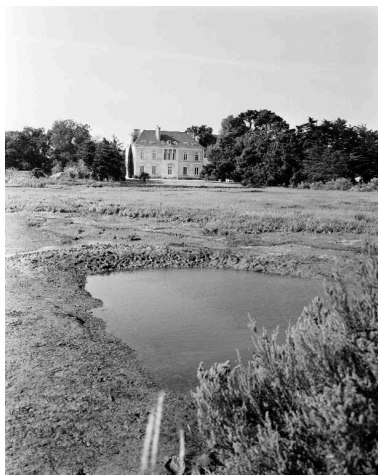
Vue générale nord. Phot. Guy Artur, Phot. Norbert Lambart IVR53_19935601913X
