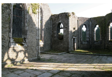
Berrien, chapelle Sainte-Barbe : vue transversale nord-est Phot. Gwénaél Fauchille IVR53_20082906731NUCA
