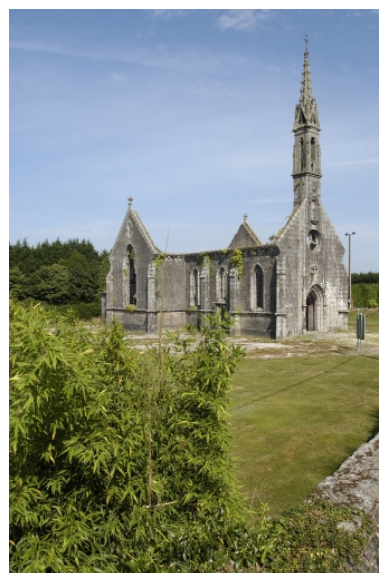
Berrien, chapelle Sainte- Barbe : vue générale nord-ouest Phot. Gwénaél Fauchille IVR53_20082906726NUCA
