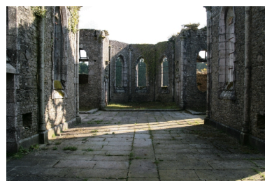
Berrien, chapelle Sainte-Barbe : vue axiale est Phot. Gwénaél Fauchille IVR53_20082906729NUCA
