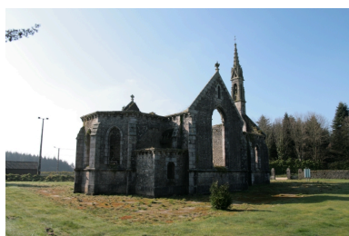
Berrien, chapelle Sainte-Barbe : vue générale nord-est Phot. Gwénaél Fauchille IVR53_20082906727NUCA
