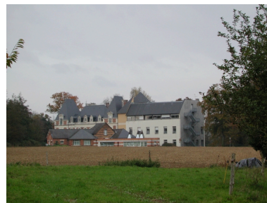
Vue de situation sud Phot. Claude Quillivic IVR53_20013515851NUCA
