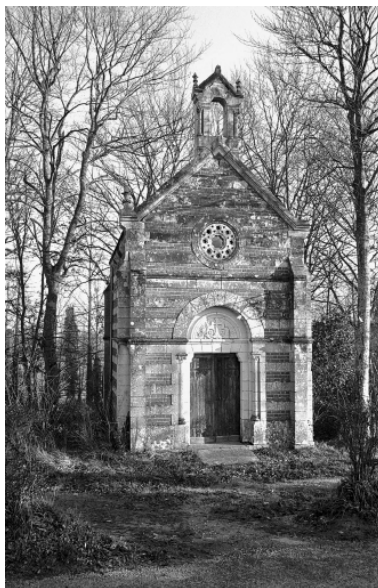
Chapelle ; état en 1975 Phot. Christel Douard IVR53_19753500615Z
