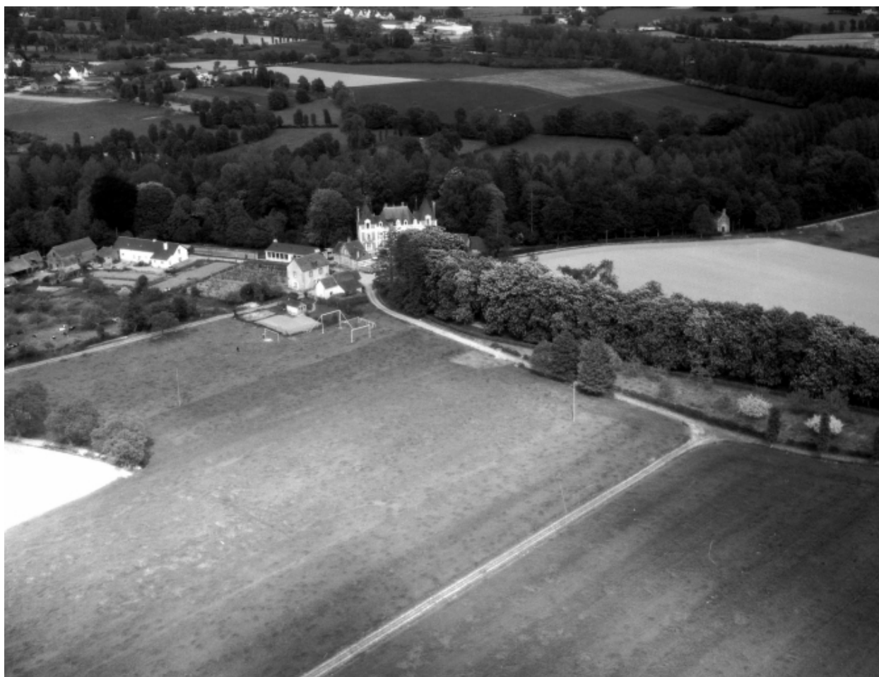
Vue aérienne vers le nord
