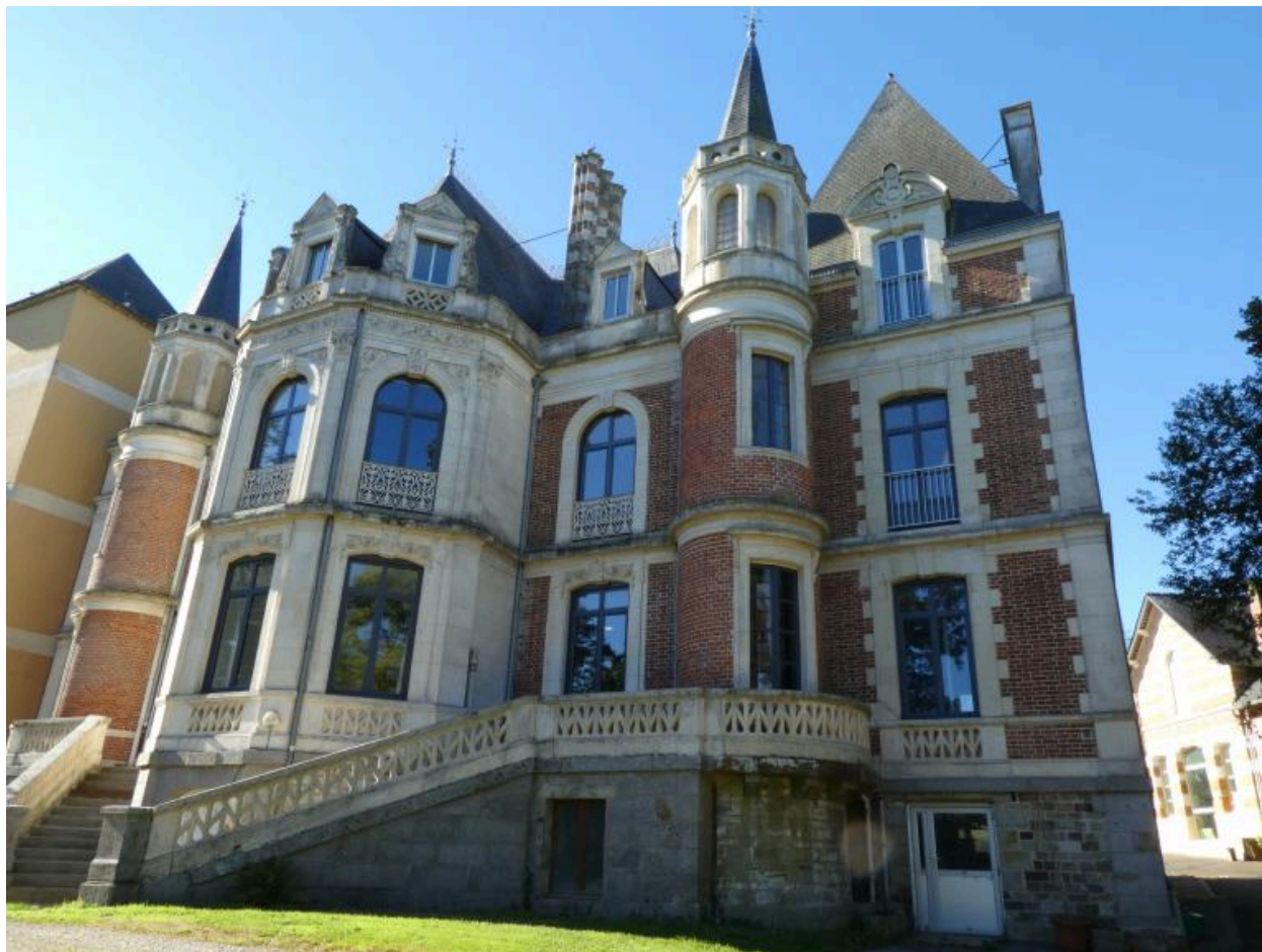
Etat actuel de la façade Nord du château (2018)
