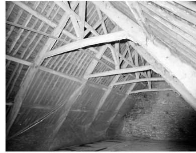
Charpente : vue générale. Phot. Auteur inconnu IVR53_19902200691X
