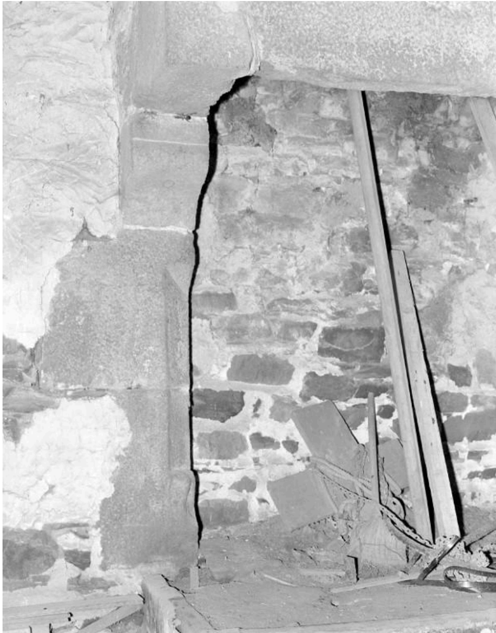
Intérieur, rez-de-chaussée, cheminée : détail d'un piédroit.
