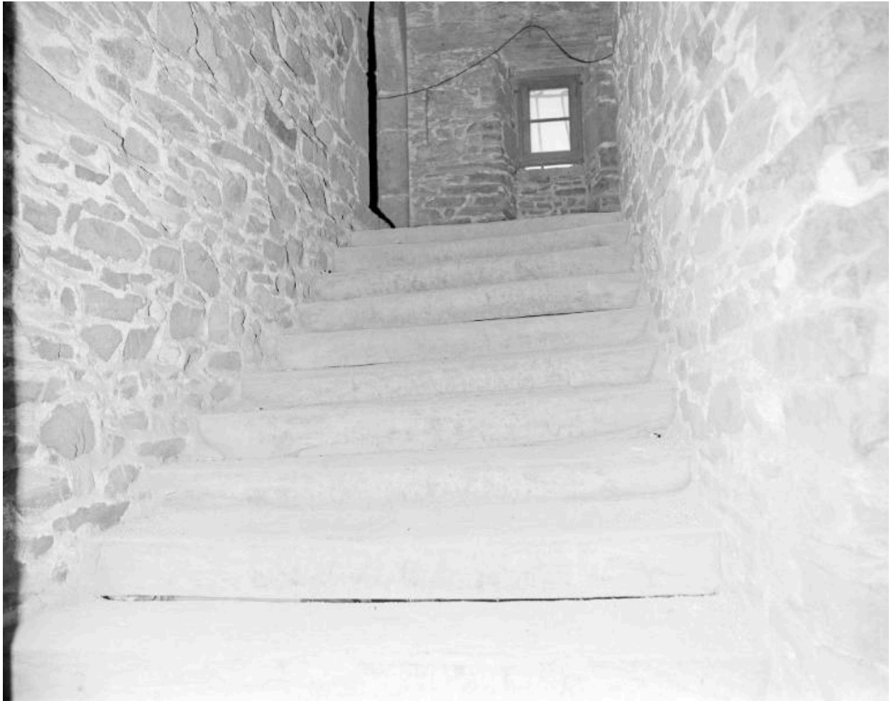
Intérieur, volée d'escalier.
