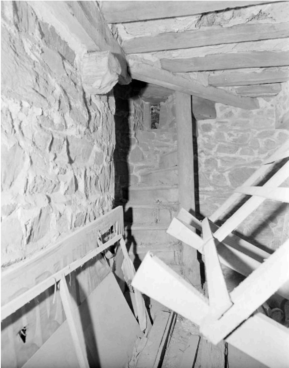
Intérieur, détail : escalier des combles.
