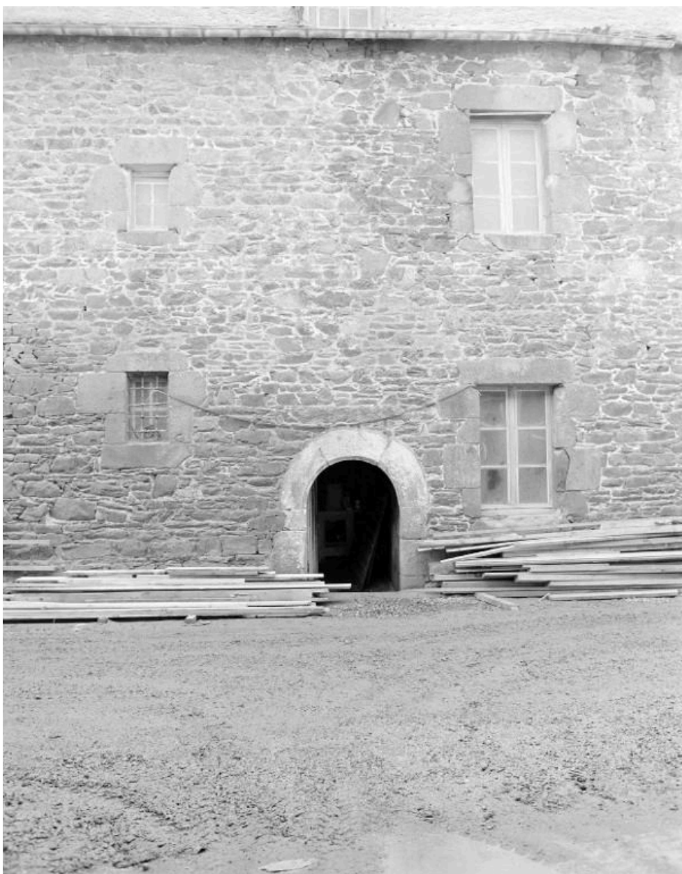
Façade principale, détail : ouvertures.
