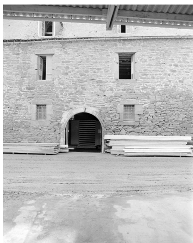
Façade principale, détail : ouvertures. Phot. Auteur inconnu IVR53_19902200673X
