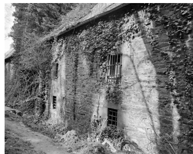
Façade postérieure : vue générale. Phot. Auteur inconnu IVR53_19902200676X
