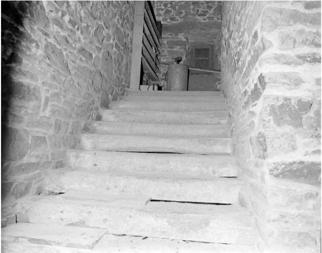
Intérieur, volée d'escalier.
