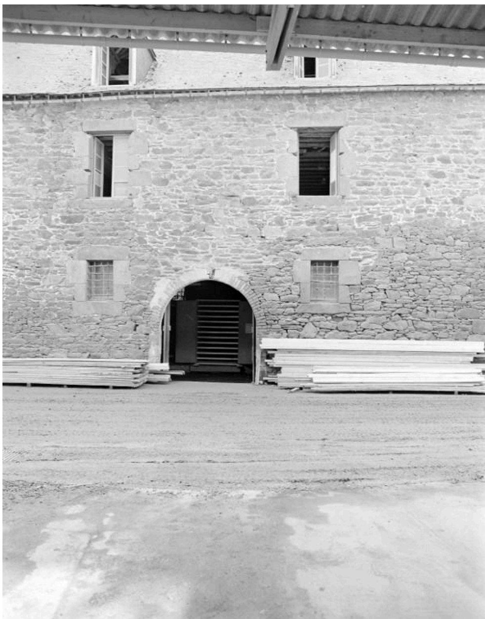
Façade principale, détail : ouvertures.
