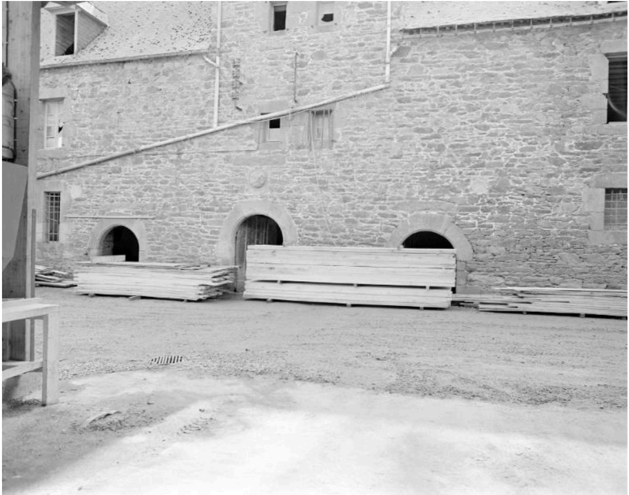
Façade principale, partie centrale : ouvertures.
