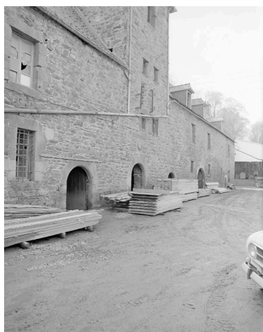
Façade principale : vue générale prise de gauche. Phot. Auteur inconnu IVR53_19902200680X
