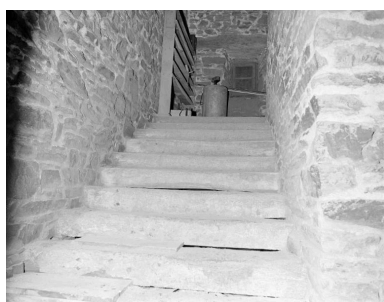
Intérieur, volée d'escalier. Phot. Auteur inconnu IVR53_19902200688X
