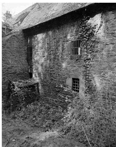
Façade postérieure : partie centrale. Phot. Auteur inconnu IVR53_19902200674X
