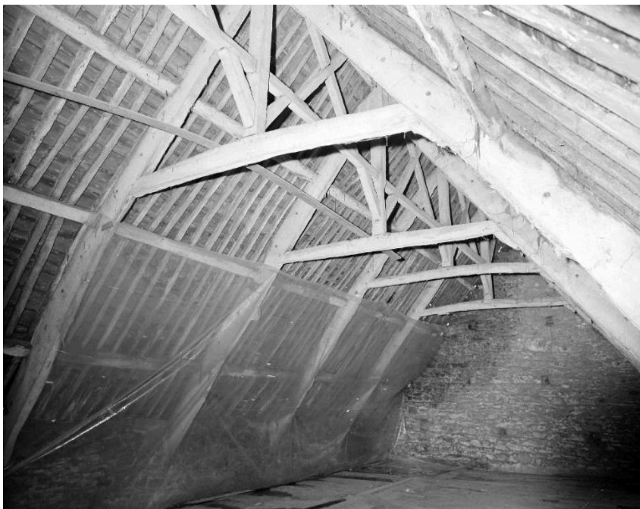
Charpente : vue générale.
