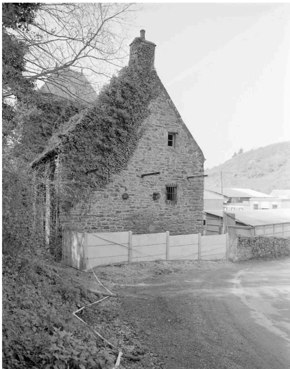
Pignon est : vue générale.
