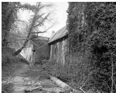
Façade postérieure : vue générale. Phot. Auteur inconnu IVR53_19902200677X
