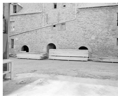
Façade principale, partie centrale : ouvertures. Phot. Auteur inconnu IVR53_19902200679X
