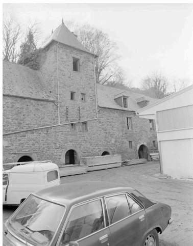
Façade principale : tour à usage d'observation des entrées et sorties des navires Phot. Auteur inconnu IVR53_19902200678X
