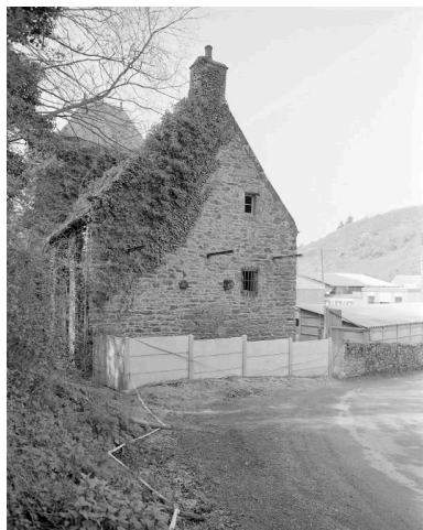
Pignon est : vue générale. Phot. Auteur inconnu IVR53_19902200681X
