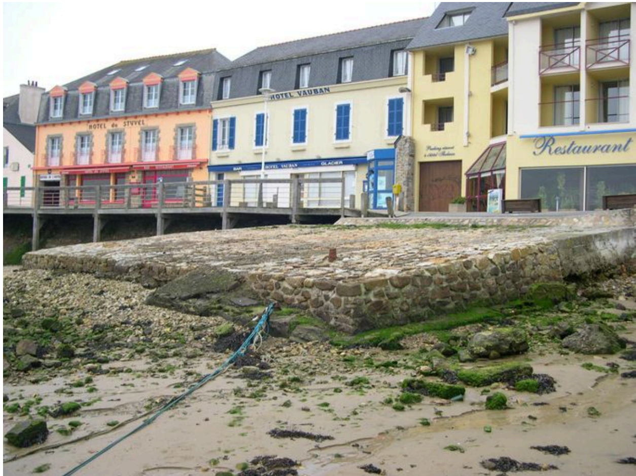
Vue générale de la cale du Styvel
