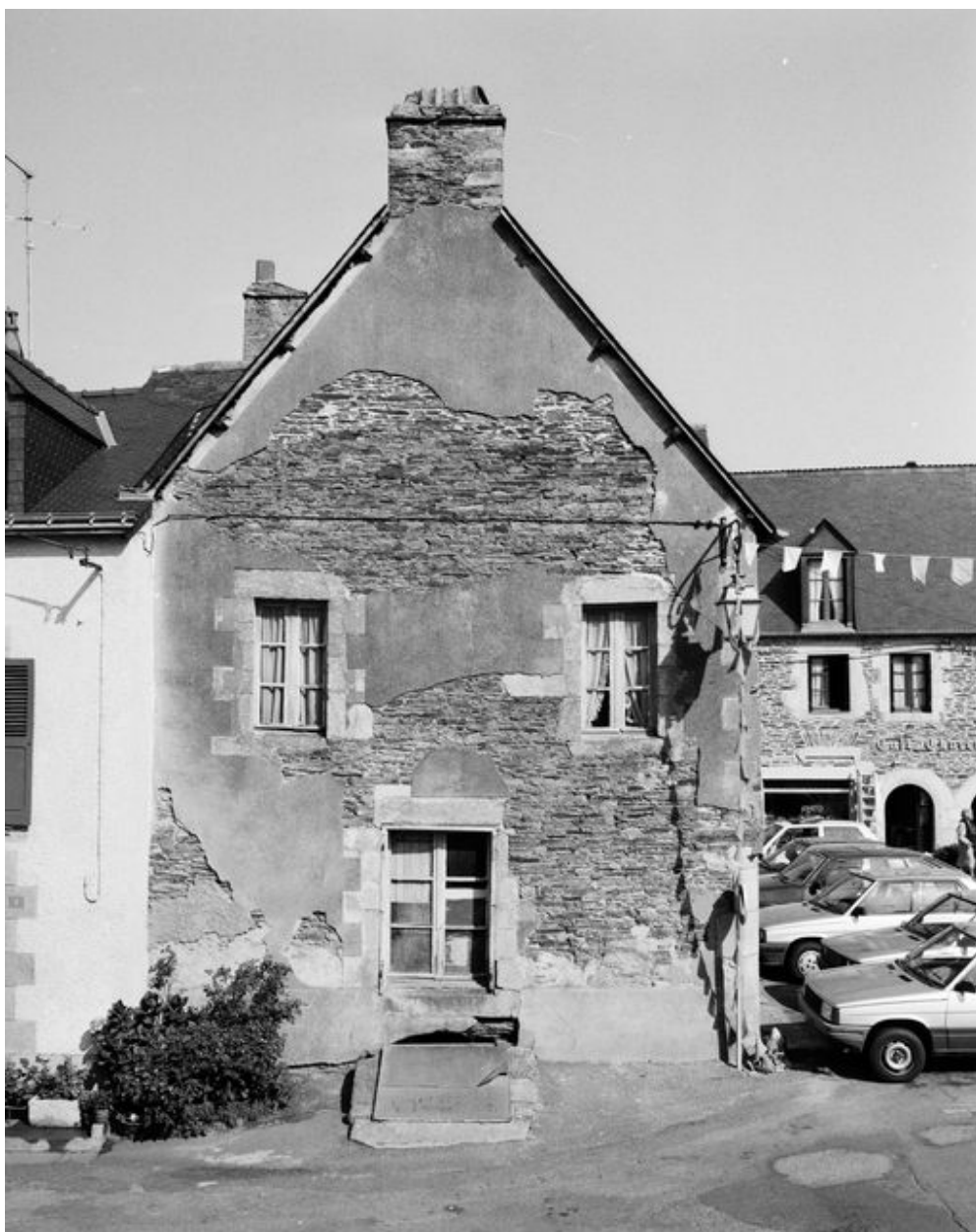
Maison de commerçant : pignon sud (état en 1992)
