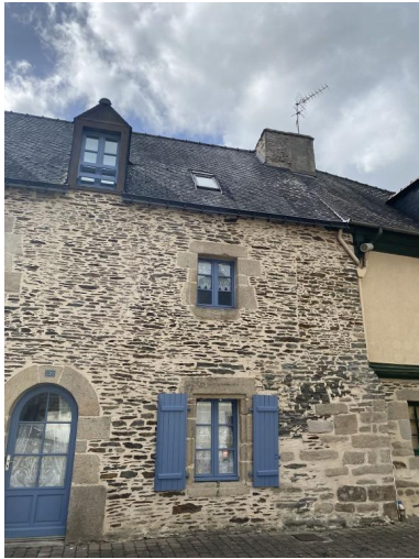
façade est, détail Phot. Baptiste Oligo IVR53_20255610770NUCA
