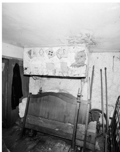
Maison de commerçant, premier étage : cheminée sur le mur gouttereau ouest (état en 1992) Phot. Guy Artur, Phot. Norbert Lambart IVR53_19925601449X
