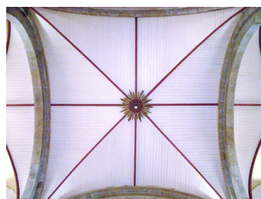
Lannilis, église paroissiale : détail du lambris à la croisée du transept Phot. Gwénaél Fauchille IVR53_20082906133NUCA
