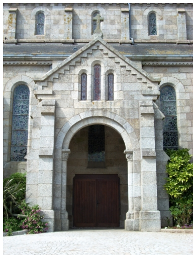
Lannilis, église paroissiale : vue du porche sud Phot. Gwénaél Fauchille IVR53_20082906128NUCA
