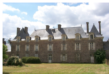
Corps principal, façade sur cour : vue partielle nord-ouest Phot. Xavier Gilbert IVR53_19993504002NUCA
