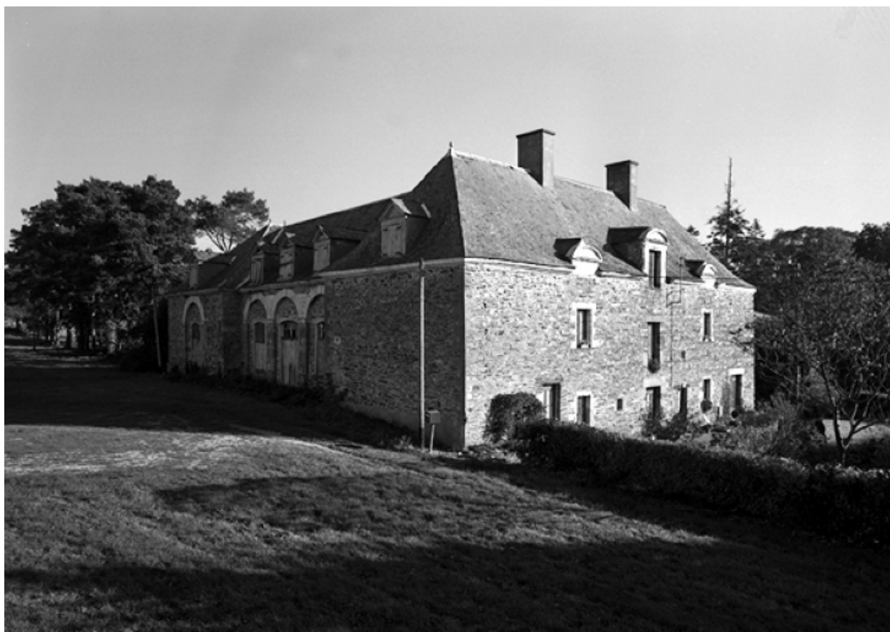
Le logis du métayer(?) et l'orangerie : vue générale sud-ouest
