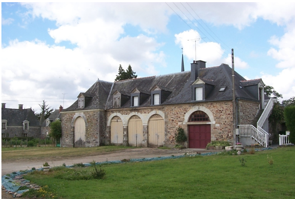
La remise à carrosses : vue générale nord-est
