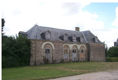
L'orangerie : vue générale nord-ouest Phot. Xavier Gilbert IVR53_19993504043NUCA
