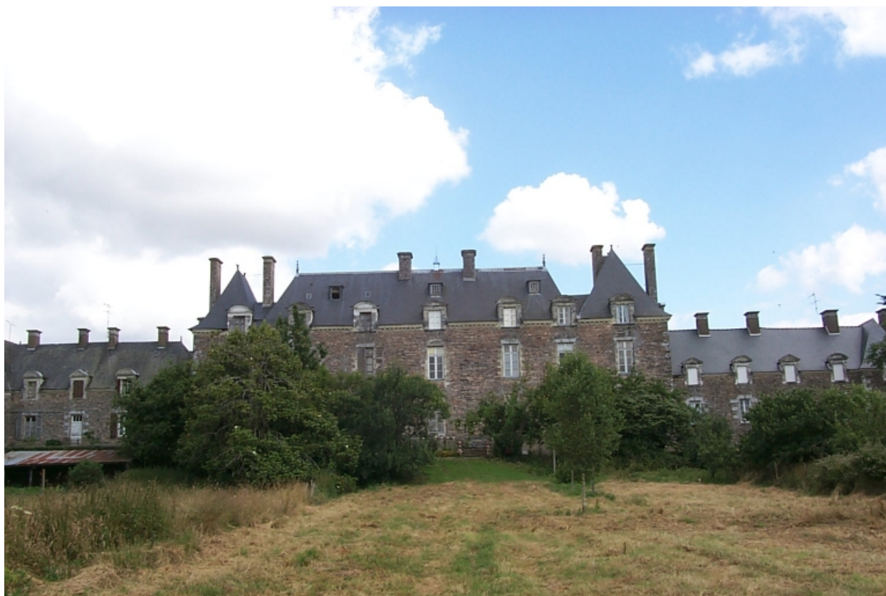
Corps principal, façade sur le parc : vue générale sud
