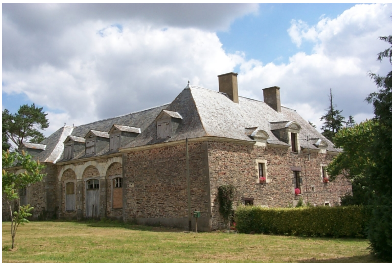
Le logis du métayer(?) et l'orangerie : vue générale sud-ouest
