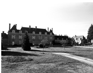
Corps principal, façade sur cour : vue générale nord Phot. Guy Artur, Phot. Norbert Lambart IVR53_19993509559X
