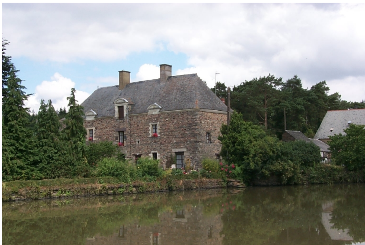
Le logis du métayer(?) et le miroir d'eau : vue générale sud-est
