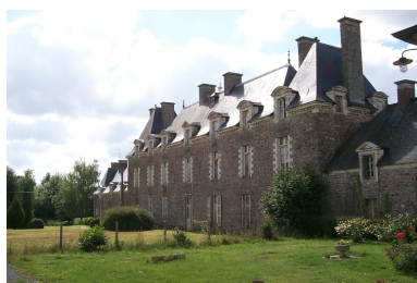
Corps principal, façade sur cour : vue partielle nord-ouest Phot. Xavier Gilbert IVR53_19993504059NUCA
