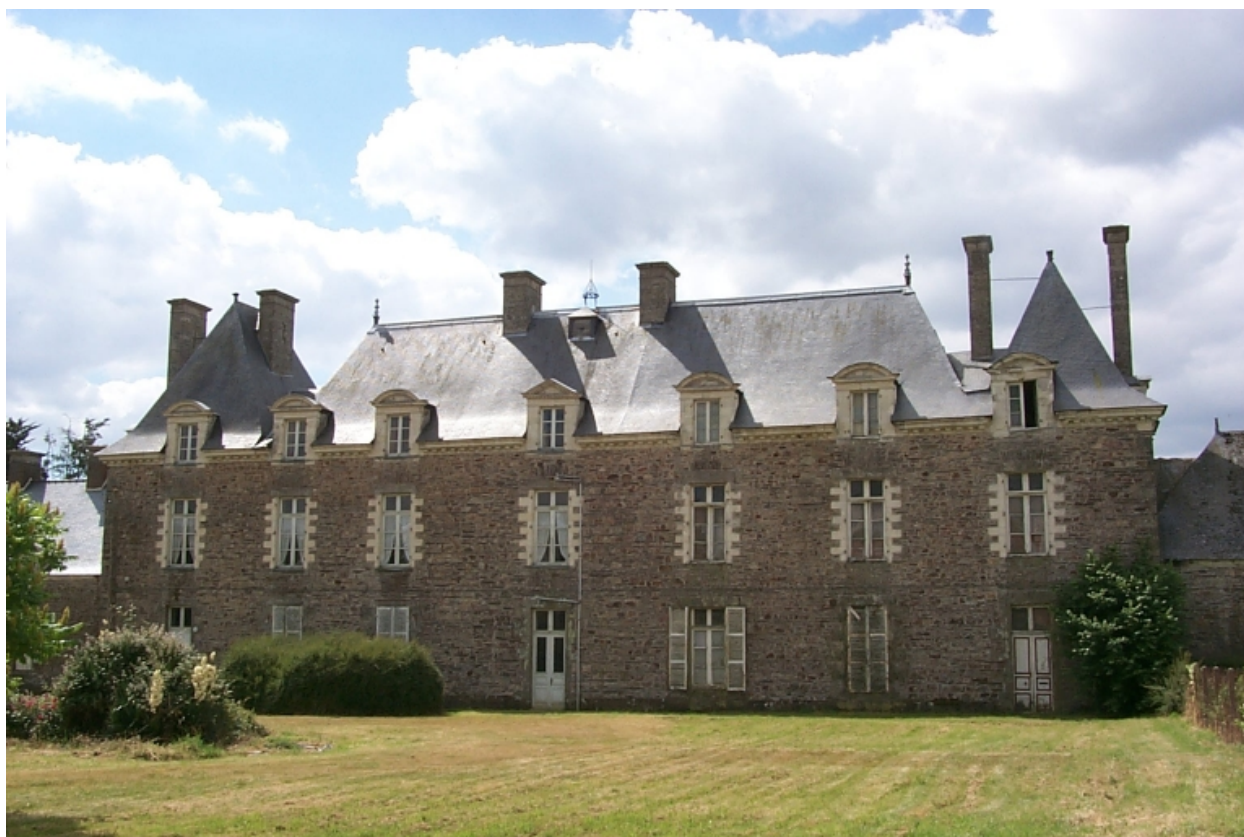
Corps principal, façade sur cour : vue partielle nord-ouest
