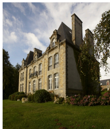
Élévation sud Phot. Norbert Lambart IVR53_20113503390NUCA
