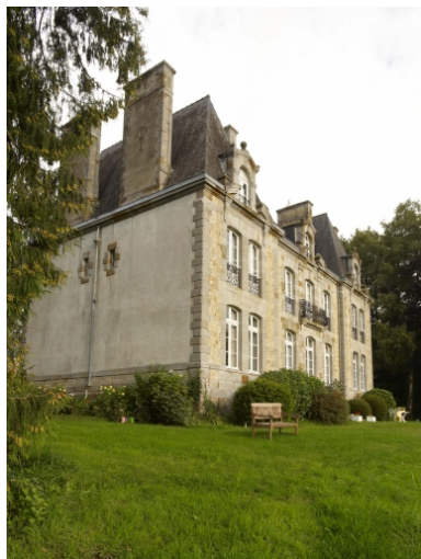
Elévation sud et pignon ouest Phot. Norbert Lambart IVR53_20113503391NUCA
