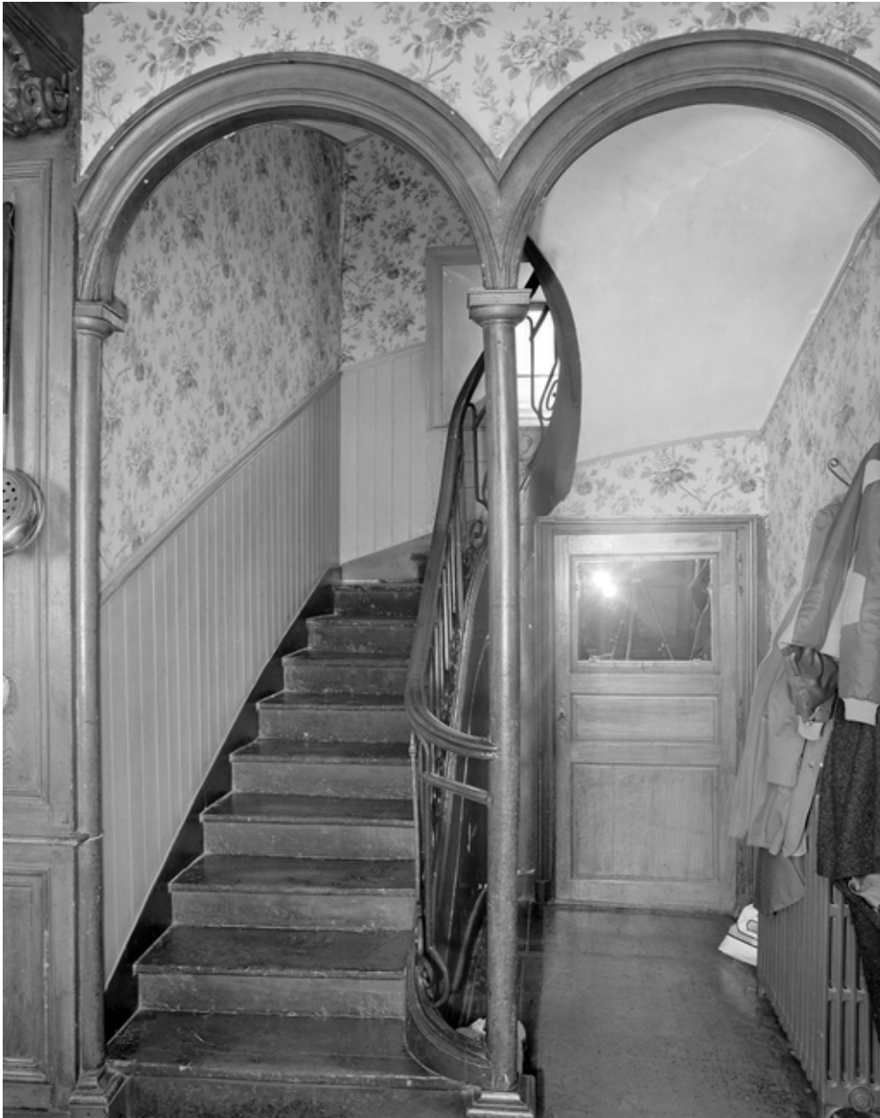
Vue générale du rez-de-chaussée avec l'escalier.
