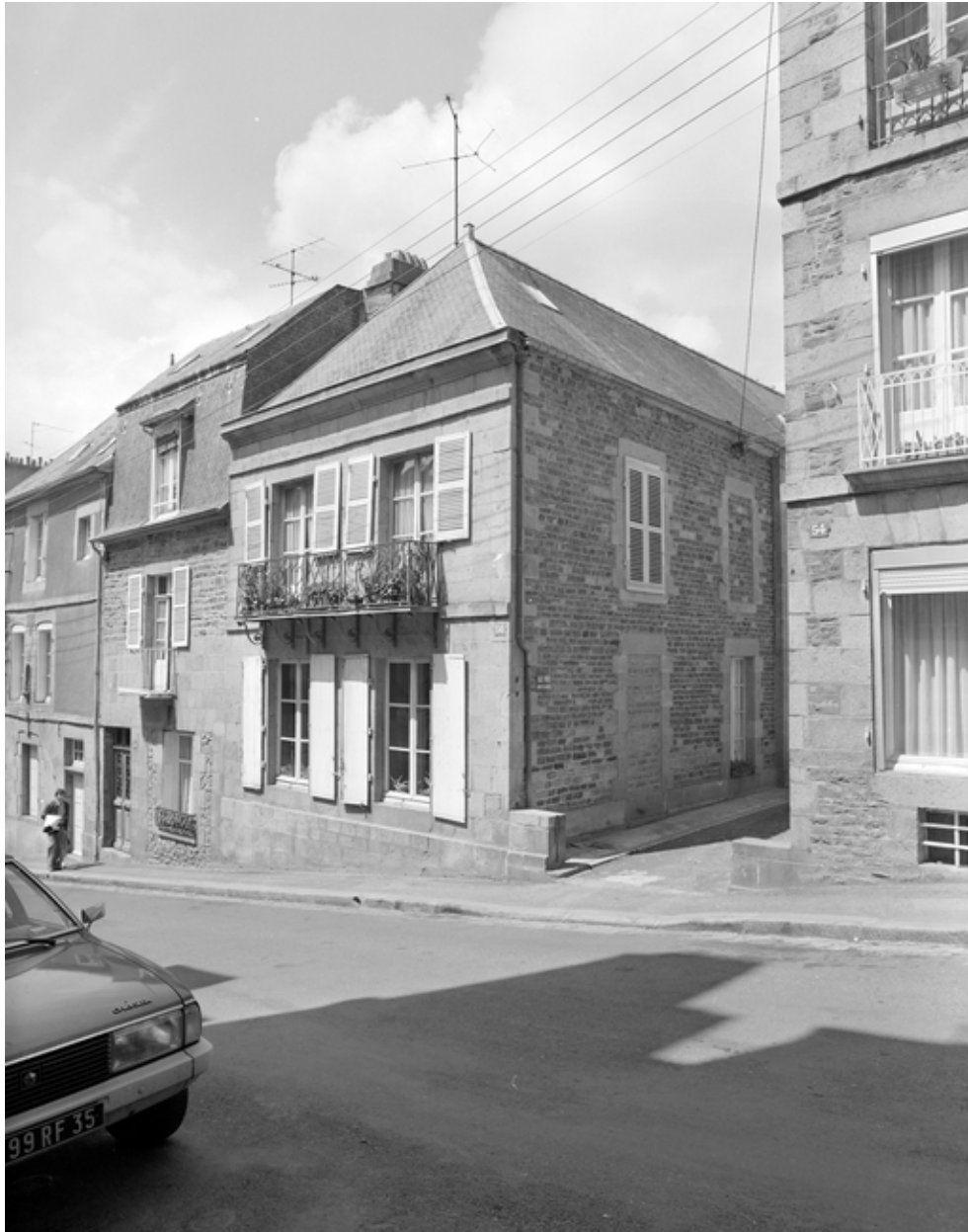
Vue générale de la façade sud.
