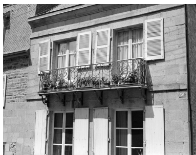
Vue de détail du balcon de la façade sud. Phot. Guy Artur IVR53_19783500293X
