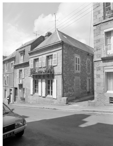
Vue générale de la façade sud. Phot. Guy Artur IVR53_19783500292X
