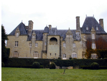
Vue générale de la façade postérieure Phot. Martine Nicolas IVR53_20042905612NUCA
