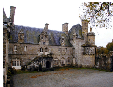
Vue générale de la façade principale Phot. Martine Nicolas IVR53_20042905611NUCA
