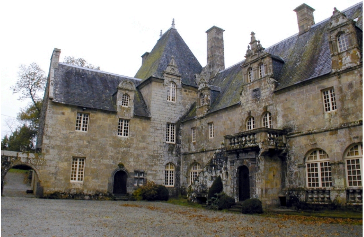
Vue sur le corps principal et l'aile en retour
