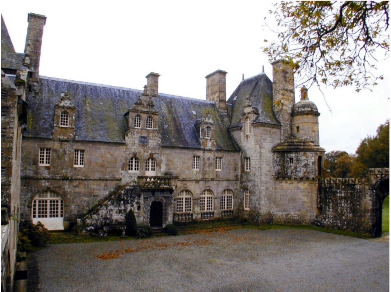
Vue générale de la façade principale
