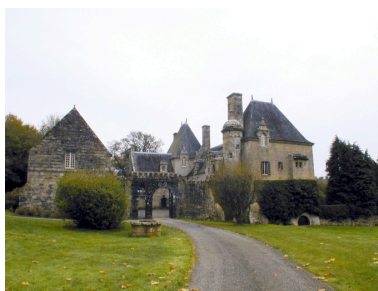
Vue générale depuis l'arrivée Phot. Martine Nicolas IVR53_20042905613NUCA
