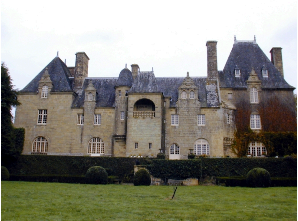
Vue générale de la façade postérieure
