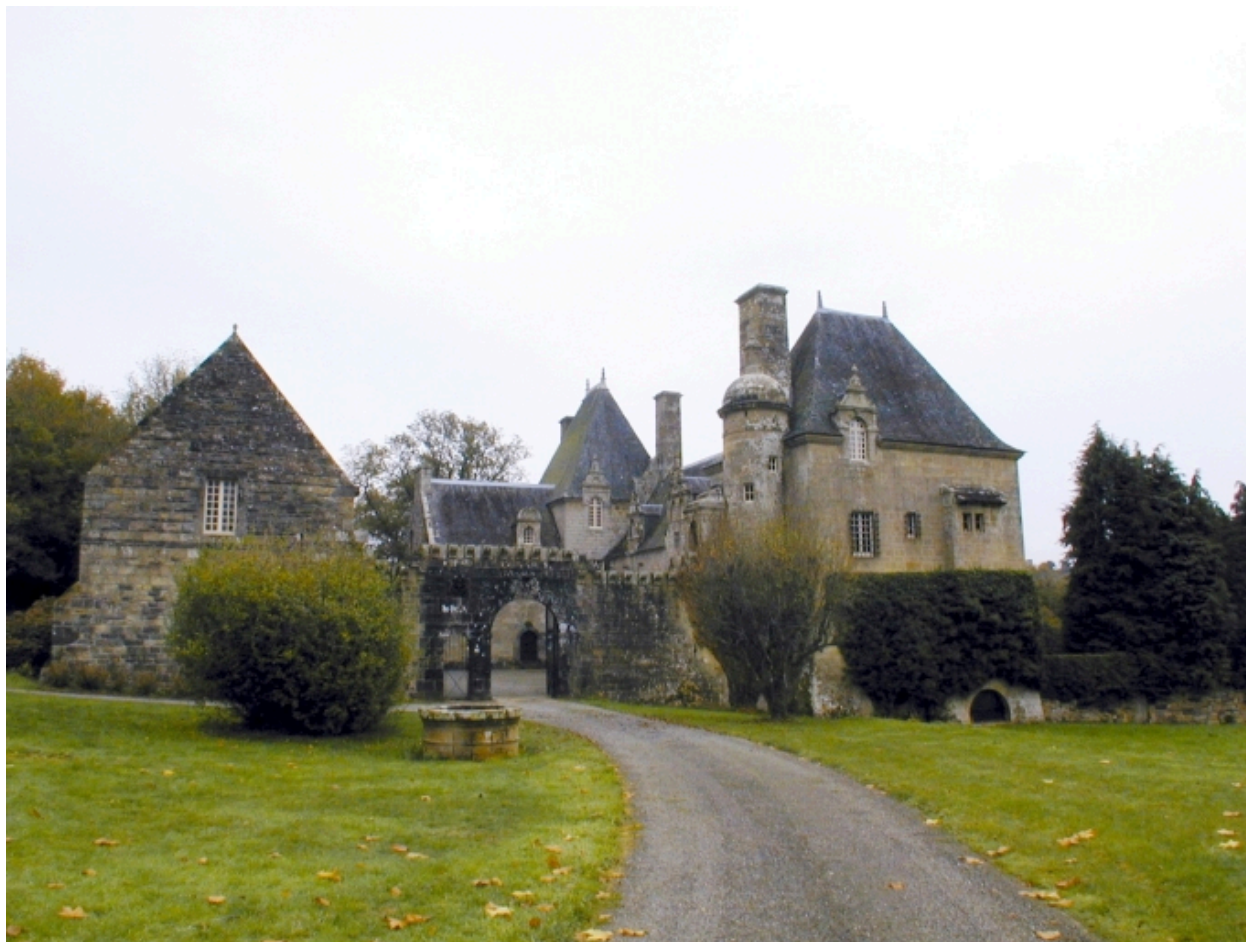
Vue générale depuis l'arrivée
