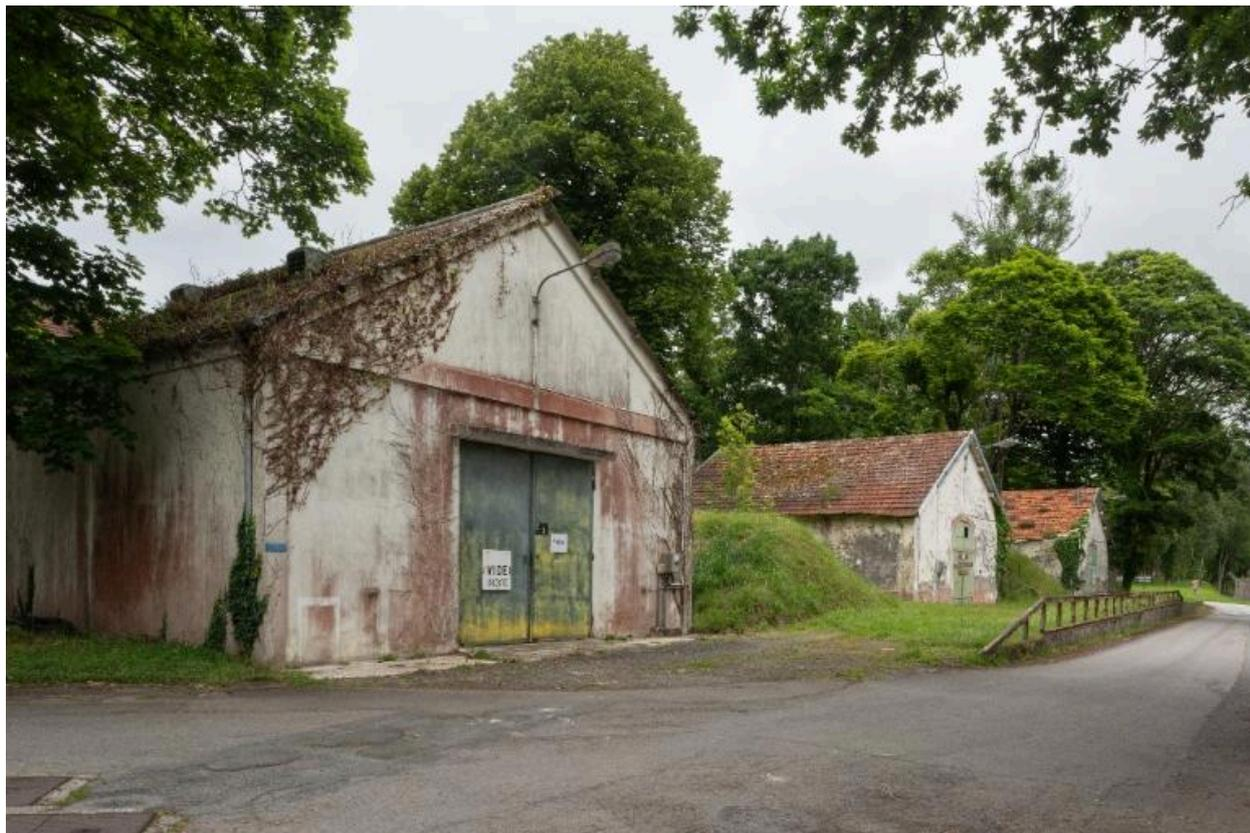
Vue des bâtiments E3, E4 et E5 depuis le sud-sud-est (état en 2025). Ils sont séparés par des merlons de terre. Le bâtiment E3 est couvert en fibrociment ; plus anciens, les bâtiments E4 et E5 sont couverts en tuile plate sur charpente métallique
