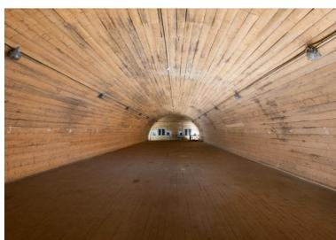
Vue intérieure de la poudrière n° 3 (P3) de la vallée de Kerhuon : premier étage vers le nord (état en 2025). La voûte est entièrement lambrissée. En arrière-plan : fenêtres et créneau à lampe ; à droite, l'escalier
