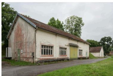
Vue du bâtiment E19 depuis le sud-est : élévation est et pignon sud (état en 2025). Construit en poteau bois avec remplissage en brique, le bâtiment est couvert en tuile plate sur charpente en bois ; ses ouvertures ont été ultérieurement élargies
