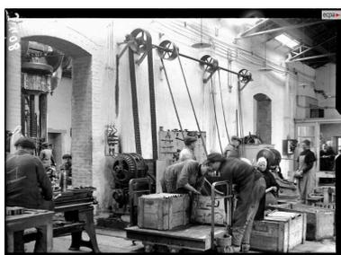
Vue intérieure d'un atelier en 1916 : mise en caisse des douilles. Cet atelier est traversé par une voie ferrée étroite, il est doté de plusieurs machines alimentées par un moteur électrique via des poulies et courroies. A gauche, la presse Sajyn-Paris de 1892
