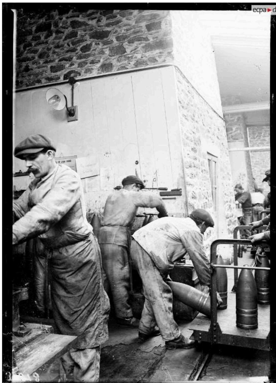
Vue intérieure d'un atelier en 1916 : amorçage des obus (vissage de la gaine relais avec une clé). L'équipe est masculine. L'atelier est traversé par une voie ferrée étroite sur laquelle circulent les chariots transportant les obus
