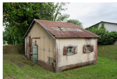
Vue du bâtiment E22 depuis le nord-ouest (état en 2025). Le bâtiment est couvert en tuile plate sur charpente métallique ; il a conservé ses huisseries d'origine et ses volets métalliques. Il est entouré par des merlons de terre
