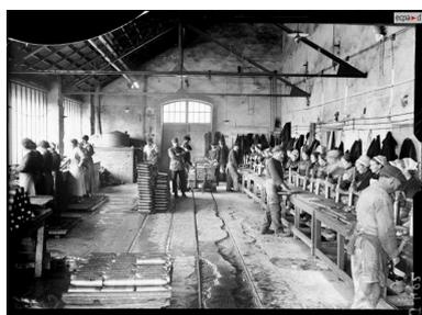
Vue intérieure d'un atelier en 1916 : à gauche, lavage des obus de 75 mm ; à droite, nettoyage intérieur des obus. L'équipe est mixte. Cet atelier à charpente métallique avec fenêtre de type verrière est traversé par une deux voies ferrées étroites
