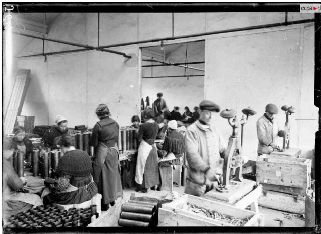
Vue intérieure d'un atelier en 1916 : amorçage, marquage et chargement des douilles de 75 mm. L'équipe est mixte. L'atelier est divisé par une cloison ; suspendu au plafond, un dispositif d'extinction incendie
