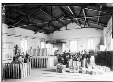
Vue intérieure d'un atelier en 1916 : à gauche, les grosses douilles ; à droite, des caisses de munitions. L'équipe est mixte. Cet atelier à charpente métallique et ouvertures en arc segmentaire est desservi par une voie ferrée étroite
