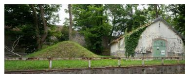
Vue du bâtiment E5 : élévation est (état en 2025). Ce bâtiment est couvert en tuile plate sur charpente métallique. A gauche, merlon de terre
