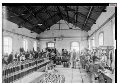
Vue intérieure d'un atelier en 1916 : à gauche, peinture des obus ; à droite, autre chaîne avec presses. Cet atelier à charpente métallique et ouvertures en arc segmentaire est traversé par deux voies ferrées étroites, il est doté d'un pont roulant manuel
