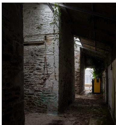
Vue intérieure de l'atelier B23 : espace ouest couvert en appentis vers le sud (état en 2025). Au sol, subsiste une voie ferrée étroite. A gauche, l'alvéole n° 2. L'alvéole était dotée d'un entresol reposant sur des poutrelles
