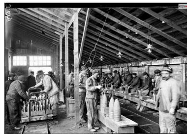
Vue intérieure d'un atelier en 1916. A gauche, arrivée des obus sur chariot ; à droite : chaîne de tassage de la mélinite ; au centre, remplissage d'obus. L'équipe est masculine. L'atelier en bois est traversé par deux voies ferrées étroites
