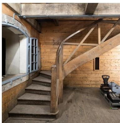
Vue intérieure de la poudrière n° 3 (P3) de la vallée de Kerhuon : rez-de-chaussée, extrémité sud, escalier tournant en bois, fenêtre et créneau à lampe (état en 2025)
