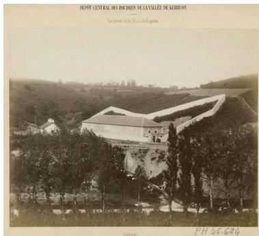
Vue générale du magasin à poudre n° 1 (P1) de la vallée de Kerhuon en 1885. Il est protégé par une enceinte de sûreté ; au niveau du portail, se trouve une guérite en bois . La voie ferrée passe via un pont au-dessus de la route départementale
