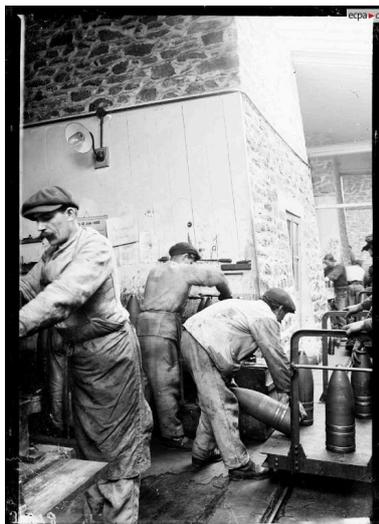
Vue intérieure d'un atelier en 1916 : amorçage des obus (vissage de la gaine relais avec une clé). L'équipe est masculine. L'atelier est traversé par une voie ferrée étroite sur laquelle circulent les chariots transportant les obus
