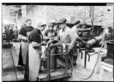
Vue intérieure d'un atelier en 1916 : nettoyage des obus de 220 mm. L'équipe est mixte. L'atelier est doté d'un chemin de roulement pour les chariots et de palans manuels suspendus aux poutres du plafond
