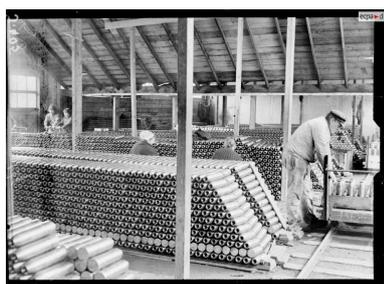
Vue intérieure d'un atelier en 1916 : stock d'obus après le vernissage. Cet atelier en bois est traversé par une voie ferrée étroite sur laquelle circulent les chariots
