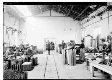
Vue intérieure d'un atelier en 1916 : vernissage des douilles et tournage. Cet atelier à charpente métallique et ouvertures en arc segmentaire est traversé par une voie ferrée étroite ; des poulies font fonctionner les machines
