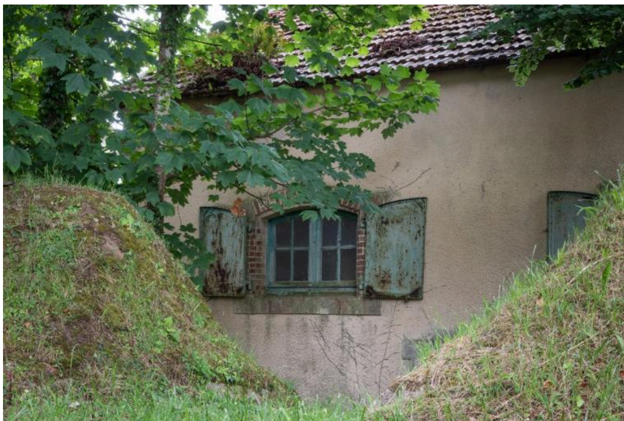
Vue du bâtiment E22 depuis l'est : élévation est, fenêtre en bois avec volets métalliques (état en 2025). Au premier plan, des merlons en terre
