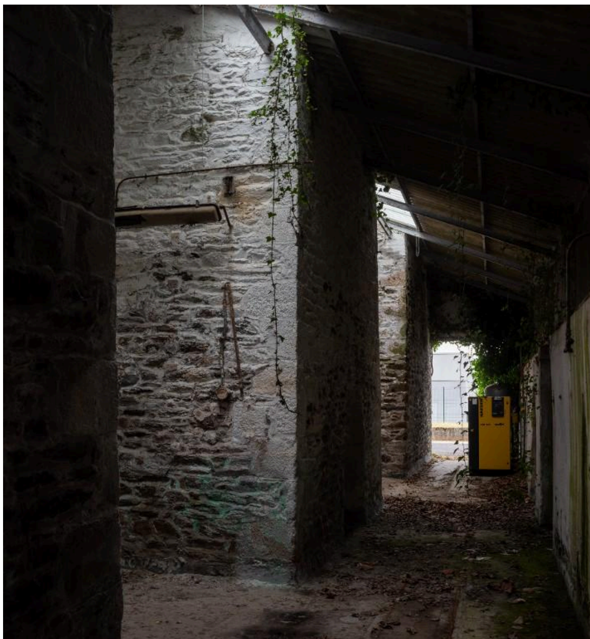
Vue intérieure de l'atelier B23 : espace ouest couvert en appentis vers le sud (état en 2025). Au sol, subsiste une voie ferrée étroite. A gauche, l'alvéole n° 2. L'alvéole était dotée d'un entresol reposant sur des poutrelles
