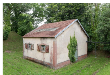
Vue du bâtiment E22 depuis le sud-ouest (état en 2025). Le bâtiment est couvert en tuile plate sur charpente métallique ; il a conservé ses huisseries d'origine et ses volets métalliques. Il est entouré par des merlons de terre Phot. Léna Leroy IVR53_20252901166NUCA
