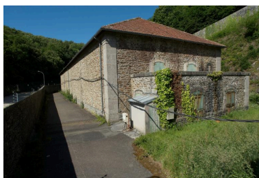
Vue générale de la poudrière n° 1 (P1) de la vallée de Kerhuon depuis le nord-est (état en 2009). Le magasin est couvert en tuile plate ; les chaînages d'angle sont en pierre de taille de granite gris Phot. Bernard Bègne IVR53_20122901461NUCA
