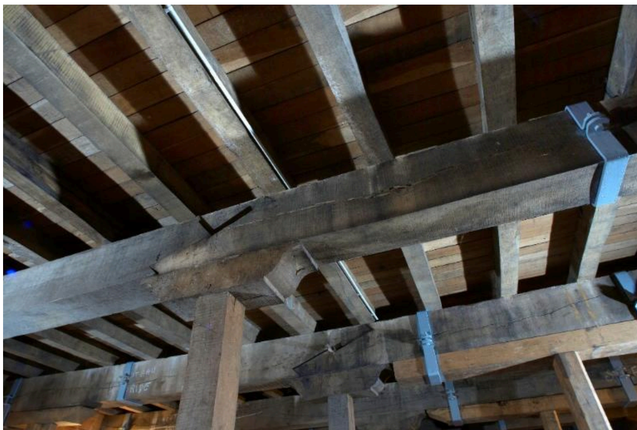
Vue intérieure de la poudrière n° 2 (P2) de la vallée de Kerhuon : extrémité est, poteaux et poutres soutenant les voliges du plancher du premier étage (état en 2009). Des poteaux ont été ajoutés ; certaines poutres ont été cerclées
