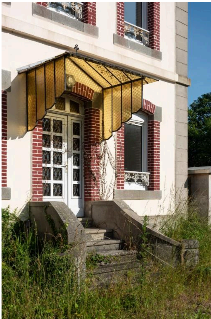
Vue de détail du logement J15 : élévation sud-est, entrée précédée d'un perron couvert d'une marquise (état en 2025)
