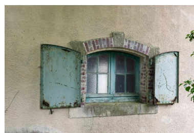
Vue de détail du bâtiment E22 depuis l'est : élévation est, fenêtre en bois avec volets métalliques (état en 2025) Phot. Léna Leroy IVR53_20252901156NUCA
