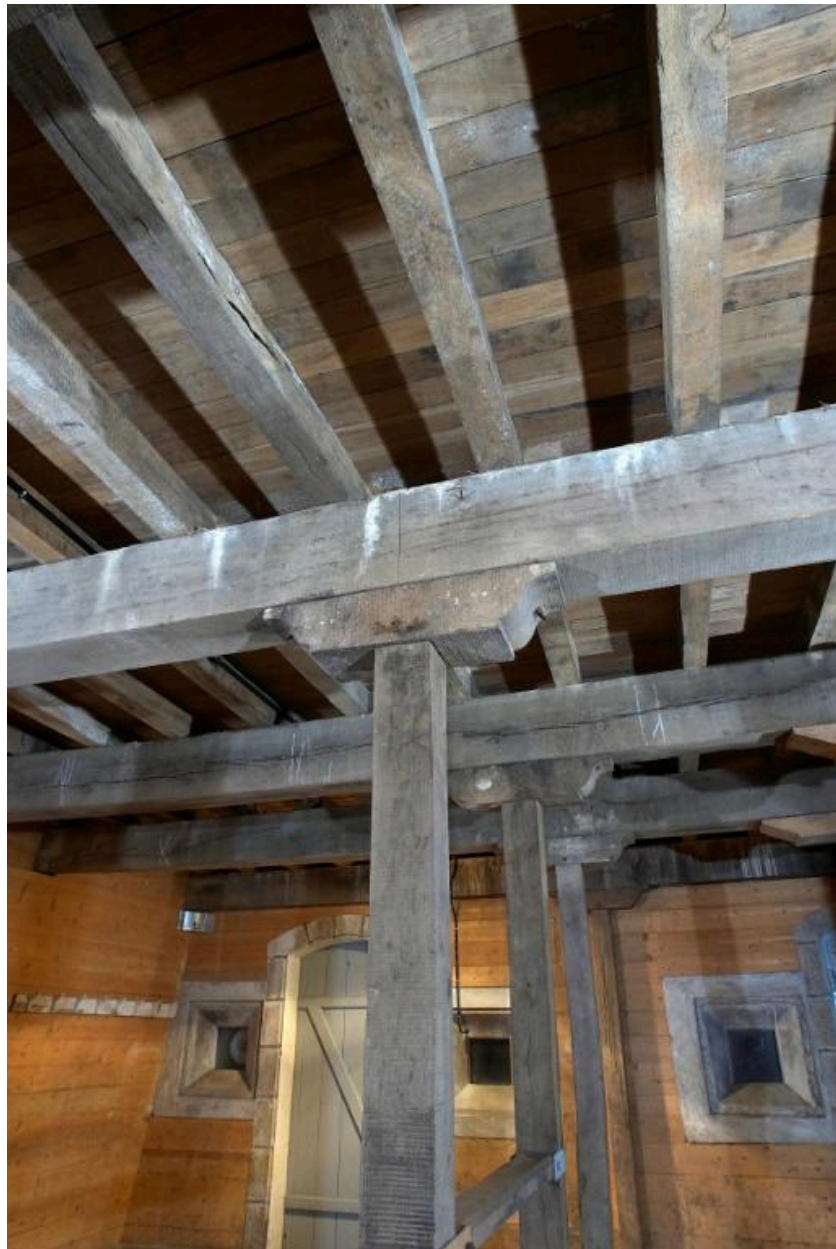
Vue intérieure de la poudrière n° 2 (P2) de la vallée de Kerhuon : extrémité est, poteaux et poutres soutenant les voliges du plancher du premier étage (état en 2009). En arrière-plan, la porte donnant sur le sas d'entrée est et les créneaux à lampe
