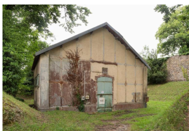
Vue du bâtiment E22 depuis le nord : élévation nord (état en 2025). Le bâtiment est construit en plaques de ciment armé et poutrelles assemblées par des plaques rivetées. Il est entouré par des merlons de terre Phot. Léna Leroy IVR53_20252901153NUCA
