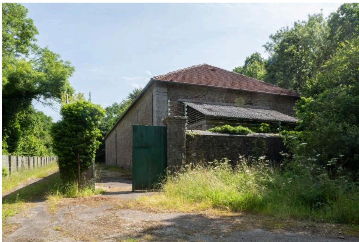
Vue générale de la poudrière n° 3 (P3) de la vallée de Kerhuon depuis le sud-ouest (état en 2025). Le magasin est entouré d'une enceinte de sûreté en maçonnerie percée d'un portail ; il est couvert en tuile plate
