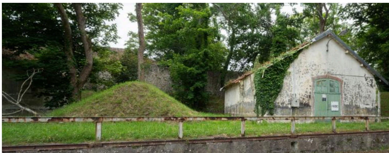
Vue du bâtiment E5 : élévation est (état en 2025). Ce bâtiment est couvert en tuile plate sur charpente métallique. A gauche, merlon de terre
