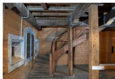
Vue intérieure de la poudrière n° 2 (P2) de la vallée de Kerhuon : rez- de-chaussée, escalier tournant en bois, fenêtre et créneaux à lampe (état en 2009). Les huisseries sont d'origine. Un poteau a été ajouté ; certaines poutres ont été cerclées Phot. Bernard Bègne IVR53_20122901446NUCA
