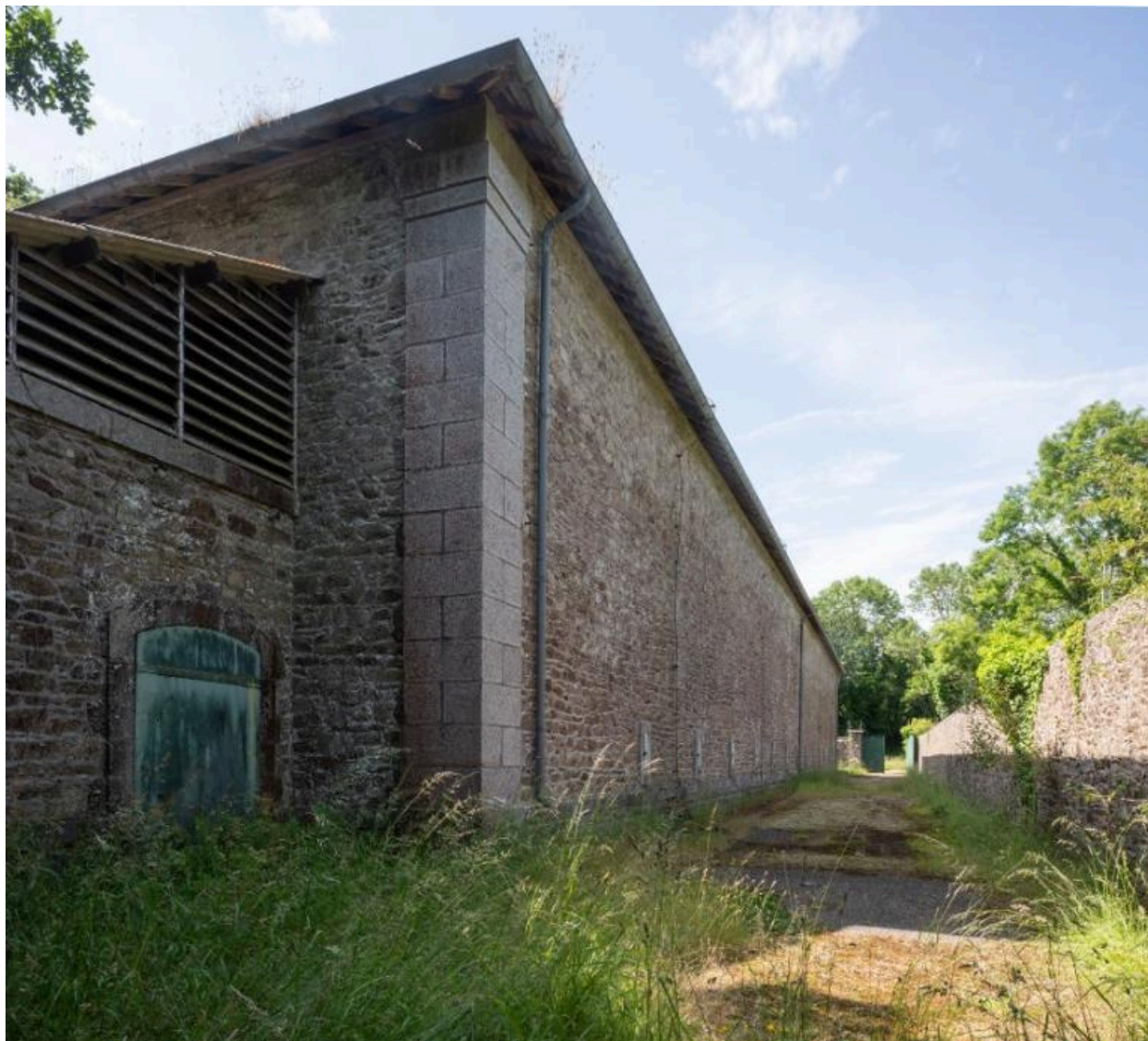
Vue de la poudrière n° 3 (P3) de la vallée de Kerhuon depuis le nord-est : élévation ouest (état en 2025). Le magasin est entouré d'une enceinte de sûreté en maçonnerie. Les chaînes d'angle sont en pierre de taille de granite gris
