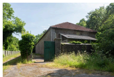
Vue générale de la poudrière n° 3 (P3) de la vallée de Kerhuon depuis le sud-ouest (état en 2025). Le magasin est entouré d'une enceinte de sûreté en maçonnerie percée d'un portail ; il est couvert en tuile plate Phot. Léna Leroy IVR53_20252901225NUCA
