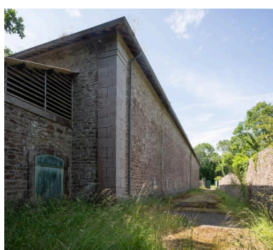
Vue de la poudrière n° 3 (P3) de la vallée de Kerhuon depuis le nord-est : élévation ouest (état en 2025). Le magasin est entouré d'une enceinte de sûreté en maçonnerie. Les chaînes d'angle sont en pierre de taille de granite gris Phot. Léna Leroy IVR53_20252901224NUCA
