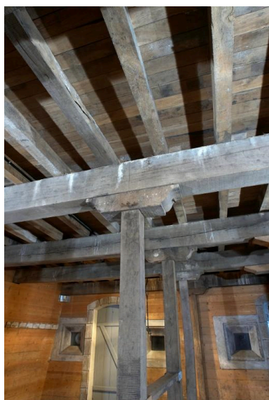
Vue intérieure de la poudrière n° 2 (P2) de la vallée de Kerhuon : extrémité est, poteaux et poutres soutenant les voliges du plancher du premier étage (état en 2009). En arrière-plan, la porte donnant sur le sas d'entrée est et les créneaux à lampe Phot. Bernard Bègne IVR53_20122901454NUCA
