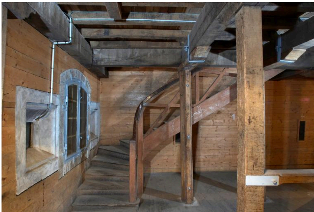
Vue intérieure de la poudrière n° 2 (P2) de la vallée de Kerhuon : rez-de-chaussée, escalier tournant en bois, fenêtre et créneaux à lampe (état en 2009). Les huisseries sont d'origine. Un poteau a été ajouté ; certaines poutres ont été cerclées
