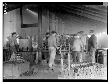
Vue intérieure d'un atelier en 1916 : chaîne d'obus de 75 mm. L'équipe est masculine. Cet atelier en bois est traversé par une voie ferrée étroite sur laquelle circulent les chariots (au premier plan à droite)
