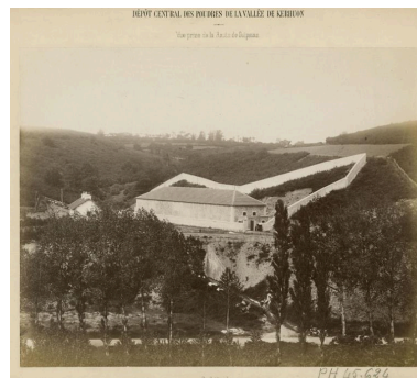
Vue générale du magasin à poudre n° 1 (P1) de la vallée de Kerhuon en 1885. Il est protégé par une enceinte de sûreté ; au niveau du portail, se trouve une guérite en bois. La voie ferrée passe via un pont au-dessus de la route départementale Phot. Auteur inconnu (phototype/graphique), Phot. Arnaud Fux IVR53_20252910330NUCA
