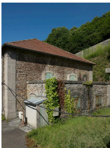
Vue de détail de la poudrière n° 1 (P1) de la vallée de Kerhuon : pignon nord-est avec son sas d'entrée (état en 2009). Le magasin est couvert en tuile plate ; les chaînages d'angle sont en pierre de taille de granite gris
