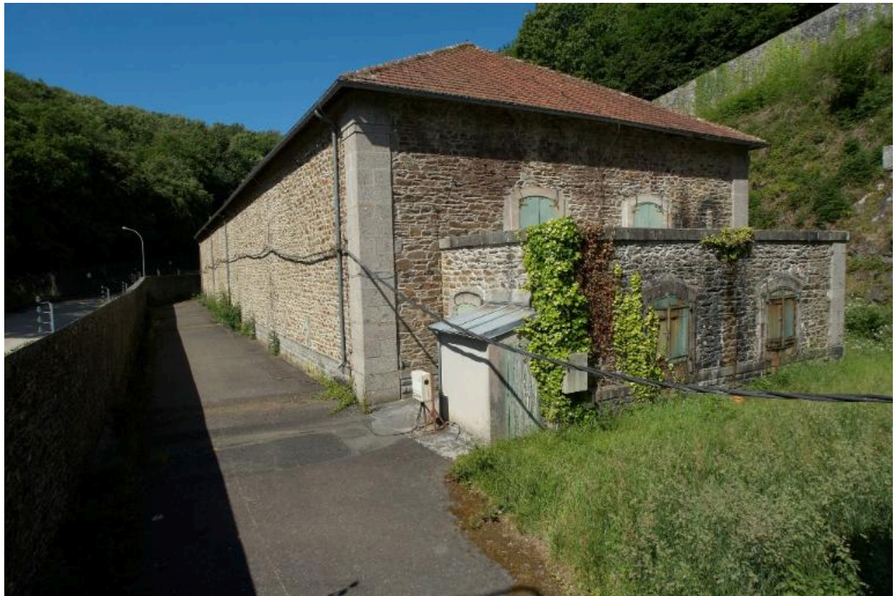
Vue générale de la poudrière n° 1 (P1) de la vallée de Kerhuon depuis le nord-est (état en 2009). Le magasin est couvert en tuile plate ; les chaînages d'angle sont en pierre de taille de granite gris
