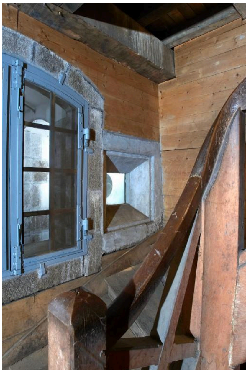
Vue intérieure de la poudrière n° 2 (P2) de la vallée de Kerhuon : rez-de-chaussée, extrémité est, escalier tournant en bois, fenêtre et créneau à lampe (état en 2009). Les huisseries sont d'origine
