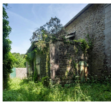
Vue de détail de la poudrière n° 3 (P3) de la vallée de Kerhuon : sas d'entrée sud (état en 2025). Le sas a ultérieurement été couvert en appentis Phot. Léna Leroy IVR53_20252901222NUCA
