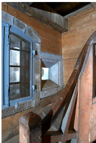
Vue intérieure de la poudrière n° 2 (P2) de la vallée de Kerhuon : rez-de-chaussée, extrémité est, escalier tournant en bois, fenêtre et créneau à lampe (état en 2009). Les huisseries sont d'origine Phot. Bernard Bègne IVR53_20122901452NUCA
