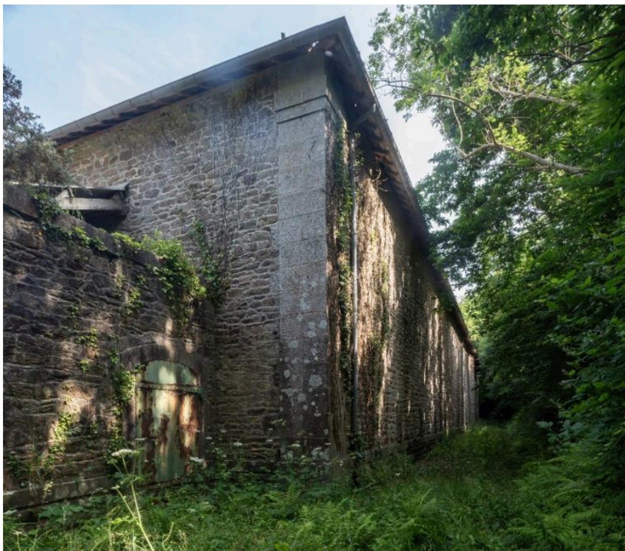
Vue de la poudrière n° 3 (P3) de la vallée de Kerhuon : élévation est (état en 2025). Les chaînes d'angle sont en pierre de taille de granite gris
