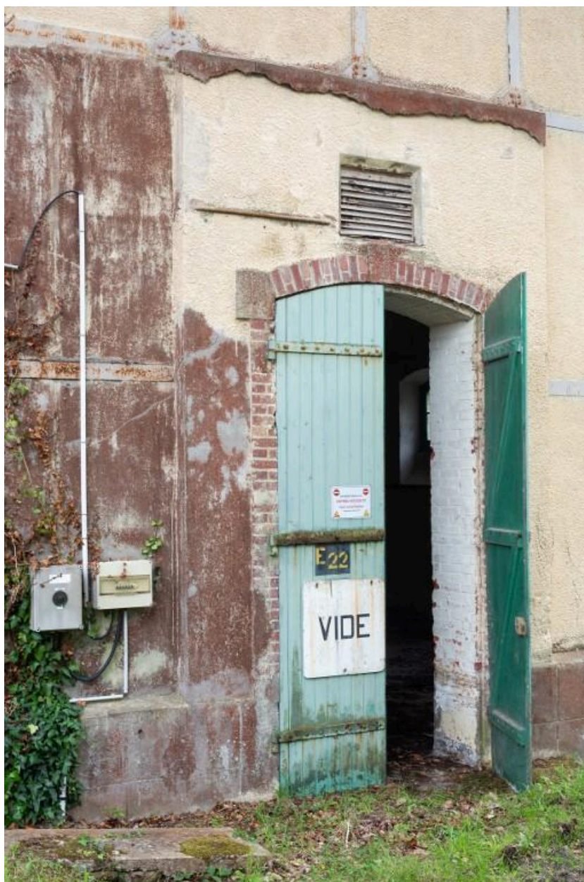
Vue de détail du bâtiment E22 : élévation nord, porte à double battant en bois (état en 2025). Le bâtiment est construit en plaques de ciment armé et poutrelles assemblées par des plaques rivetées
