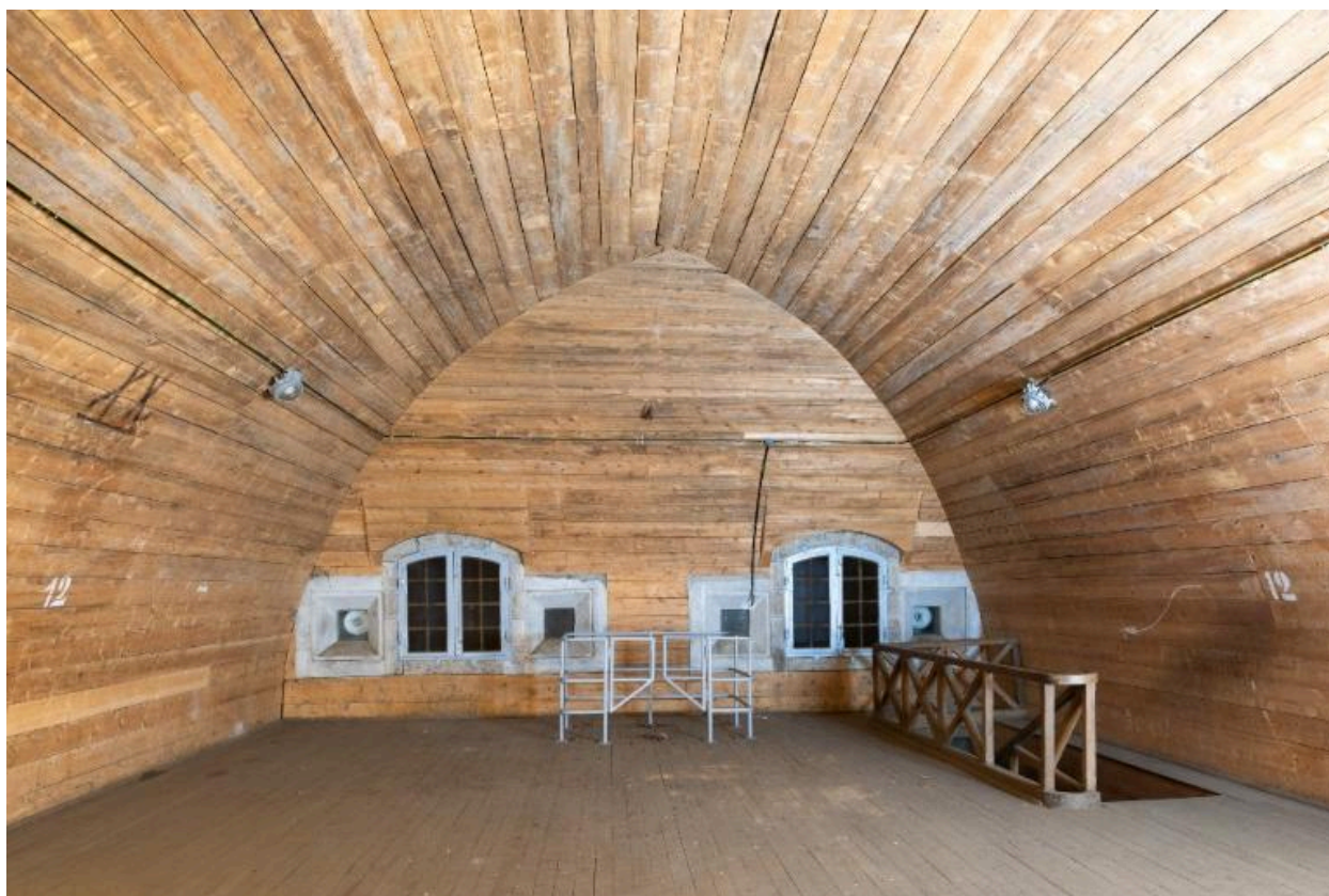
Vue intérieure de la poudrière n° 3 (P3) de la vallée de Kerhuon : premier étage, extrémité nord, emplacement du palan permettant les manutentions par une trappe aménagée dans le plancher (état en 2025). En arrière-plan : fenêtres et créneaux à lampe
