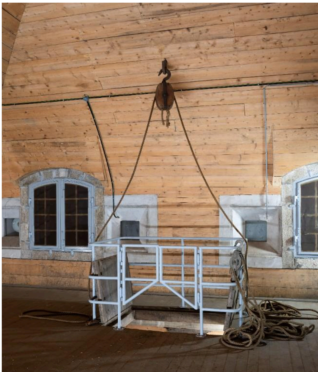
Vue intérieure de la poudrière n° 3 (P3) de la vallée de Kerhuon : premier étage, extrémité sud, palan permettant les manutentions par une trappe aménagée dans le plancher (état en 2025). En arrière-plan : fenêtres et créneaux à lampe
