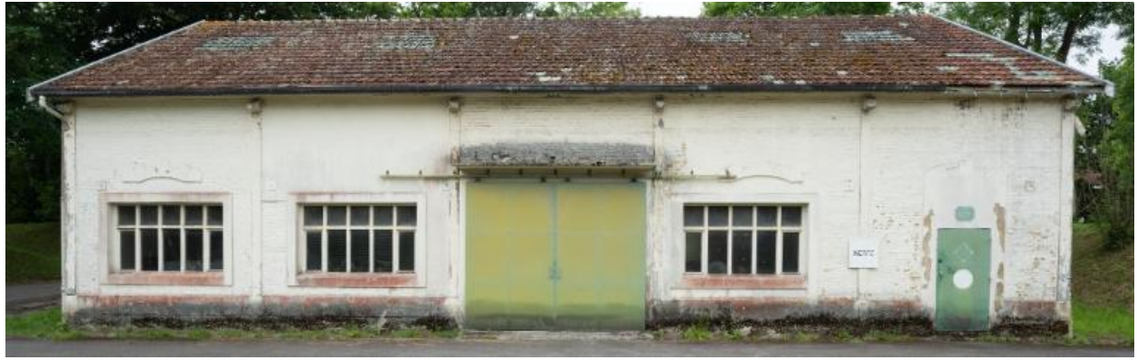
Vue du bâtiment E19 depuis l'est : élévation est (état en 2025). Construit en poteau bois avec remplissage en brique, le bâtiment est couvert en tuile plate sur charpente en bois ; ses ouvertures ont été ultérieurement élargies
