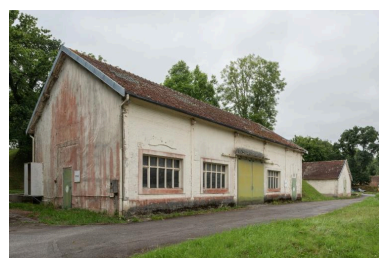
Vue du bâtiment E19 depuis le sud-est : élévation est et pignon sud (état en 2025). Construit en poteau bois avec remplissage en brique, le bâtiment est couvert en tuile plate sur charpente en bois ; ses ouvertures ont été ultérieurement élargies Phot. Léna Leroy IVR53_20252901169NUCA
