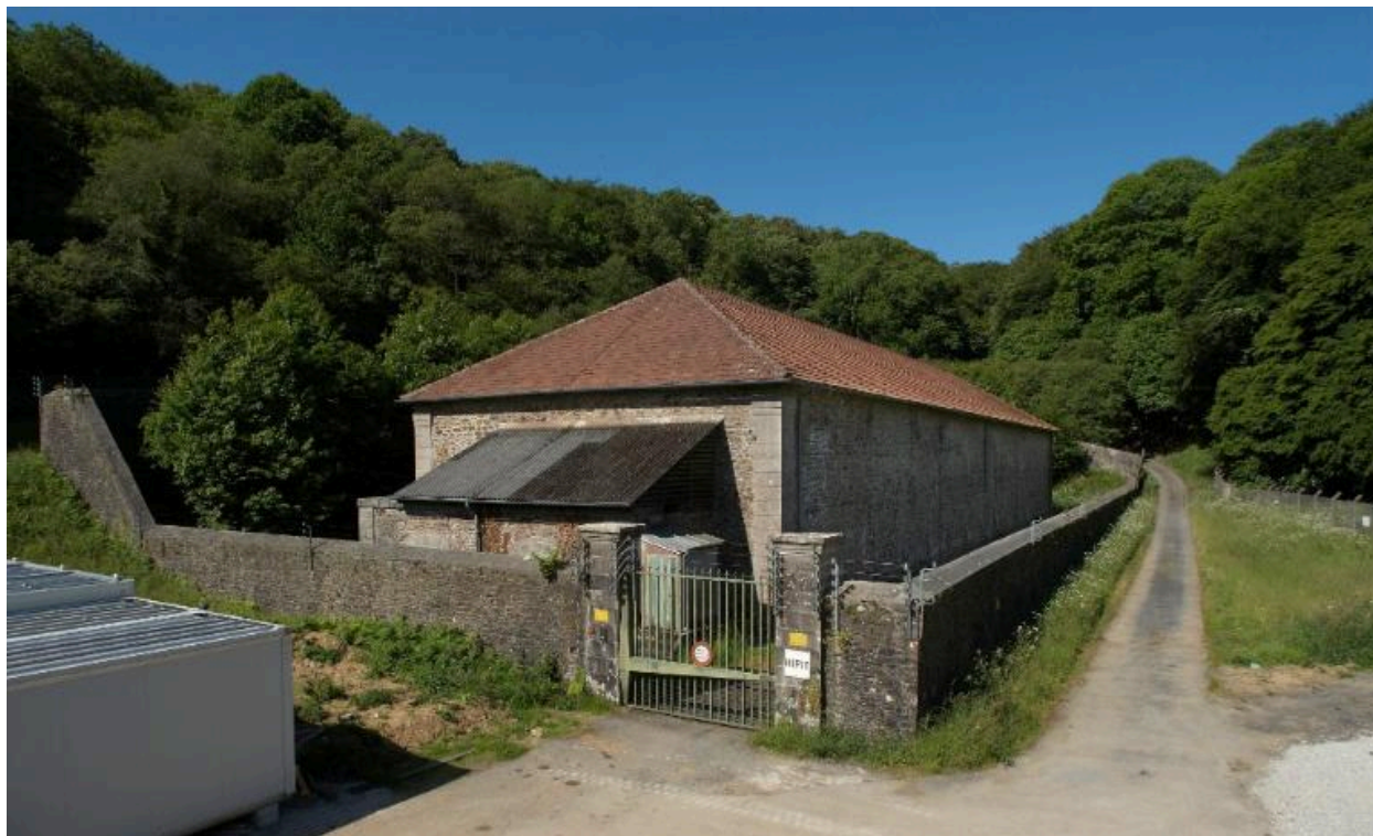
Vue générale de la poudrière n° 2 (P2) de la vallée de Kerhuon depuis le nord-est (état en 2009). Elle a conservé son enceinte de sûreté avec portail ; sa couverture en tuile plate et ses supports de paratonnerre
