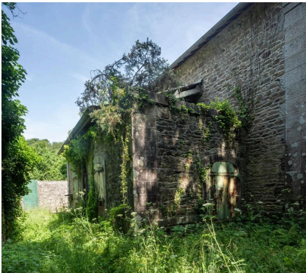
Vue de détail de la poudrière n° 3 (P3) de la vallée de Kerhuon : sas d'entrée sud (état en 2025). Le sas a ultérieurement été couvert en appentis
