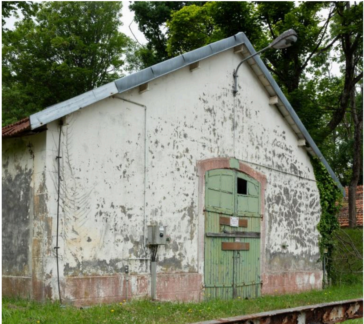
Vue du bâtiment E4 depuis l'est : élévation est, porte à double battant en bois (état en 2025). Le bâtiment est couvert en tuile plate sur charpente métallique
