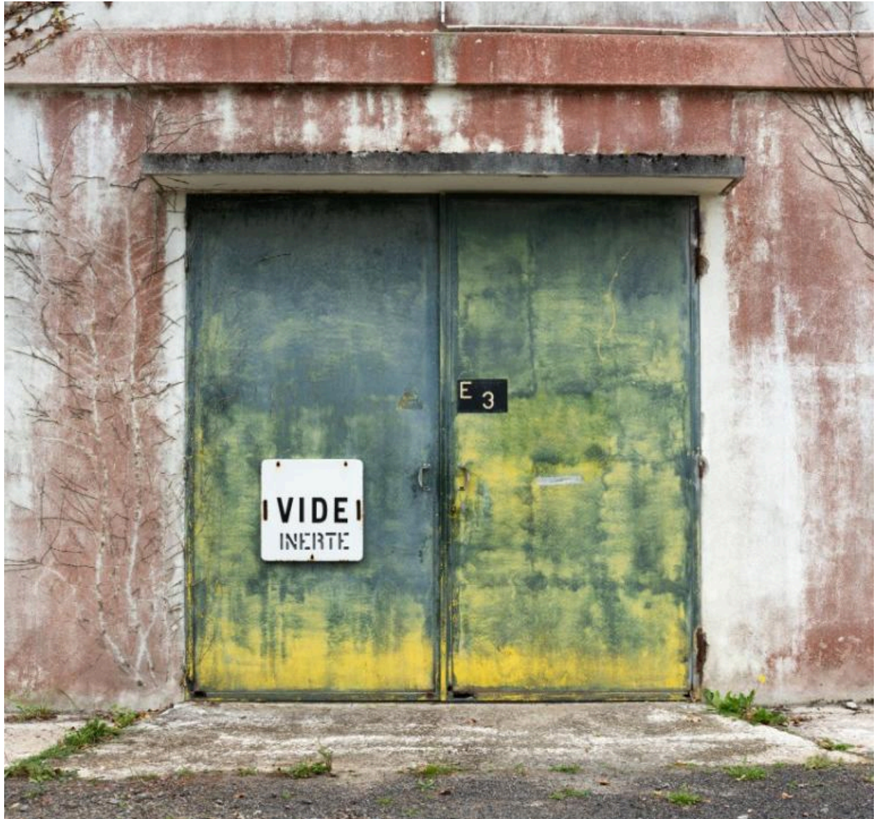
Vue de détail du bâtiment E3 : élévation est, porte à double battant métallique (état en 2025). Le bâtiment E3 est couvert en tôle ondulée en fibrociment
