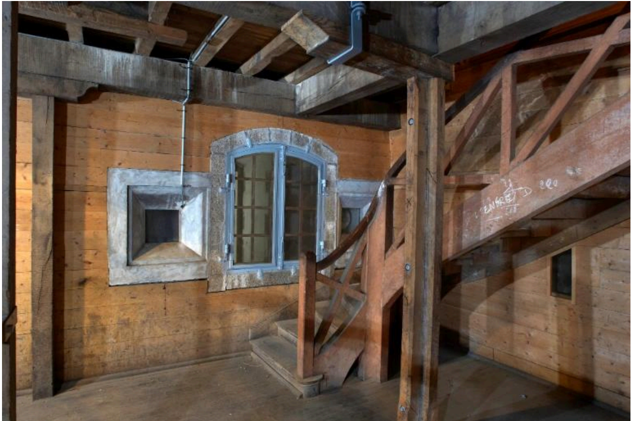
Vue intérieure de la poudrière n° 2 (P2) de la vallée de Kerhuon : rez-de-chaussée, extrémité est, escalier tournant en bois, fenêtre et créneaux à lampe (état en 2009). Les huisseries sont d'origine. Un poteau a été ajouté ; une poutre a été cerclée
