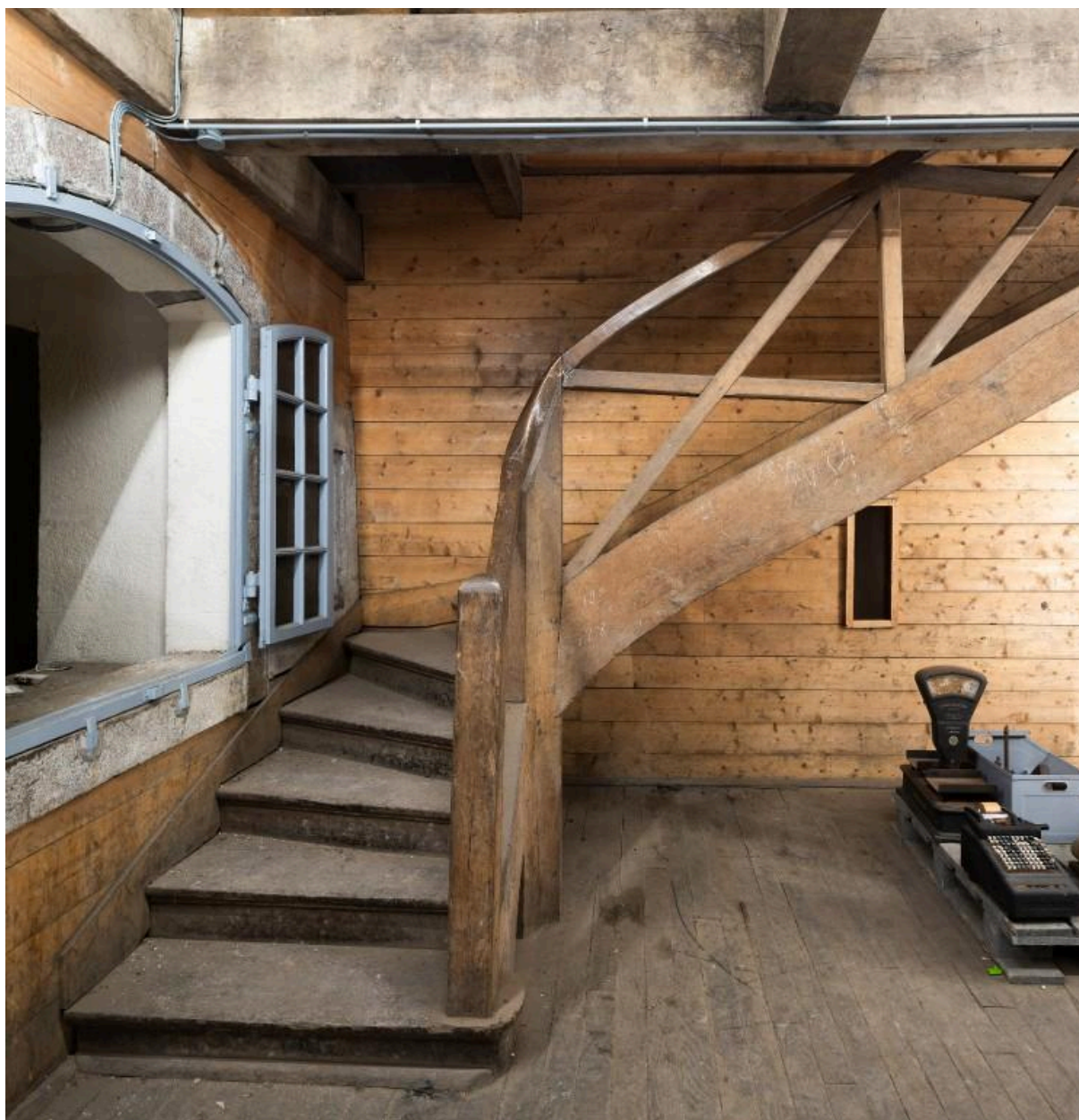
Vue intérieure de la poudrière n° 3 (P3) de la vallée de Kerhuon : rez-de-chaussée, extrémité sud, escalier tournant en bois, fenêtre et créneau à lampe (état en 2025)
