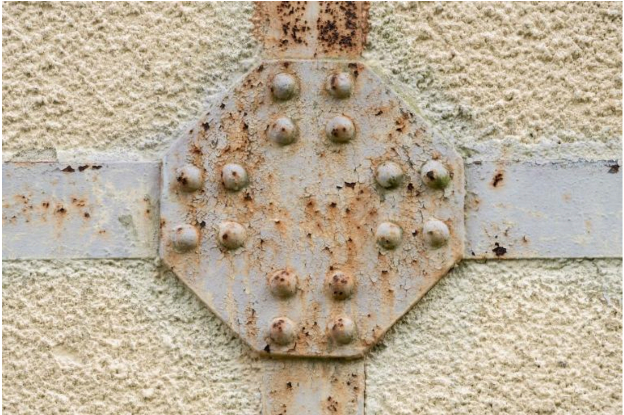
Vue de détail du bâtiment E22 : élévation nord, plaques de ciment armé et poutrelles assemblées par des plaques rivetées (état en 2025)
