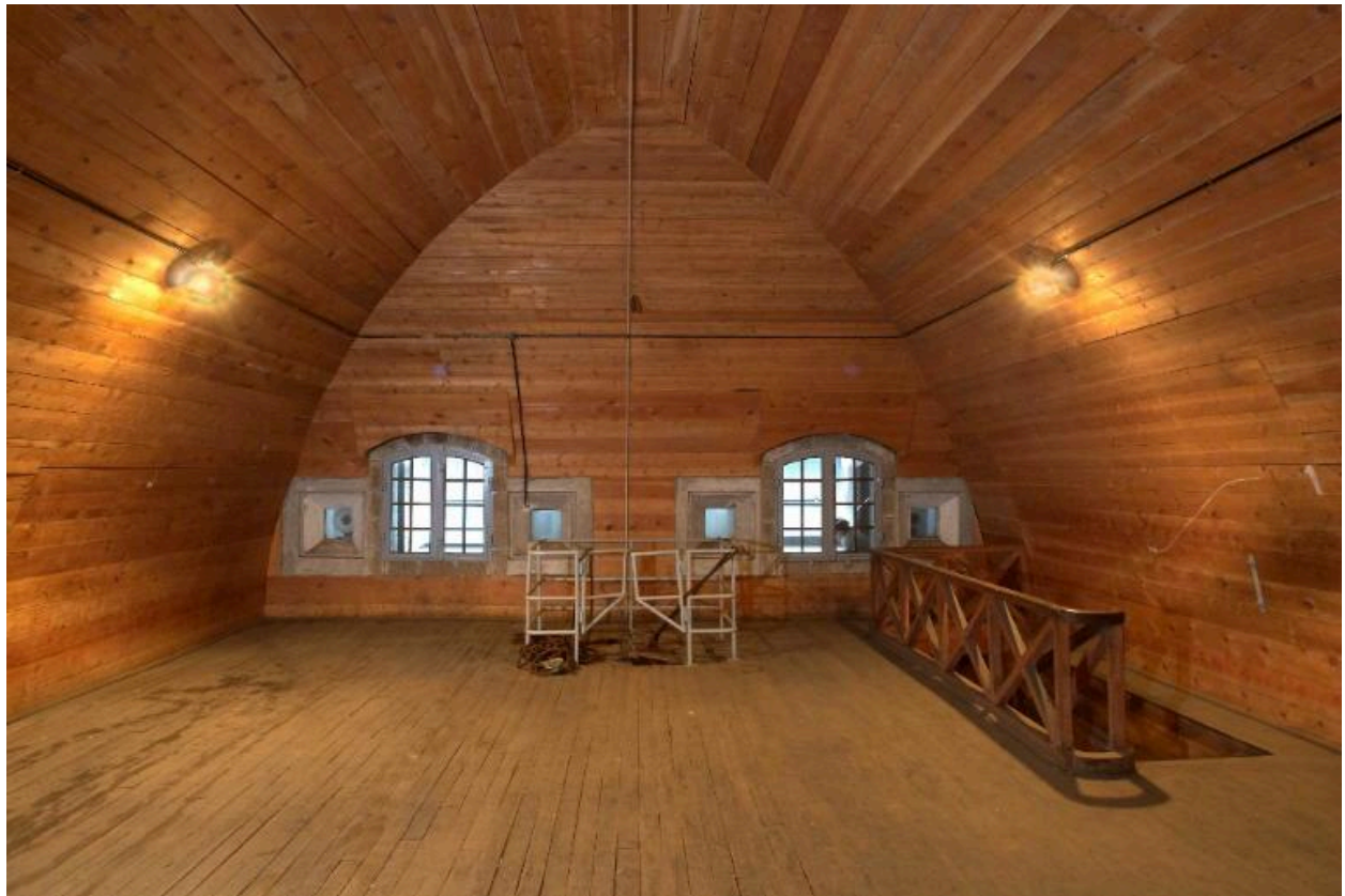
Vue intérieure de la poudrière n° 2 (P2) de la vallée de Kerhuon : premier étage voûté en pierre sous voûte lambrissée, extrémité est (état en 2009). Cet espace était éclairé par des fenêtres et créneaux à lampe. A droite, l'escalier
