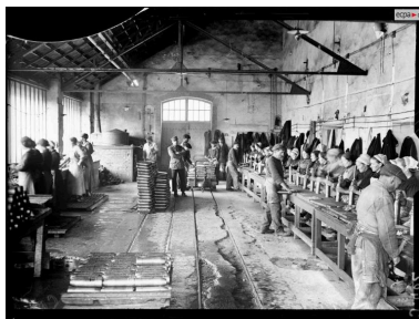
Vue intérieure d'un atelier en 1916 : à gauche, lavage des obus de 75 mm ; à droite, nettoyage intérieur des obus. L'équipe est mixte. Cet atelier à charpente métallique avec fenêtre de type verrière est traversé par une deux voies ferrées étroites
