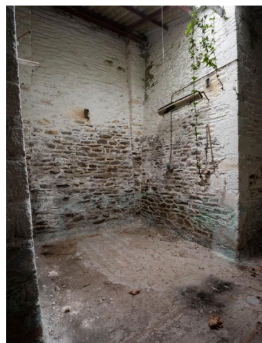
Vue intérieure de l'atelier B23 : espace ouest couvert en appentis vers le sud, alvéole n° 2 (état en 2025). L'alvéole était dotée d'un entresol reposant sur des poutrelles. Au sol, subsiste une voie ferrée étroite
