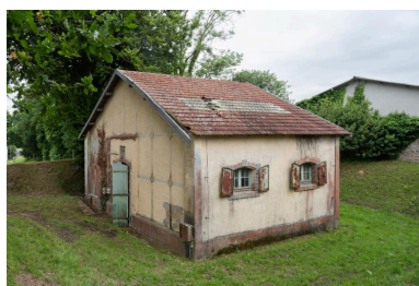
Vue du bâtiment E22 depuis le nord-ouest (état en 2025). Le bâtiment est couvert en tuile plate sur charpente métallique ; il a conservé ses huisseries d'origine et ses volets métalliques. Il est entouré par des merlons de terre Phot. Léna Leroy IVR53_20252901168NUCA
