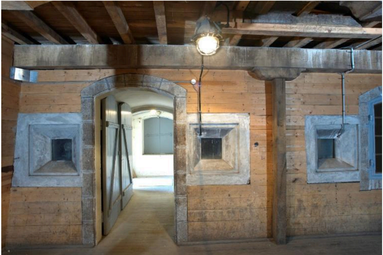
Vue intérieure de la poudrière n° 2 (P2) de la vallée de Kerhuon : rez-de-chaussée, extrémité est, porte donnant sur le sas (état en 2009). De part et d'autre, des créneaux à lampe
