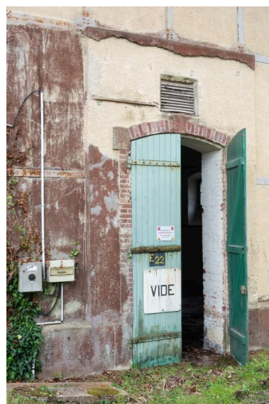
Vue de détail du bâtiment E22 : élévation nord, porte à double battant en bois (état en 2025). Le bâtiment est construit en plaques de ciment armé et poutrelles assemblées par des plaques rivetées Phot. Léna Leroy IVR53_20252901158NUCA
