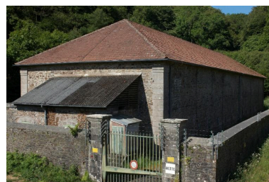
Vue générale de la poudrière n° 2 (P2) de la vallée de Kerhuon depuis le nord-est (état en 2009). Le magasin est couvert en tuile plate ; les chaînages d'angle sont en pierre de taille de granite. Il a conservé ses quatre supports de paratonnerre
