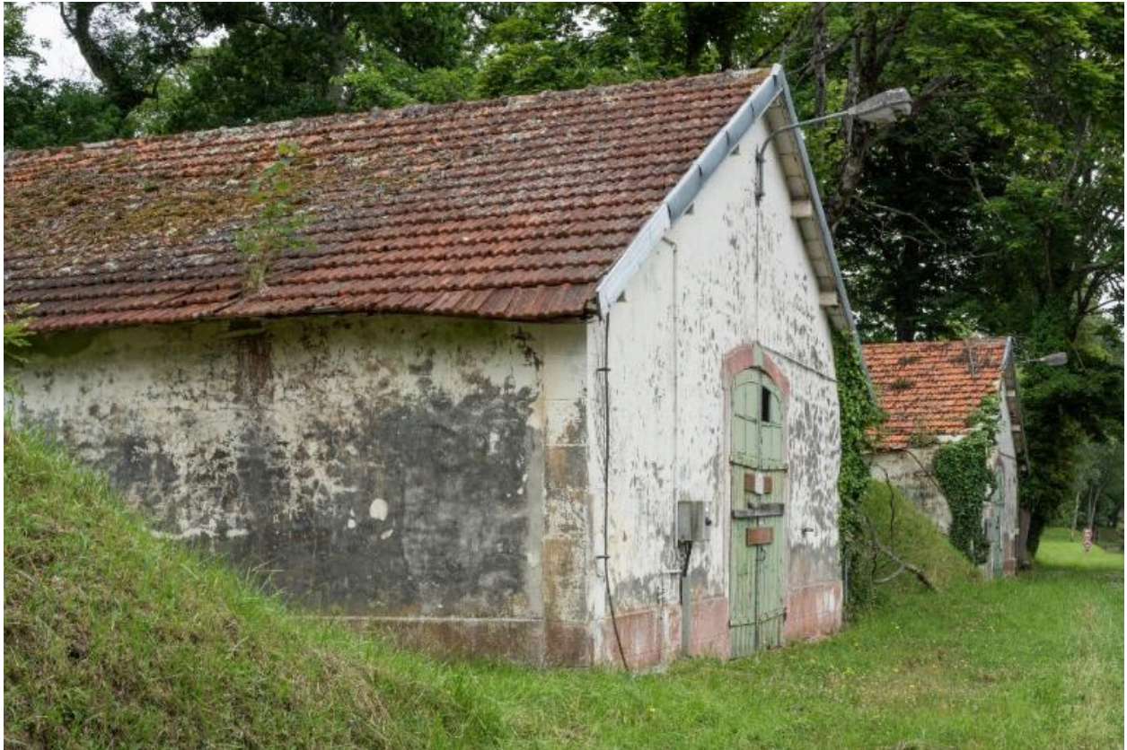
Vue des bâtiments E4 et E5 depuis le sud-sud-est (état en 2025). Ces deux bâtiments sont couverts en tuile plate sur charpente métallique. Ils sont séparés par des merlons de terre
