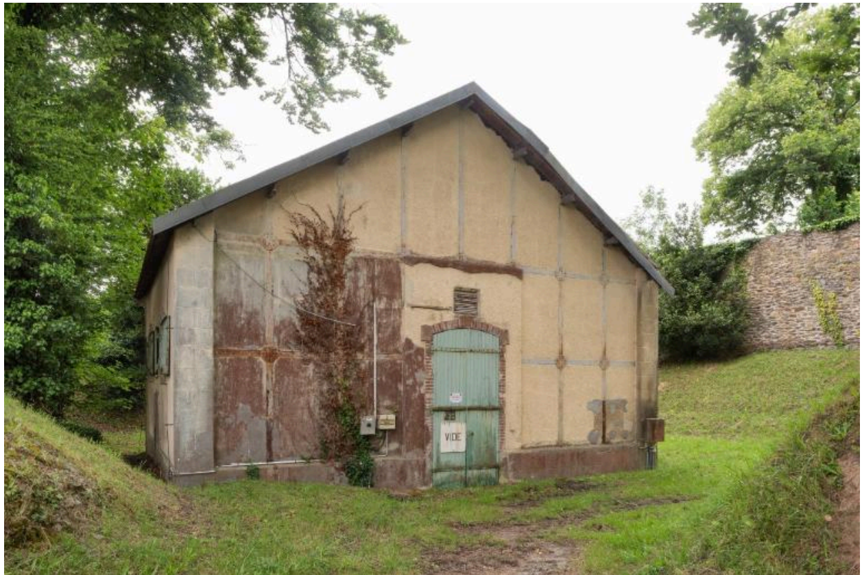
Vue du bâtiment E22 depuis le nord : élévation nord (état en 2025). Le bâtiment est construit en plaques de ciment armé et poutrelles assemblées par des plaques rivetées. Il est entouré par des merlons de terre
