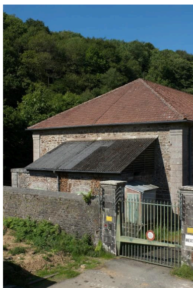
Vue de détail de la poudrière n° 2 (P2) de la vallée de Kerhuon : pignon est avec son sas d'entrée (état en 2009). Le magasin est couvert en tuile plate ; les chaînages d'angle sont en pierre de taille de granite.
