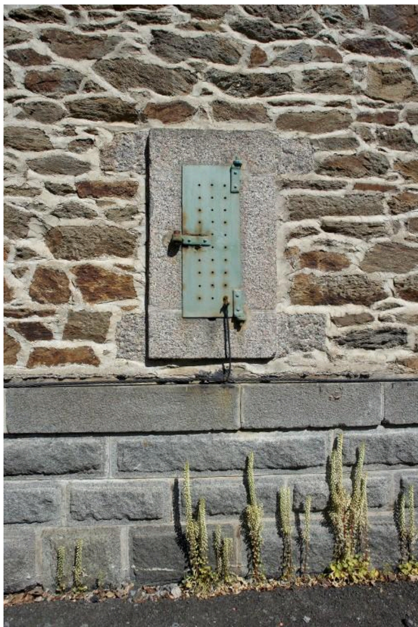
Vue de détail de la poudrière n° 1 (P1) de la vallée de Kerhuon : évent d'aération doté de son volet métallique (état en 2009)
