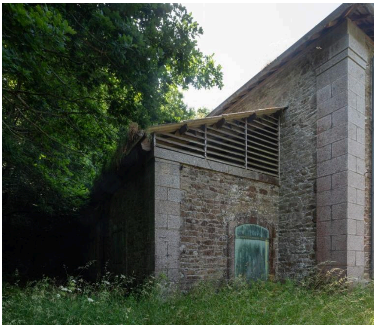
Vue de détail de la poudrière n° 3 (P3) de la vallée de Kerhuon : sas d'entrée nord (état en 2025). Le sas a ultérieurement été couvert en appentis
