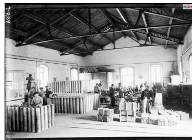
Vue intérieure d'un atelier en 1916 : à gauche, les grosses douilles ; à droite, des caisses de munitions. L'équipe est mixte. Cet atelier à charpente métallique et ouvertures en arc segmentaire est desservi par une voie ferrée étroite Repro. Auteur inconnu, Phot. Victor Dietsch IVR53_20252910299NUC
