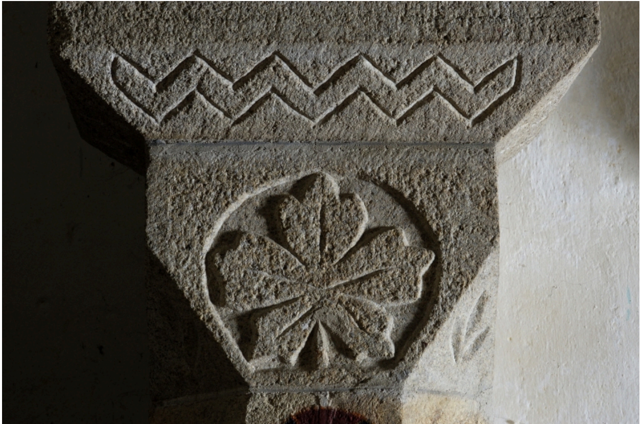
Locunolé, église paroissiale Saint-Guénoé : nef, mur ouest, chapiteau sud, état en 2004
