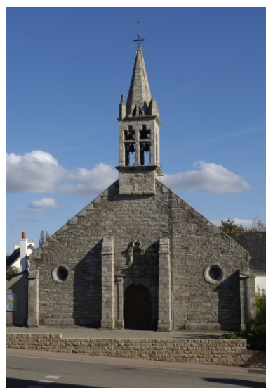
Locunolé, église paroissiale Saint-Guérolé : élévation ouest, état en 2004 Phot. Bernard Bègne IVR53_20042900220NUCA
