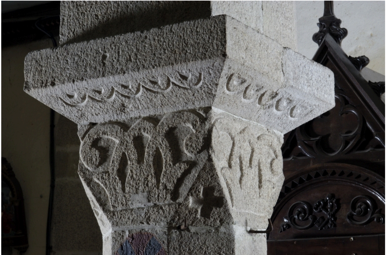
Locunolé, église paroissiale Saint-Guénoé : nef, chapiteau 8, état en 2004
