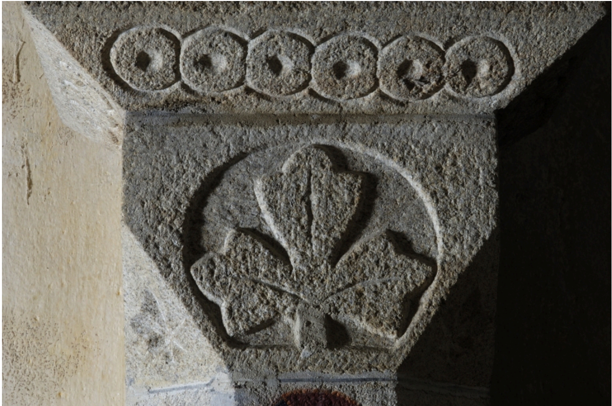
Locunolé, église paroissiale Saint-Guénoé : nef, mur ouest, chapiteau nord, état en 2004
