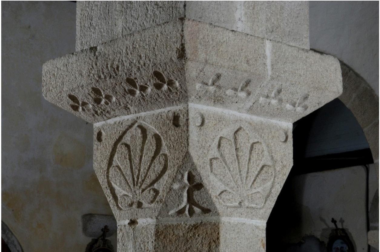
Locunolé, église paroissiale Saint-Guénoé : nef, chapiteau 3, état en 2004
