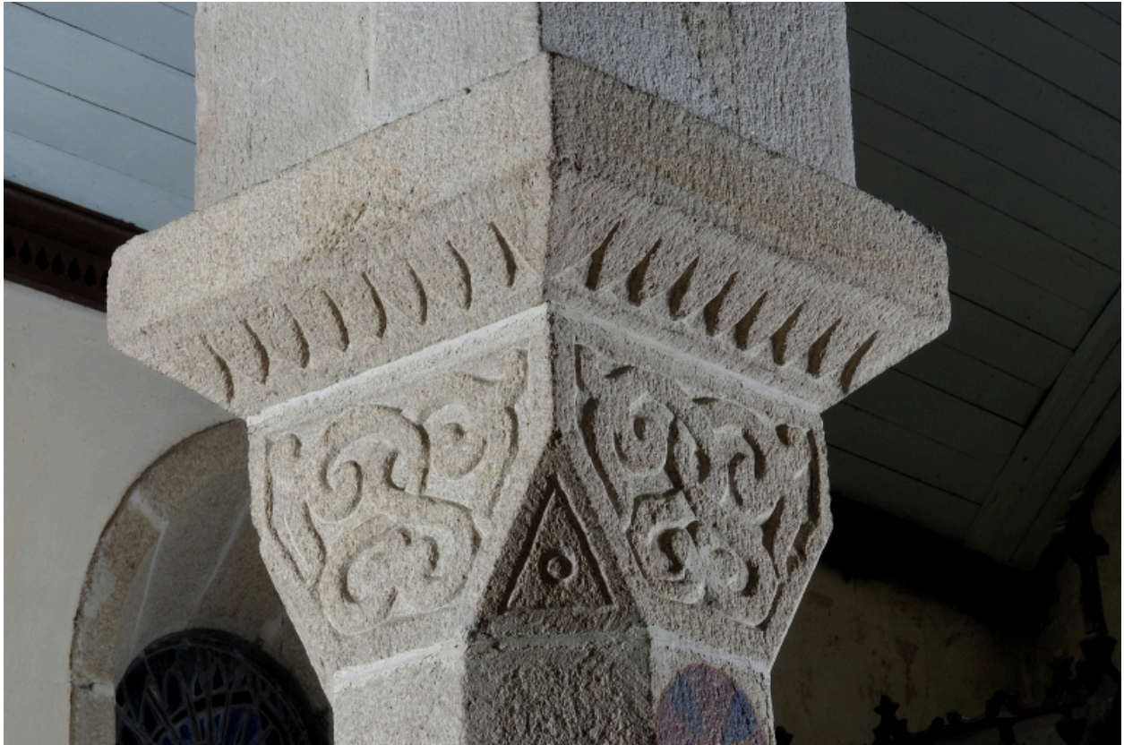
Locunolé, église paroissiale Saint-Guénoé : nef, chapiteau 4, état en 2004
