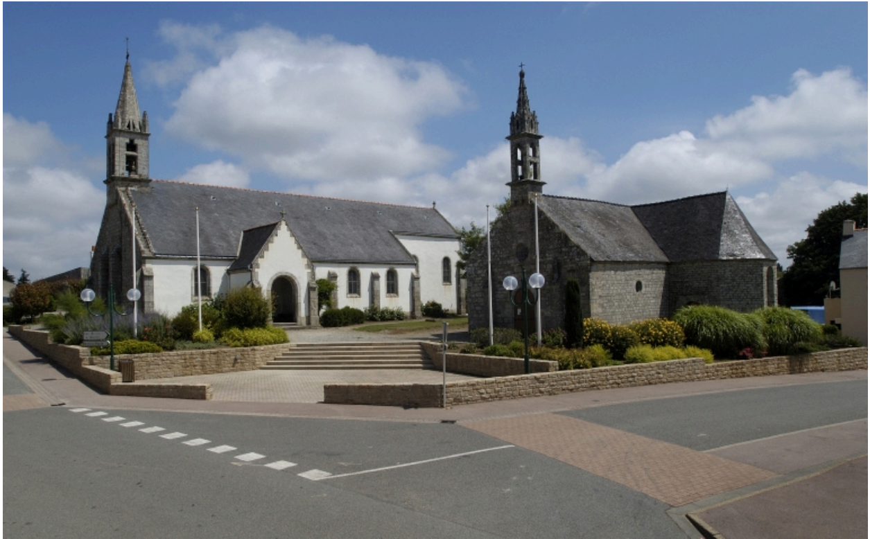
Locunolé, église paroissiale Saint-Guénoùlé : vue générale sud, état en 2004
