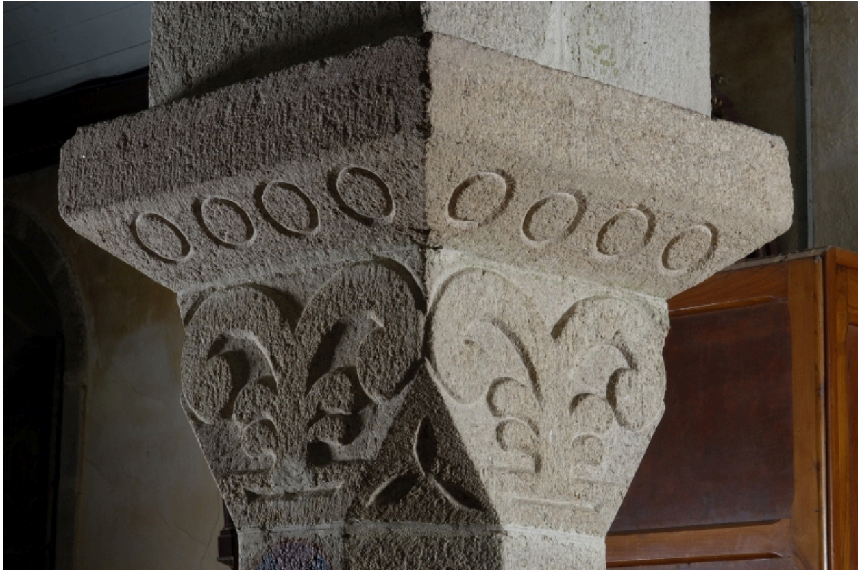
Locunolé, église paroissiale Saint-Guénoé : nef, chapiteau 6, état en 2004
