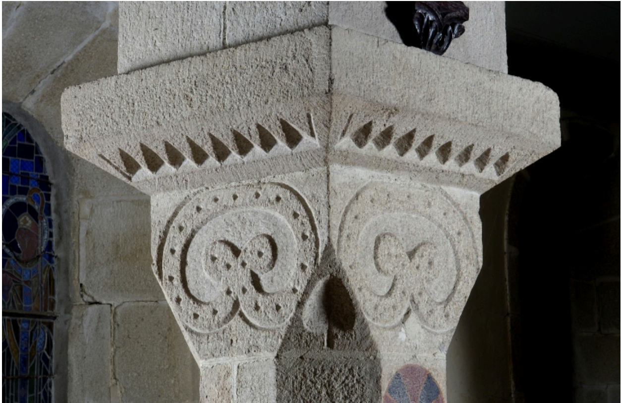
Locunolé, église paroissiale Saint-Guénoùlé : nef, chapiteau 1, état en 2004
