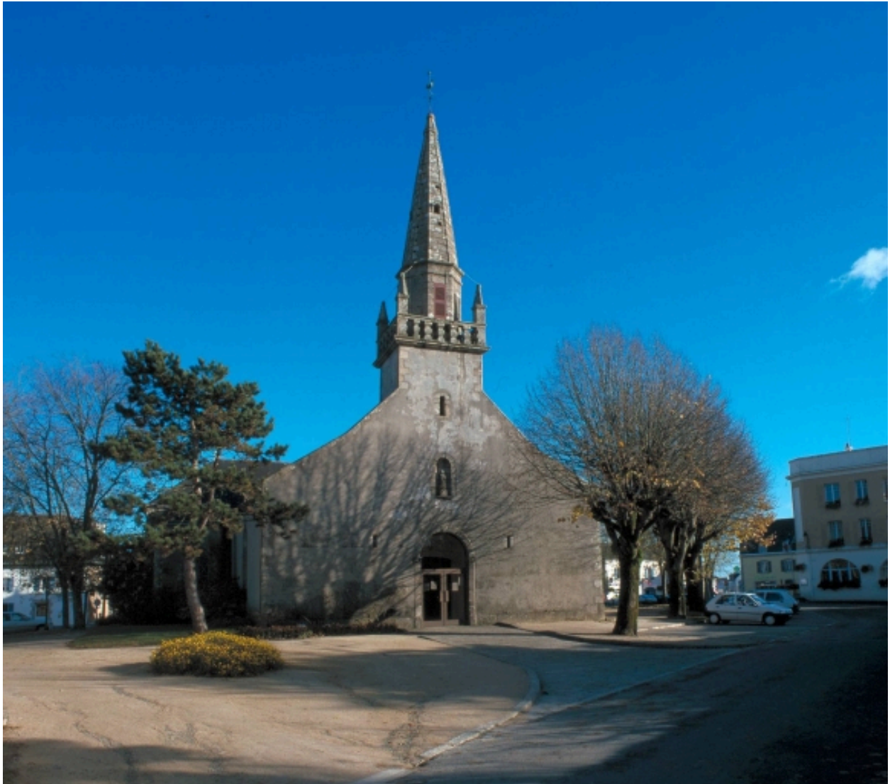
Clohars-Carnoët, église paroissiale Notre-Dame : vue générale ouest, état en 2000
