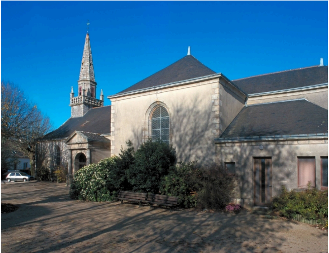
Clohars-Carnoët, église paroissiale Notre-Dame : vue générale sud, état en 2000
