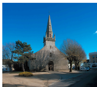
Clohars-Carnoët, église paroissiale Notre-Dame : vue générale ouest, état en 2000 Phot. Xavier Scheinkmann IVR53_20002900692XA
