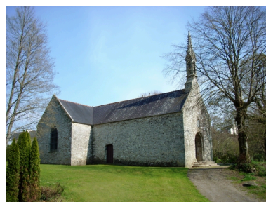
Elliant, chapelle Notre-Dame-de-Bon-Secours : vue générale nord-ouest Phot. Gwénaél Fauchille IVR53_20082905723NUCA
