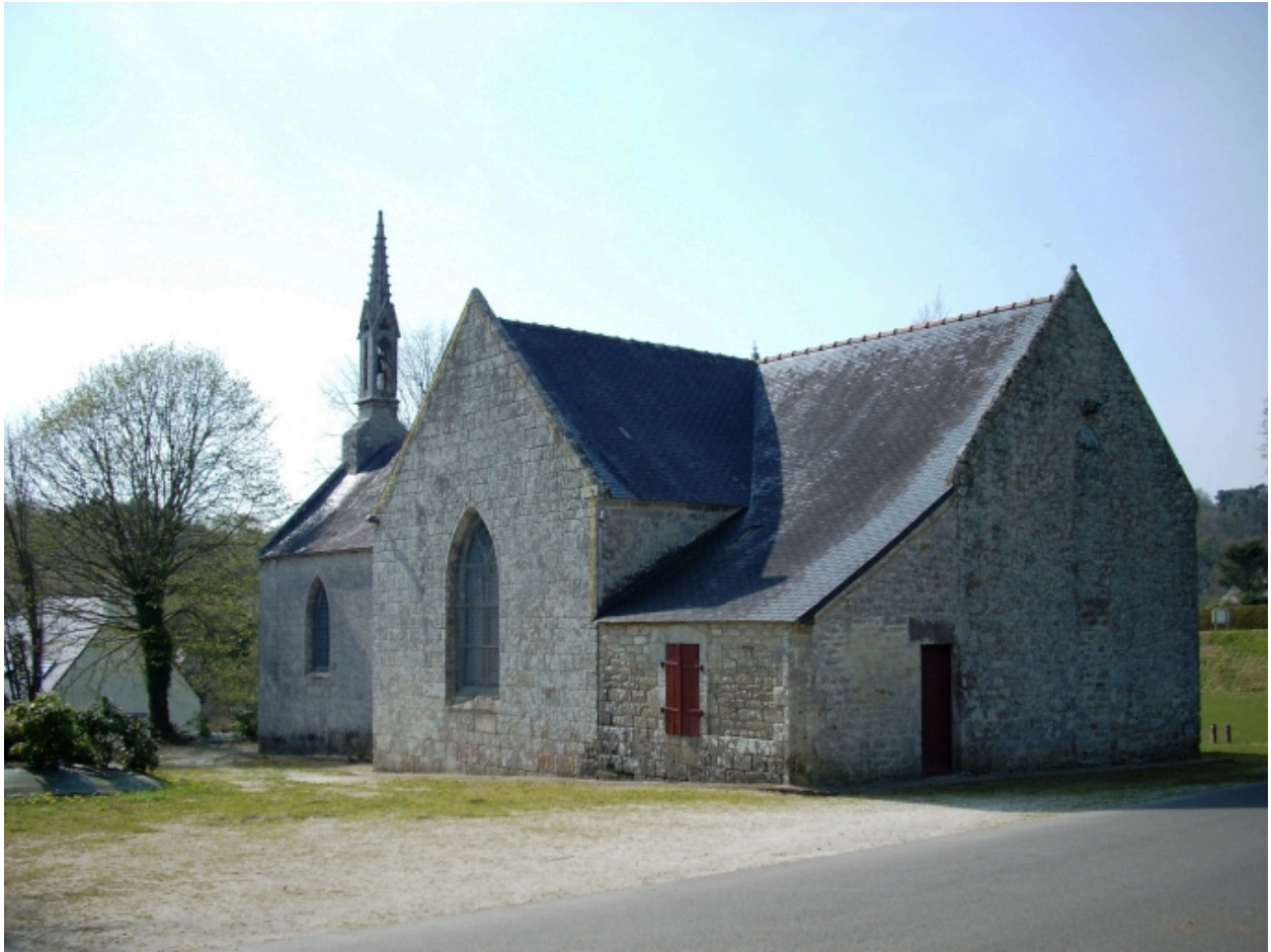
Elliant, chapelle Notre-Dame-de-Bon-Secours : vue générale sud-est
