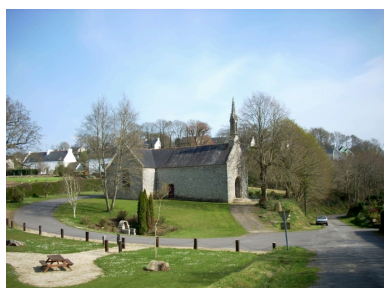
Elliant, chapelle Notre-Dame-de-Bon-Secours : vue de situation depuis le nord-ouest Phot. Gwénaél Fauchille IVR53_20082905721NUCA
