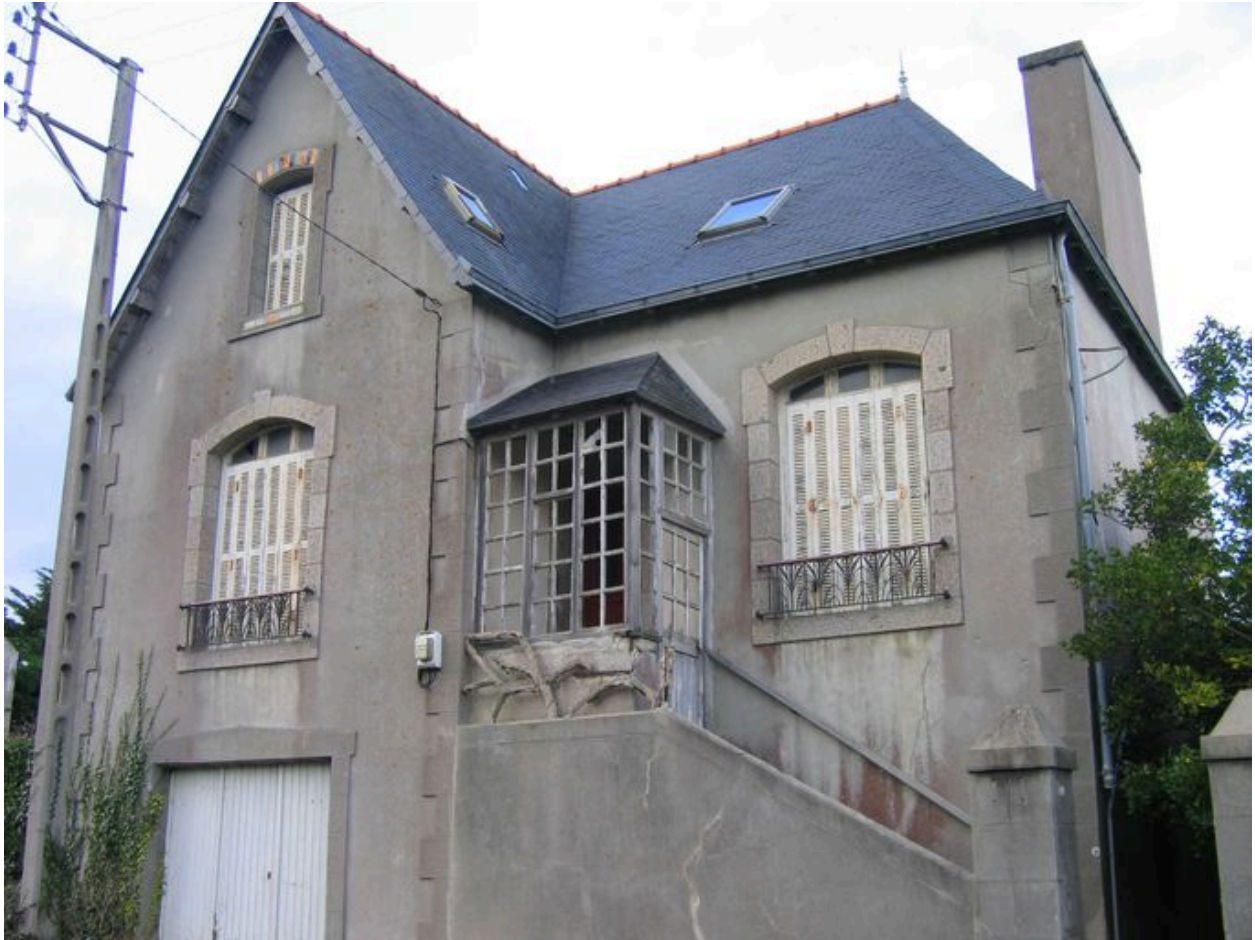
Vue d'ensemble de la maison du constructeur naval Bernard Hugo
