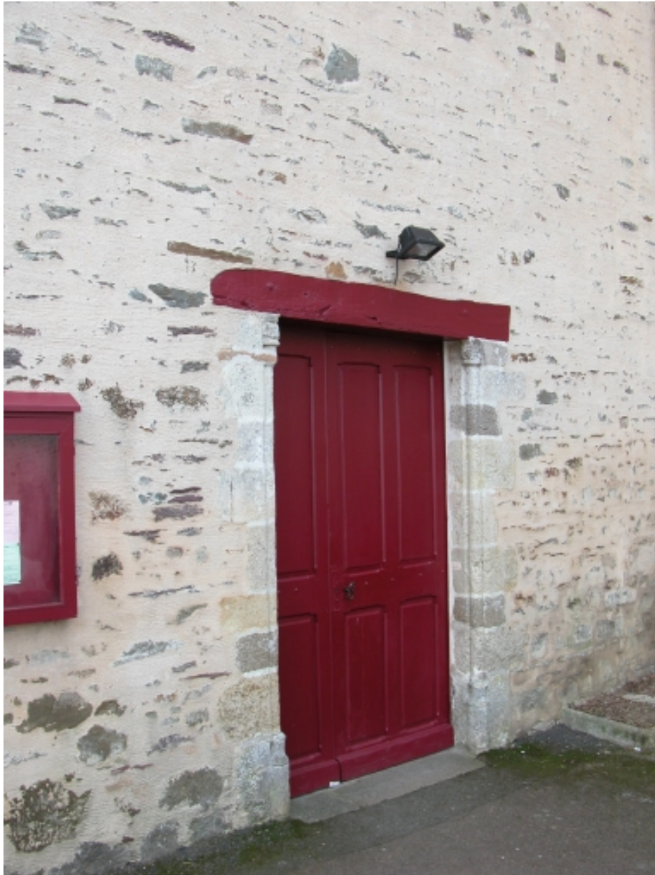
Porte du bras de transept nord
